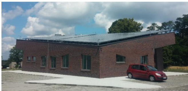
Rys. 7. Budynek przychodni w Przysowicach ze 126 panelami fotowoltaicznymi o mocy 260W
