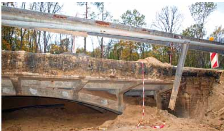
Fot. 48. Żelbetowy most w miejscu, gdzie został wybudowany czyli w okolicach Łabuń koła Zamościa w ciągu drogi krajowej Lublin-Hrebenne.
