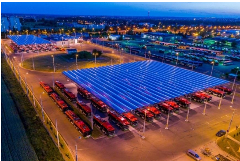
Rys. 6. Zajeźdnia trolejbusowa w Lublinie
