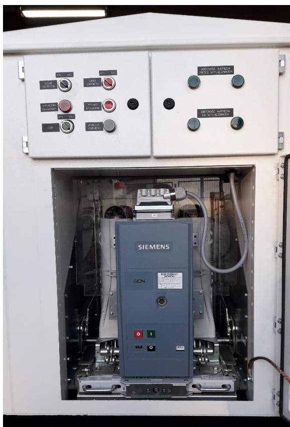
Rys. 5. Bocznik SN z synchronizacją 15 kV PGE Dystrybucja 2019; opracowanie własne
