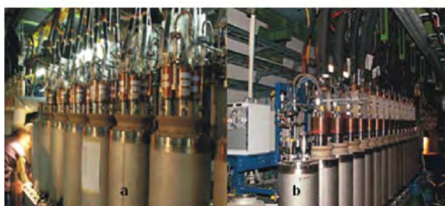
Rys. 6. DBF przepustów prądowych 600 A a) i 13 kA b)
