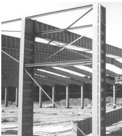
Rys. 2.3. Konstrukcja ramowa hali z blachownic trapezowymi
