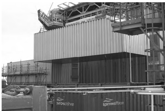
Rys. 2.1. Moduł pomieszczenia mieszkalnego wykonany z blachy fałdowej
