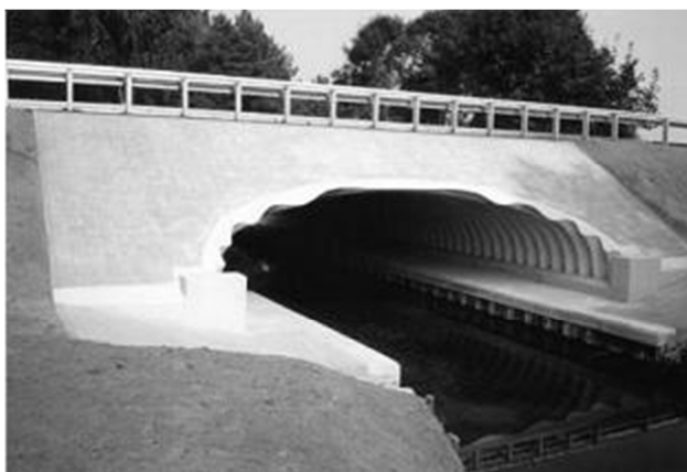
Rys. 2.5. Przepust drogowy z wykorzystaniem blachy falistej [64]
