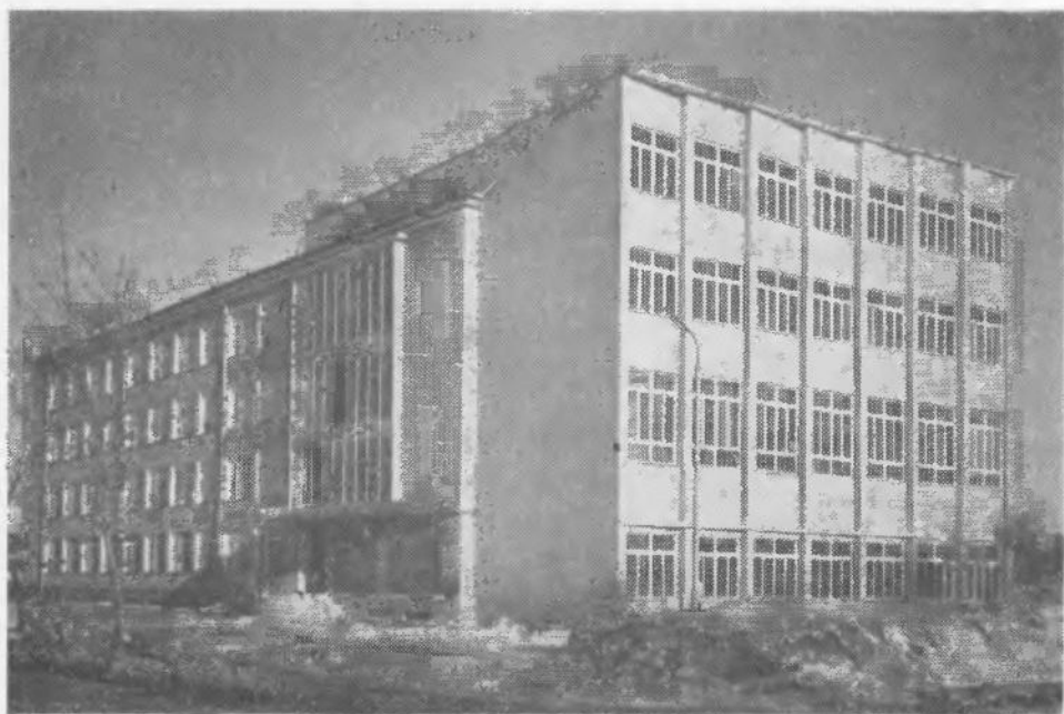
Budynek Wydziału Elektrycznego przy ul. Nadbystrzyckiej
