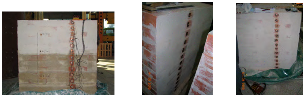
Rys. 6.1. Zdjęcia badanego muru ceglanego w Instytucie Budownictwa we Wrocławiu.
