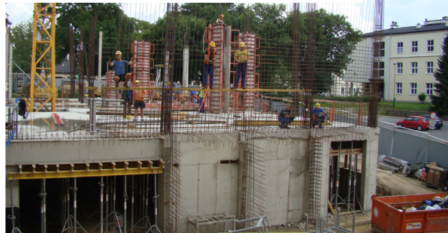
WICA – zbrojenia ścian I piętra, lipiec 2011 Źródło: archiwum WBiA
