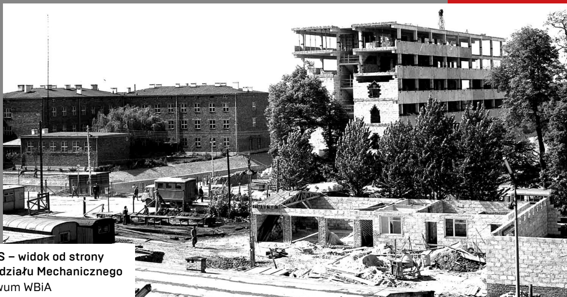
Budowa siedziby Wydziału przy ul. Nadbystrzyckiej 40, konstrukcja z zastosowaniem ramy H
