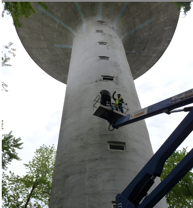
Pracownicy KKB podczas ekspertyzy konstrukcyjnej wieży ciśnień
