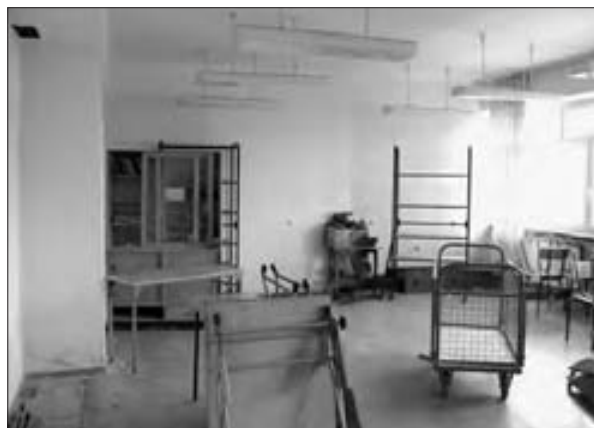
Piętro III – przygotowania do prac remontowych
