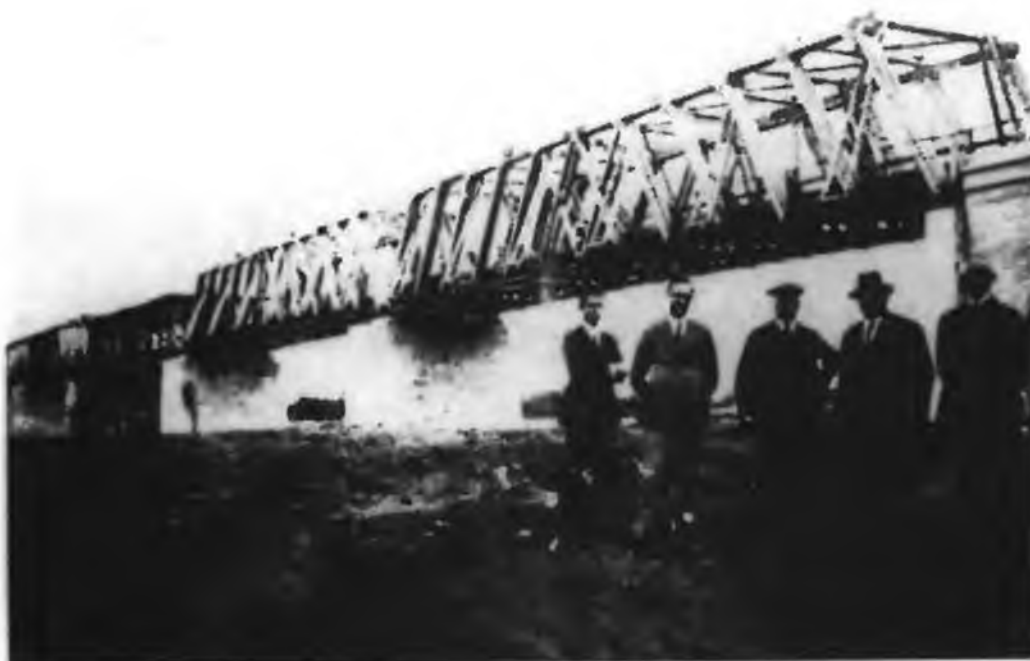
Rys. 3 Most na Sanie pod Zarzeczem
