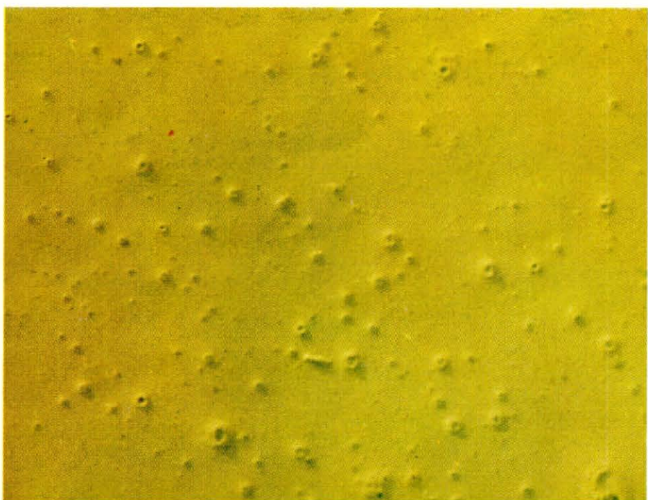
4. Kratery przebijające powłokę do podłoża.
