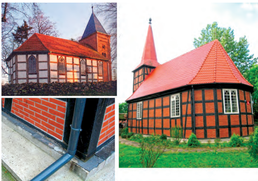
Il. 5. Cieszyno, pow. węgorzewski na Pomorzu Zachodnim. Kościół z 1780 roku. Dawny szkielet wypełniono cegłą klinkierową, która wraz z nową dachówką nadaje zabytkowi „nowoczesny” wygląd, który jest sztywny i martwy. Warto zwrócić uwagę jak „fachowo” wykonano betonowy wystający cokół i nakryto go papą, która jest wspaniałym zbiornikiem wody, dobrze nawodniającym drewnianą podwalinę. Fot. J. Tajchman
