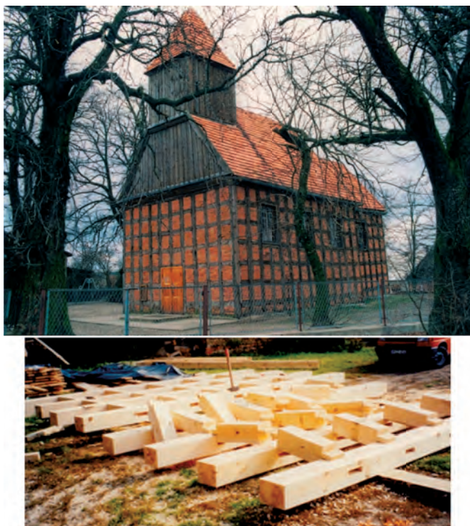
Il. 3. Chojna, pow. wągrowiecki w Wielkopolsce. Kościół szkieletowy z 1776 r. „uległ” tzw. konserwacji polegającej na jego zniszczeniu. Niewielkie uszkodzenia dolnych partii stały się powodem rozebrania świątyni i postawienia „kopii” z nowego odżywionego drewna, które szybko ulegnie zniszczeniu przez owady. Fot. IZiK UMK.
