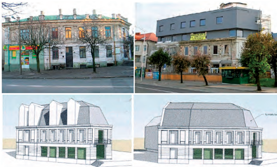
Il. 2. Mława, Województwo Warmińsko-Mazurskie. Przykład jak można zniszczyć ciekawy budynek podwyższając go o dwie kondygnacje. W rzeczywistości było to już niemożliwe, co udowodniły projekty rysunkowe. Jeden projektant zrezygnował, a drugi podjął się tego „wiekopomnego dzieła” projektując potworka architektonicznego.
