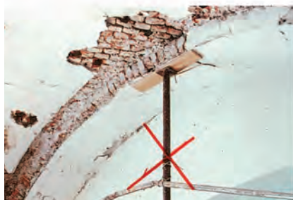
SCHEMAT ZNISZCZENIA SKLEPIENIA PO WYPRÓŻNIENIU PACH SKLEPIENNYCH
