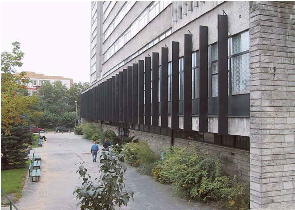
Elewacja północno-zachodnia budynku Wydziału Mechanicznego
