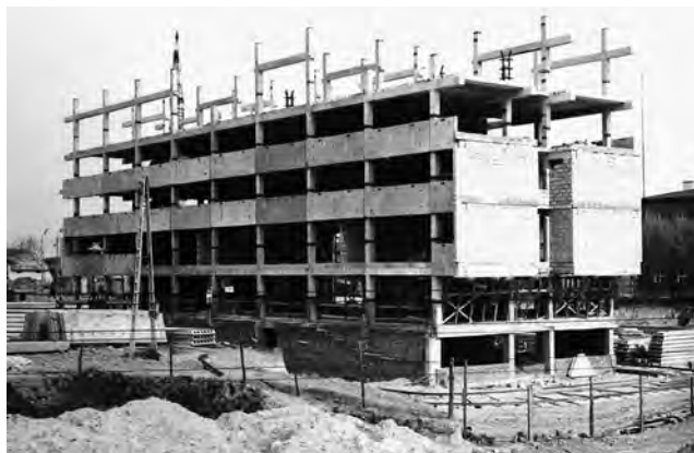
Konstrukcja budynku Wydziału Budownictwa i Architektury – rama H – 1973 r. (fot. arch.)
