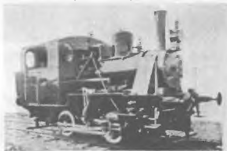
Ryc. 10. Parowóz towarowy Ty45-1 (nr fabr.1579) zbudowany w Fabloku w 1946 roku według zmodernizowanej dokumentacji parowozu Ty37.
