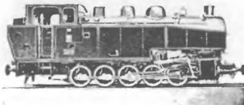
Ryc. 6. Parowóz górnośląski typu WIE na tor 785 mm z 1929 roku.
