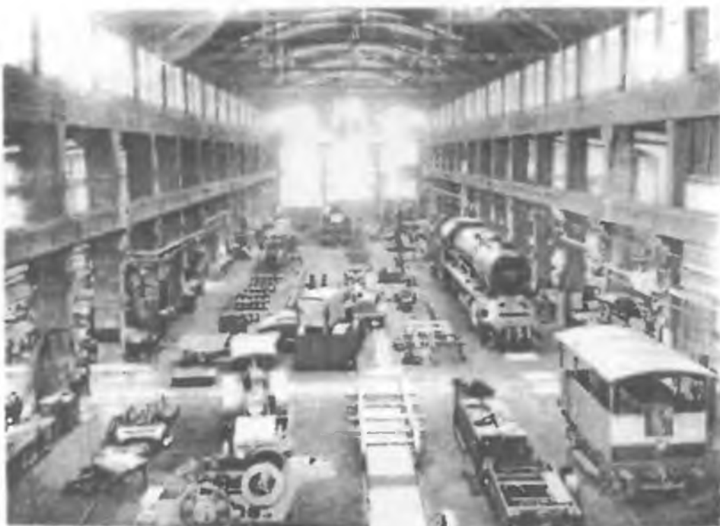
Ryc. 2. Wnętrze hali montażowej w FABLOK-u prawdopodobnie w 1932 r. Widać na ukończeniu parowóz Pt31 i lokomotywę spalinową G1C.
