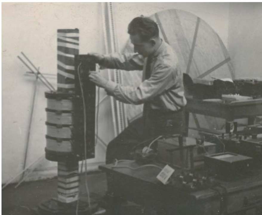
Dyplomant T. Janowski montuje sondy do pomiaru rozkładu strumienia magnetycznego w modelu transformatora bezjarzmowego
