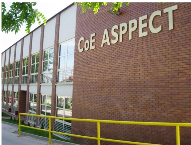
Rys. 1. Budynek Centrum Doskonałości ASPPECTw Lublinie
