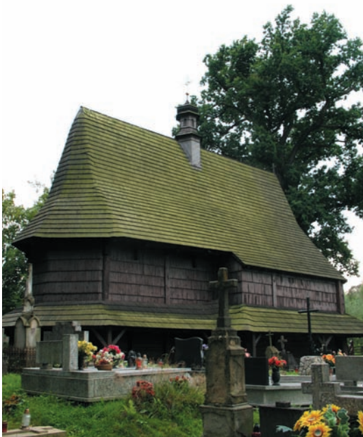
20. Kościół w Lipnicy Murowanej. Fot. A. Siwek, NID-OT w Krakowie
