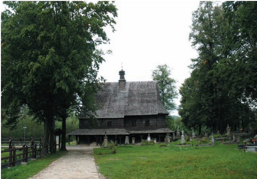
19. Kościół w Lipnicy Murowanej. Fot. A. Siwek, NID-OT w Krakowie
