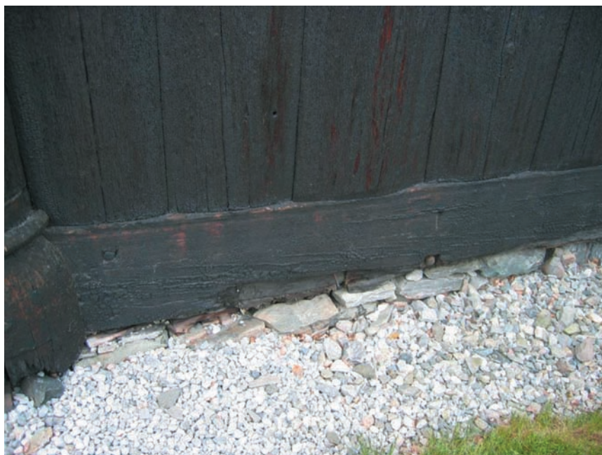
16. Kościół słupowy w Urnes, brakujące zakończenie podwaliny w północnej ścianie nawy. Fot. O. Storsletten
