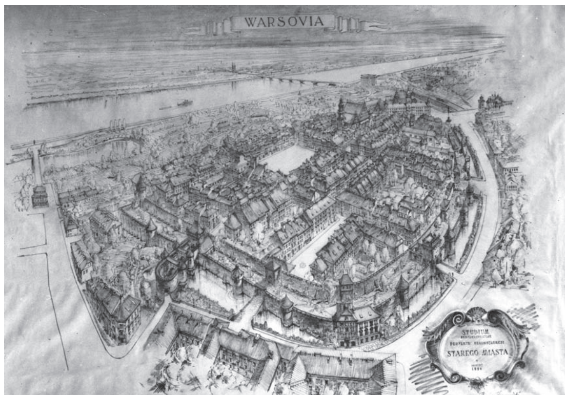
10. Panorama, koncepcja rekonstrukcji, inż., arch. Z. Krawczyk IV 1954 r. (Archiwum Zakładowe MWKZ)
