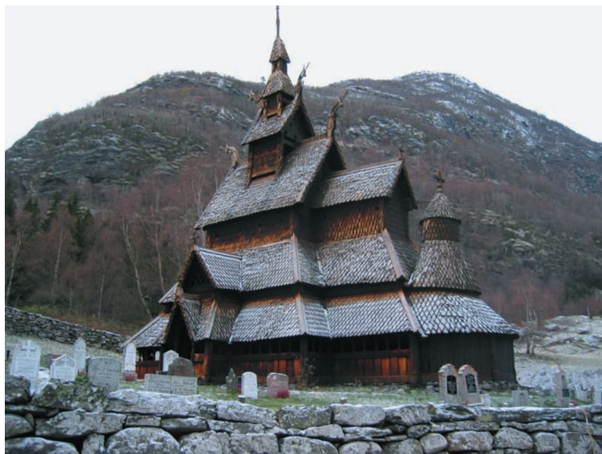
18. Kościół słupowy w Borgund oglądany od strony południowo- -wschodniej. Fot. O. Storsletten
