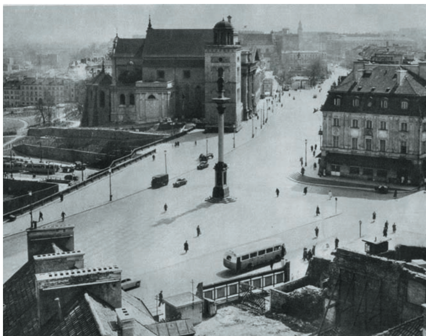
8. Plac Zamkowy w trakcie odbudowy – ok. 1952 r. Kopia: Teka Konservatorska 1956 r., il. 121
