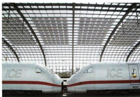
Rysunek 2.3.14. Ogniwa wbudowane w dach dworca kolejowego w Berlinie (Oszczak, 2012)
