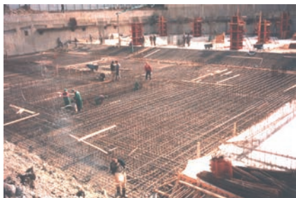
Rys. 4. Realizacja płyty fundamentowej w budynku PFC w Poznaniu
