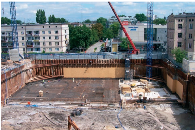
Rys. 4. Wykop w terenie zabudowanym w obudowie z grodzic stalowych – [fot. AARSLEF]
