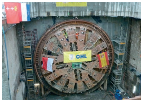
Rys. 2. Widok szyby docelowego i czoła (noża) maszyny drążącej (Fot. D. Ganew)
