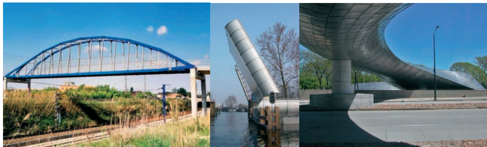
Rys. 18. Obiekty mostowe z zaawansowanych technologicznie materiałów: (a) kładka z kompozytu FRP; (b) most ze stopu aluminium; (c) kładka ze stali nierdzewnej
