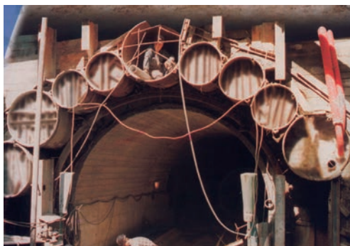
Rys. 9. Widok konstrukcji pipe roofing w trakcie realizacji tunelu wentylacyjnego [5]
