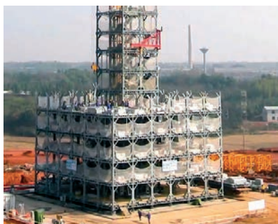
Rys. 16. Budowa 30-sto piętrowego hotelu w Chinach [22]
