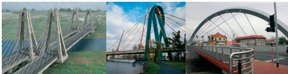
Rys. 20. Przykłady nieuzasadnionej dominacji formy mostu nad jego funkcją
