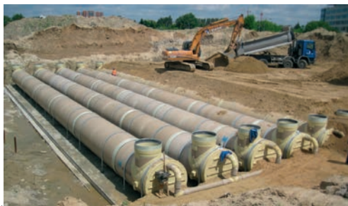
Rys. 11. Przykładowy zbiornik retencyjny do zabudowy w wykopie otwartym [13]
