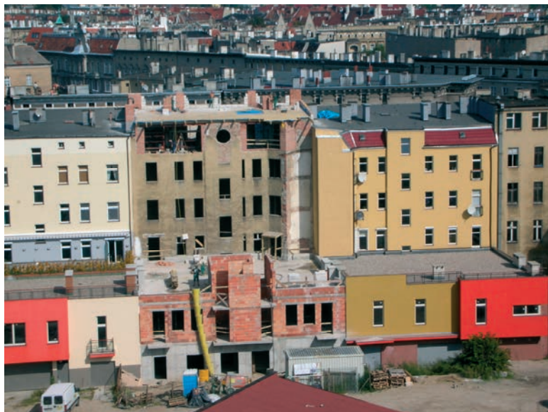
Rys. 4. Widok wnętrza kwartału 22 w Szczecinie poddanego gruntownym pracom rewitalizacyjnym połączonym z wyburzeniami i nową zabudową. Fot. autora
