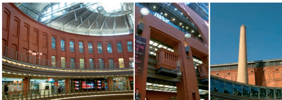
Rys. 7, 8, 9. W Starym Browarze w Poznaniu wykorzystano duże fragmenty istniejącej substancji poprzemysłowej tworząc niepowtarzalne wnętrza i zostawiając charakterystyczne znaki w przestrzeni miasta (Fot. aut.)
