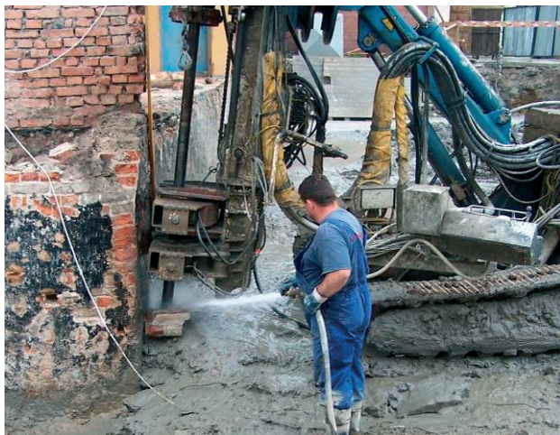
Rys. 4. Podbijanie fundamentów za pomocą iniekcji strumieniowej
