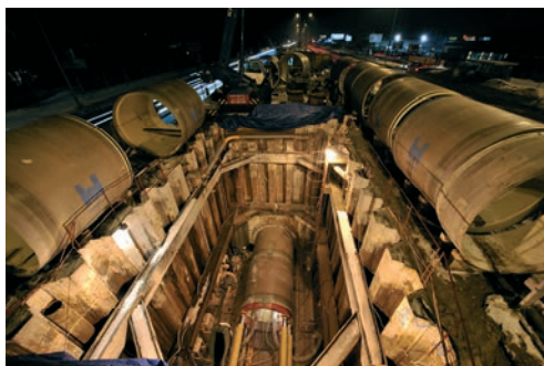
Rys. 6. Komora robocza mikrotunelu zlokalizowana w pasie rozdziału jezdni [12]
