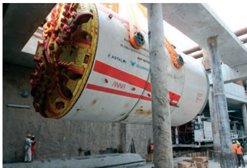
Rys. 3. Widok TBM podczas jej opuszczania do szybu startowego (Fot.D. Ganew)
