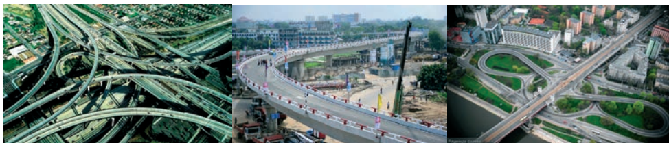
Rys. 1. Miejskie obiekty mostowe spełniające funkcje komunikacyjne: (a) węzeł; (b) estakada; (c) łącznice
