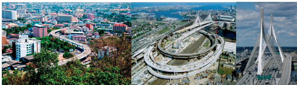
Rys. 15. Niektóre cechy techniczne mostów miejskich: (a) krzywoliniowość w planie; (b) duża szerokość; (c) dojazdy w formie „ślimaków”
