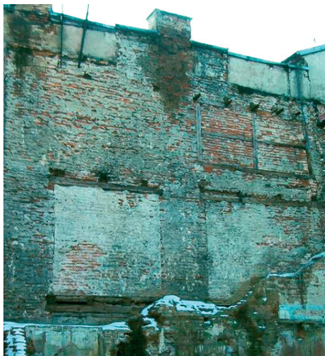
Rys. 1. Ściana budynku po rozbiórce budynku przyległego
