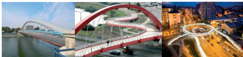
Rys. 8. Kładki promujące polskie miasta: (a) Kraków; (b) Katowice; (c) Rzeszów
