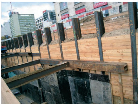
Rys. 3. Wykop w obudowie berlińskiej – wyjście ze stacji metra w Warszawie [fot. autor]
