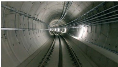
Rys. 4. Widok wnętrza tunelu II linii warszawskiego metro (Fot. D. Ganew)
