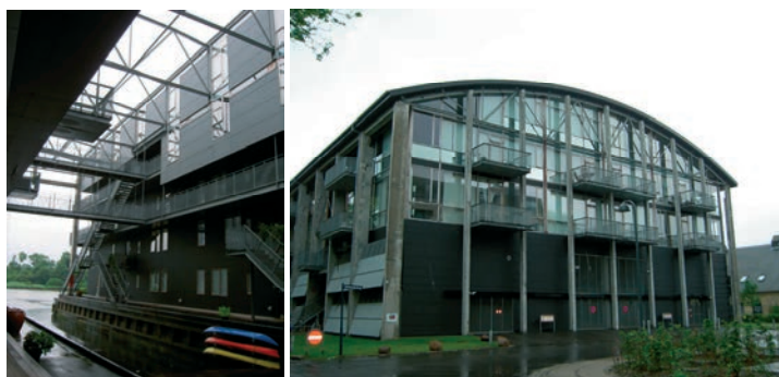
Rys. 10, 11. Obiekt Torpedohallen pozwolił na urządzenie atrakcyjnej przestrzeni wewnętrznej, służącej rekreacji mieszkańców. (Fot. aut.)
