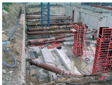
Rys. 7. Wykop z rozporami w części podziemnej budynku Andersia 2 w Poznaniu
