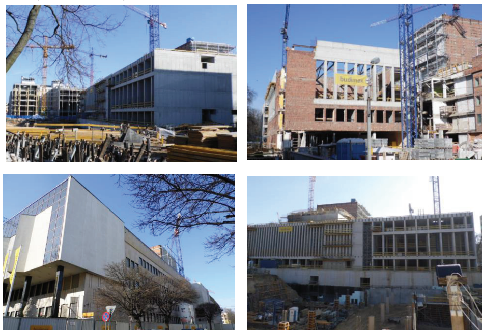
Ilustracja 93. Zdjęcia z budowy, stan – marzec 2014
