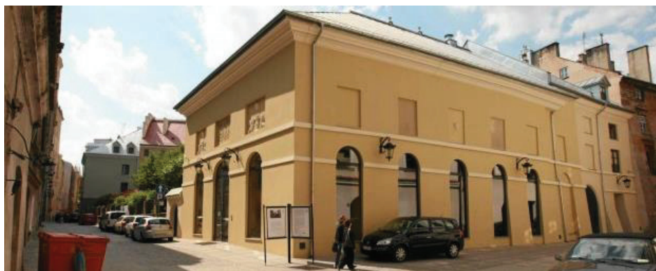
Ilustracja 87. Obiekt po renowacji
