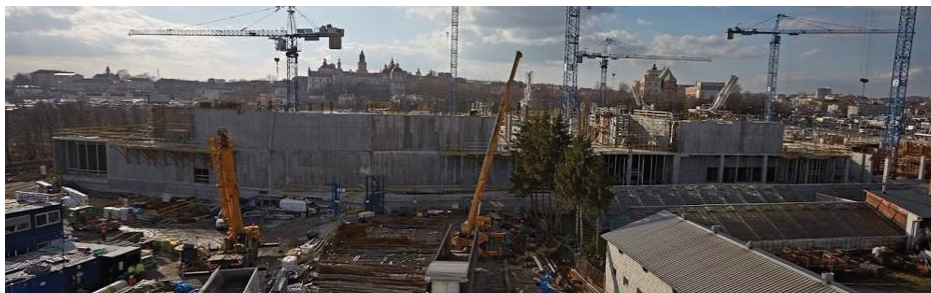
Ilustracja 104. Zdjęcie z budowy – III 2014 r.
