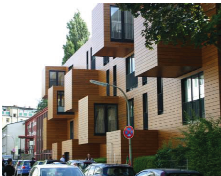
Ilustracja 20. Bogenallee Wohnen, Bogenallee 10–12, Blauroom Architekten 2003. Adaptacja istniejącego budynku biurowego z 1970 r. na mieszkania (niedaleko słynnej dzielnicy bloków Brindel)
