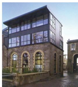
Ilustracja 28. Widok na nadbudowany apartament (Comber Mill Village)
