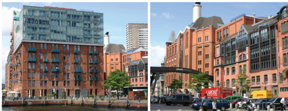
Ilustracja 18. Rewitalizacja byłych magazynów portowych – obecnie obiekty użyteczności publicznej (biura, hotele)
