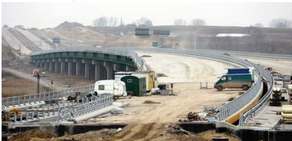
Ilustracja 109. Budowa obwodnicy miasta Lublina. Stan – luty 2014 r.
