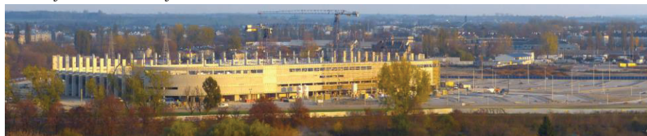
Ilustracja 95. Stadion – stan zaawansowanie realizacji – Grudzień 2013 r.
