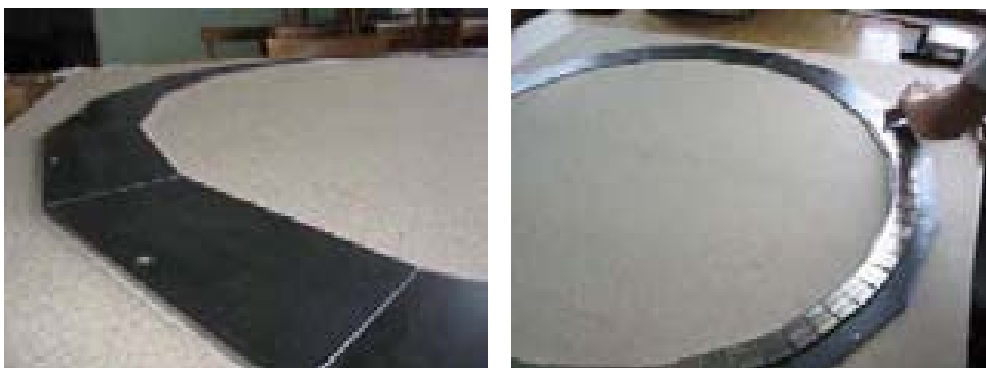
Fot.4,5 Podłoże oraz montaż magnesów
