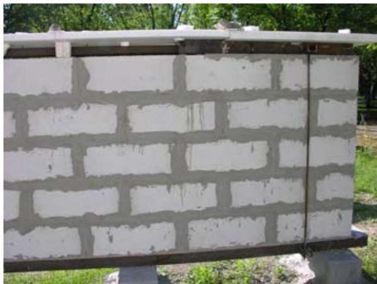
Rys. 4.2.7-7 Zatynkowane spoiny dla ułatwienia obserwacji – widok od strony północnej
