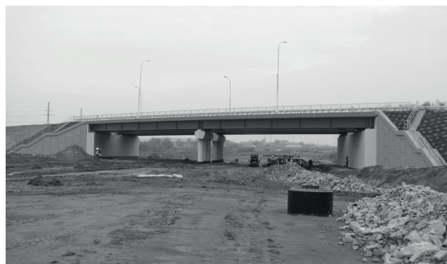
Prace końcowe budowy wiaduktu
