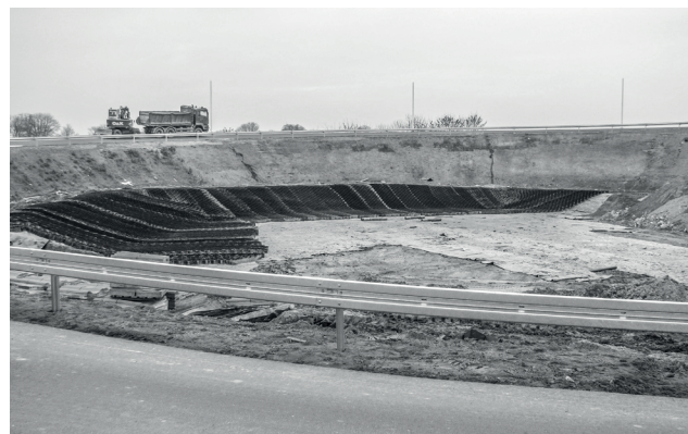
Prace przy umocnieniu skarp
