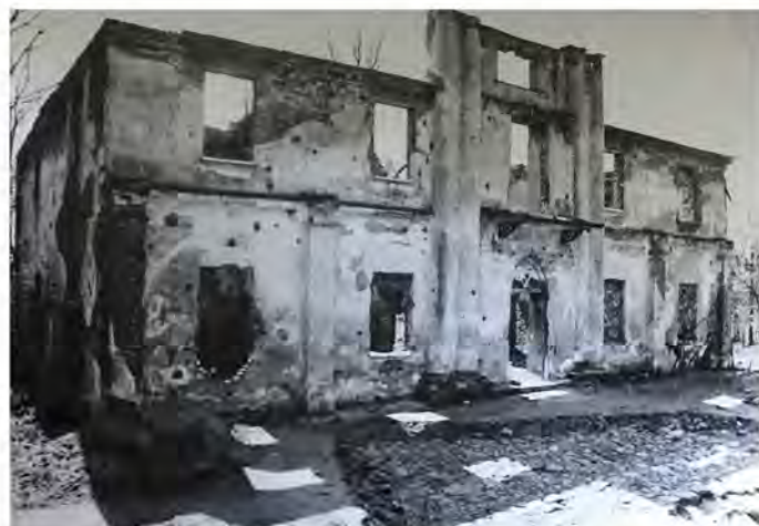
Fot. 7.3. Widok na ruiny od strony południowo-wschodniej.
