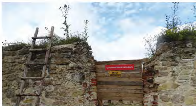
Fot. 5.10. Mur elewacji zachodniej.
