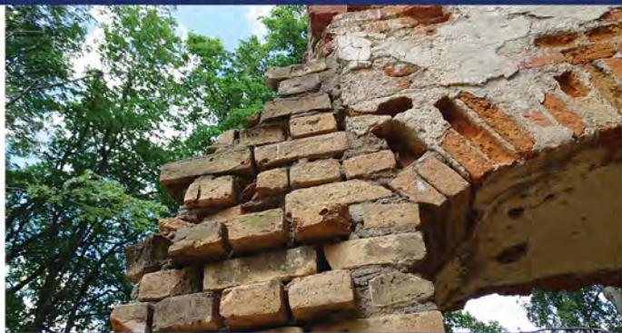
Fot. 1.9. Elewacja zachodnia.
