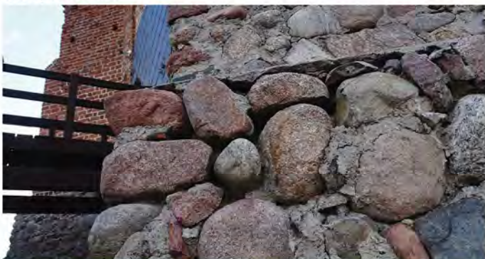
Fot. 5.10. Wieża bramna - przypora zachodnia.
