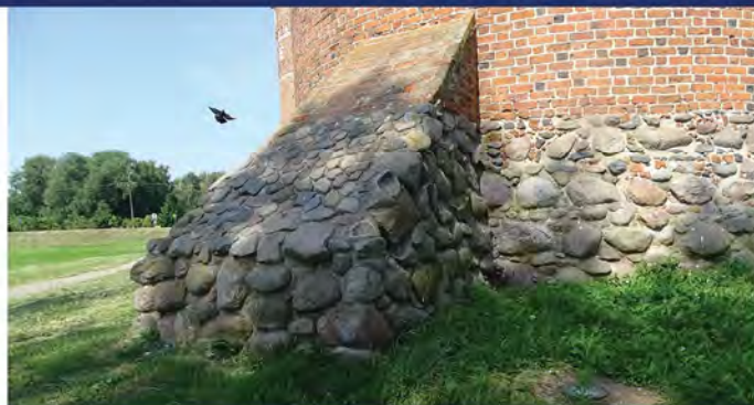
Fot. 2.9. Przypora wieży wschodniej.
