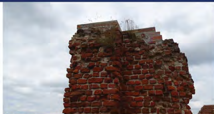
Fot. 6.10. Ściana południowa.
