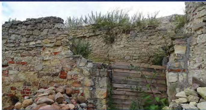
Fot. 5.7. Mur elewacji północnej.
