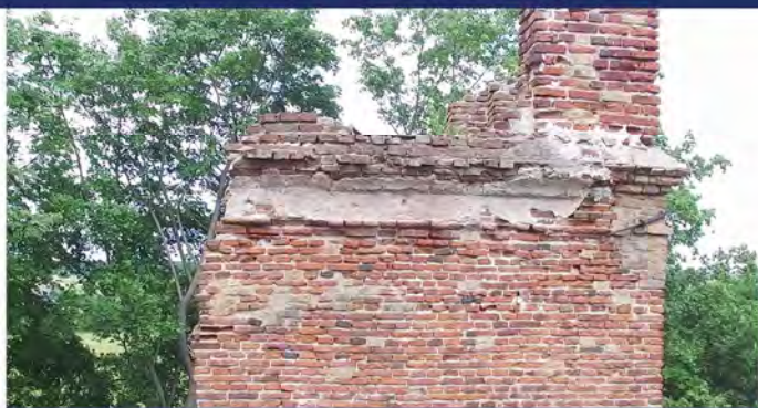
Fot. 1.14. Korona murów zamku.
