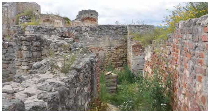
Fot. 4.25. Mury w skrzydle zachodnim zamku górnego.
