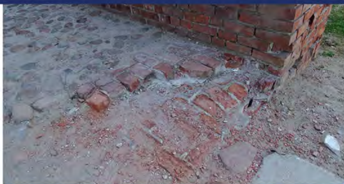
Fot. 2.14. Elewacja zachodnia.
