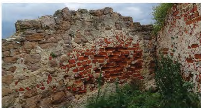
Fot. 5.11. Mur elewacji południowej
