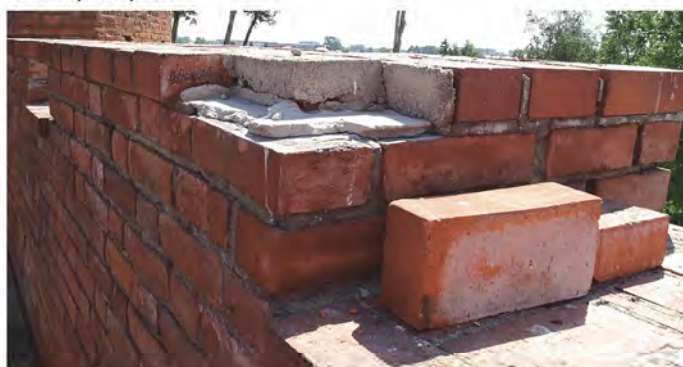
Fot. 2.13. Korona muru południowego.
