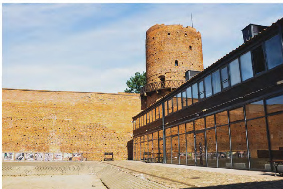
Fot. 2.5. Widok z punktu widokowego na wieży bramnej na okolicę Czerska.
