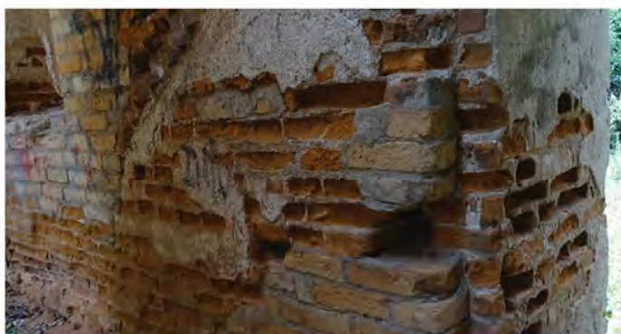
Fot. 1.11. Wnętrze klatki schodowej.
