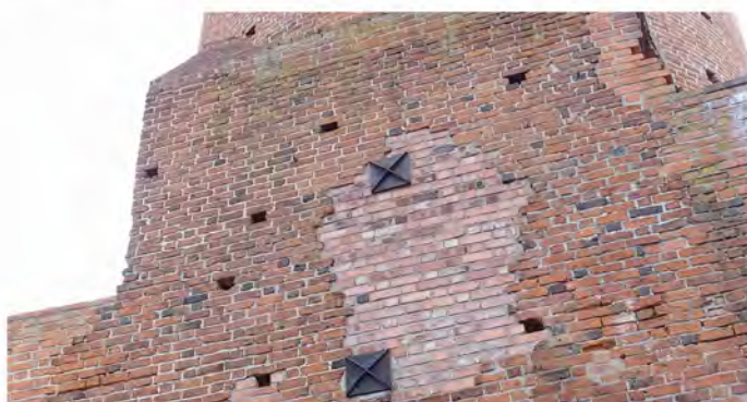
Fot. 3.14. Wieża zachodnia.
