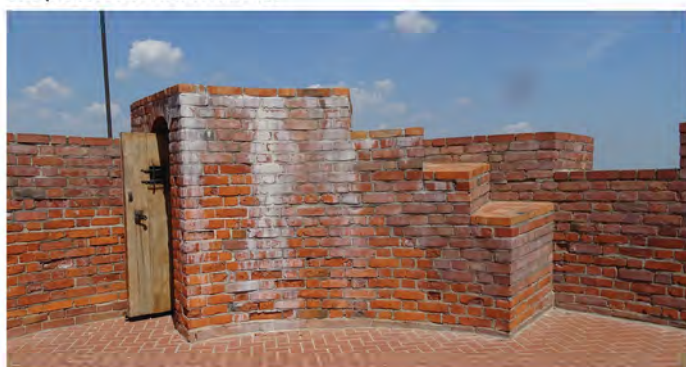
Fot. 2.12. Korona wieży.
