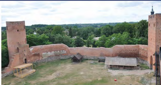
Fot. 3.25. Drewniana zabudowa na dziedzińcu.
