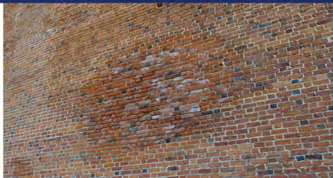
Fot. 2.8. Mur zachodni zewnętrzny.
