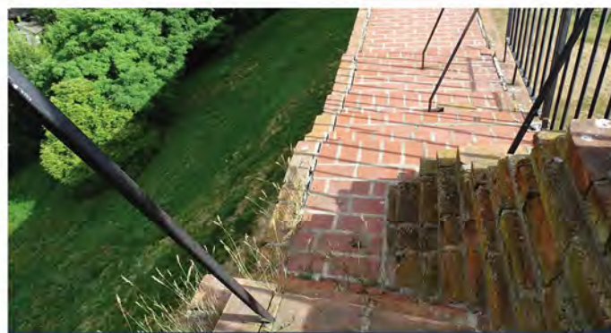
Fot. 3.9. Korona muru wschodniego.
