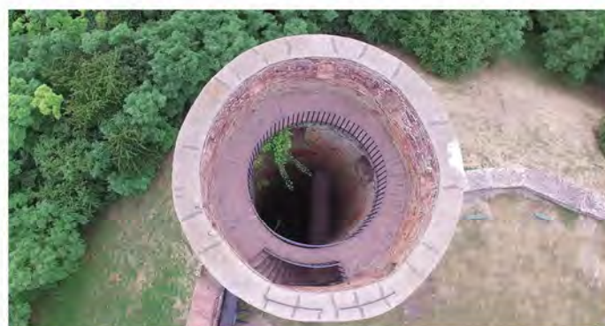
Fot. 3.15. Korona wieży południowej.
