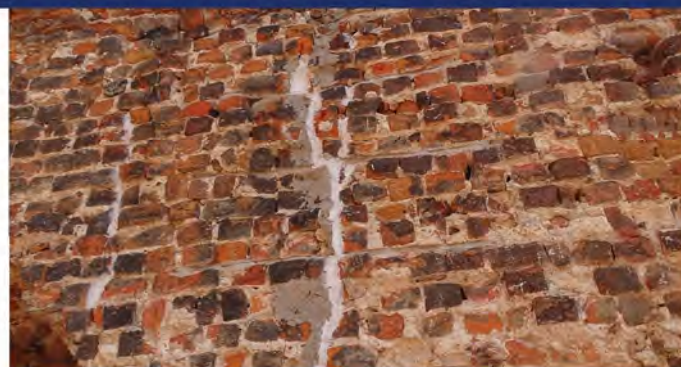
Fot. 5.15. Mur północno-wschodni.
