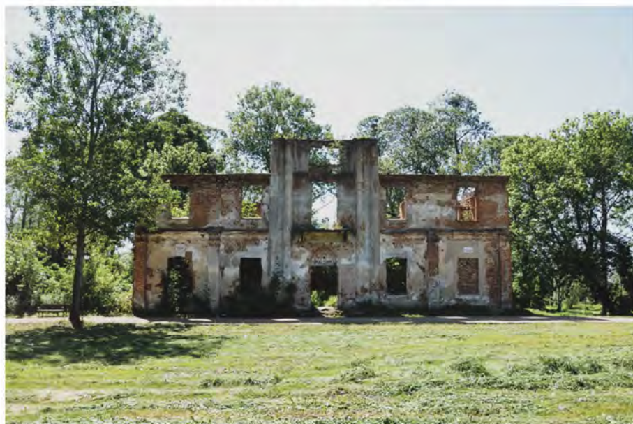
Fot. 7.6. Widok na elewację frontową - północną.
