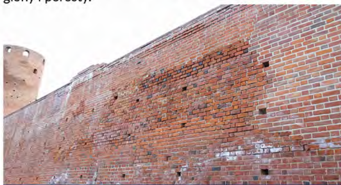
Fot. 3.8. Mur wschodni.
