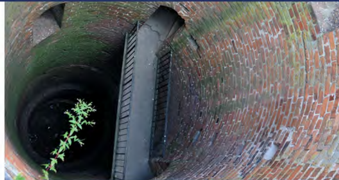
Fot. 3.26. Wnętrze niezagospodarowanej wieży południowej.
