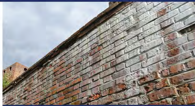
Fot. 3.7. Mur obwodowy północny.
