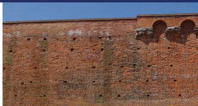
Fot. 2.15. Mur zachodni wewnętrzny.
