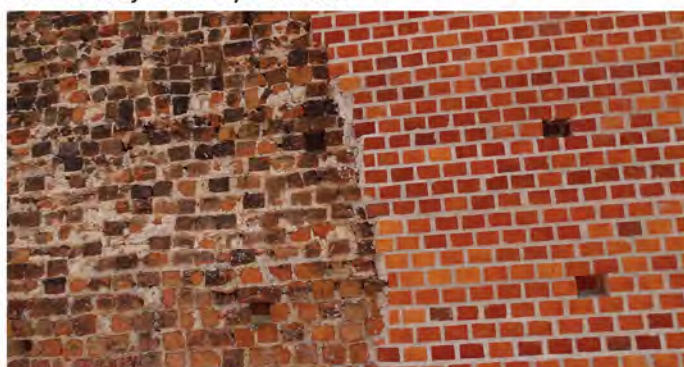
Fot. 5.16. Mur północno-wschodni.
