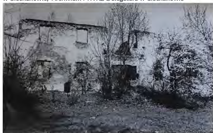
Fot. 7.4. Elewacja południowa. Autor: A. Juszcak, 1980, Źródło: T. Bartosiewicz, A. Juszcak,
