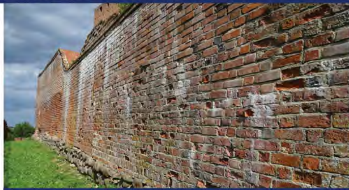
Fot. 3.6. Mur obwodowy północny.
