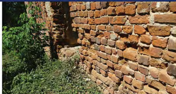
Fot. 7.14. Mur elewacji południowej.
