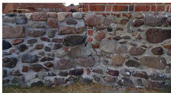
Fot. 3.11. Mur południowy.
