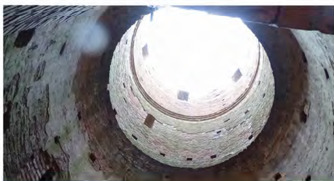
Fot. 3.10. Wieża zachodnia.
