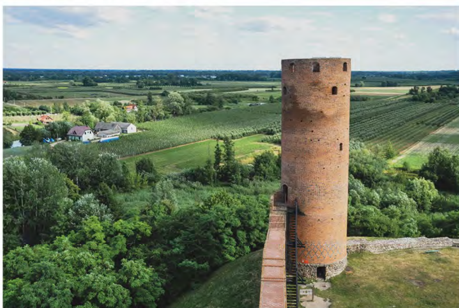
Fot. 3.5. Widok z punktu widokowego na wieży bramnej na okolicę Czerska.
