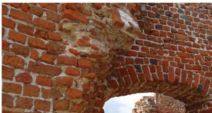
Fot. 6.11. Północna ściana zewnętrzna.
