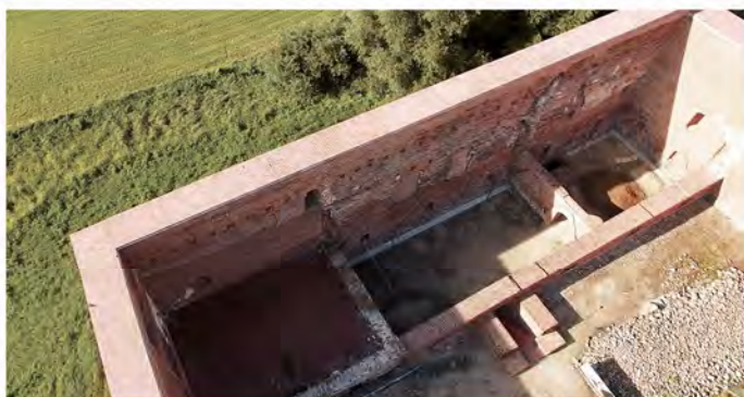
Fot. 2.22. Piwnice przy Domu Dużym.
