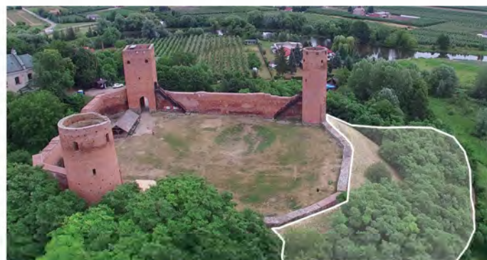
Fot. 3.30. Niezabezpieczony teren na wzgórzu południowym.
