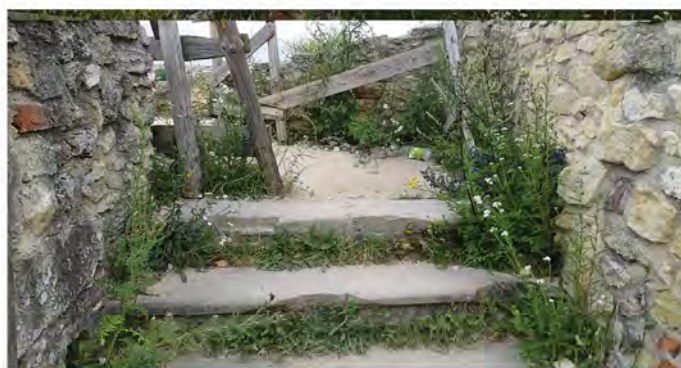
Fot. 5.12. Mur elewacji północnej.
