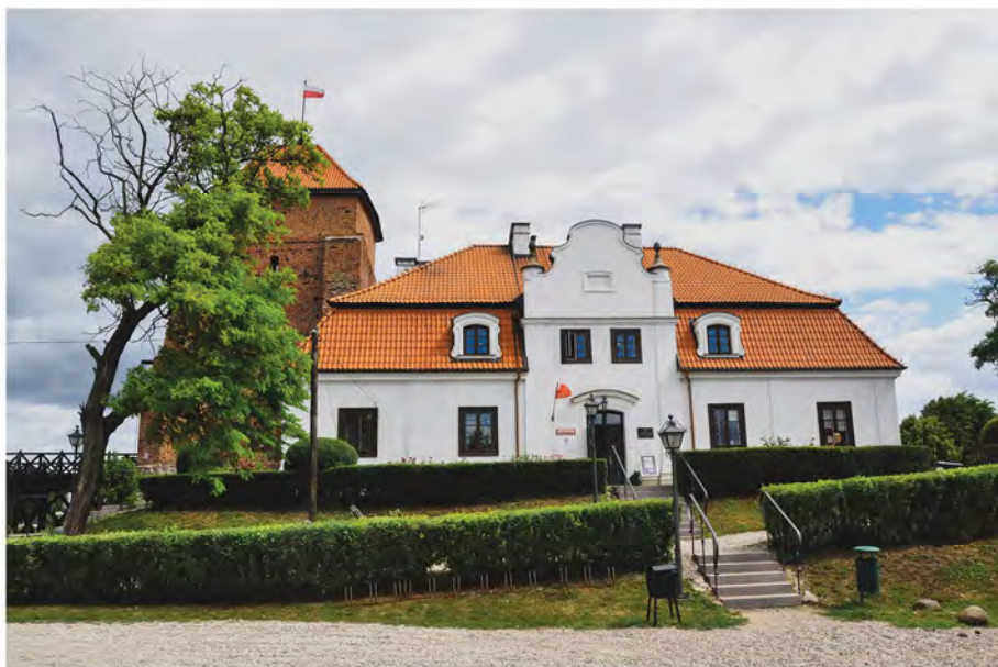
Fot. 5.5. Widok na budynek kancelarii od strony południowej.
