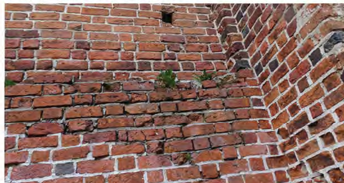
Fot. 5.11. Wieża bramna.
