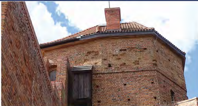
Fot. 5.8. Wieża bramna.
