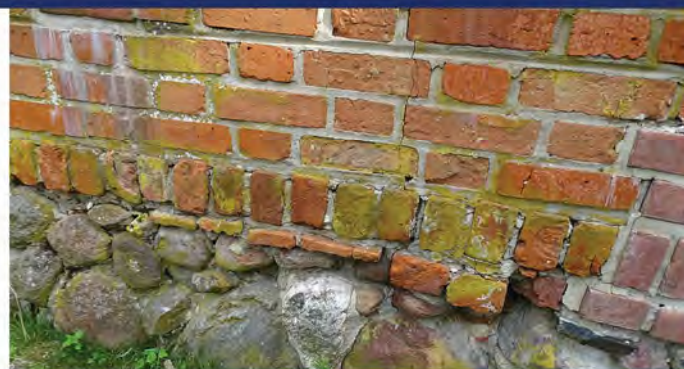
Fot. 3.13. Mur obwodowy północny.
