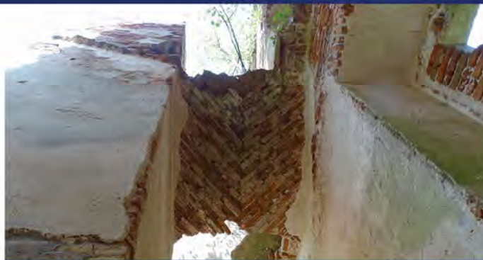
Fot. 1.10. Wnętrze klatki schodowej.
