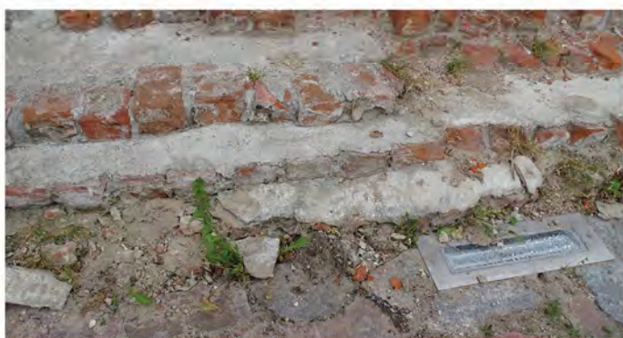
Fot. 6.19. Elewacja południowa.
