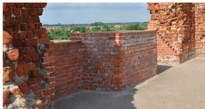
Fot. 6.14. Ściana południowa.
