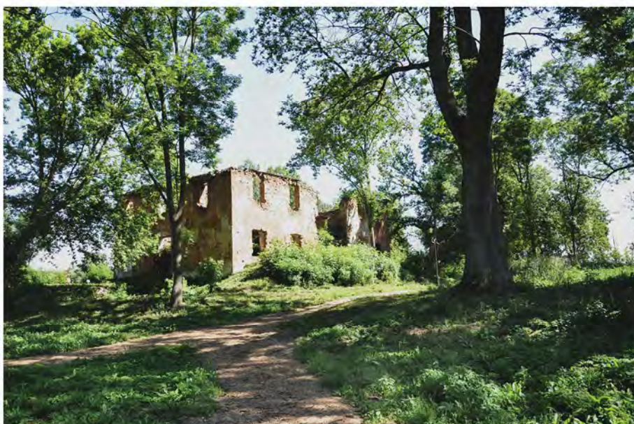
Fot. 7.7. Widok na elewację tylną - południową.
