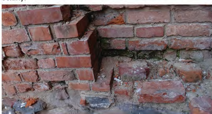
Fot. 2.18. Mur północny wewnętrzny.
