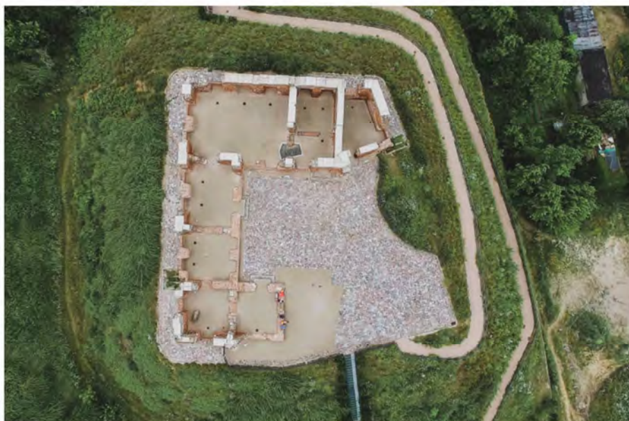
Fot. 6.4. Widok z góry na ruiny zamku.
