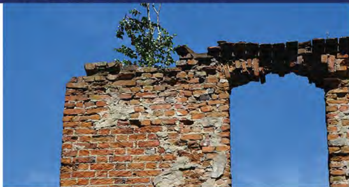
Fot. 7.13. Mur elewacji południowej.
