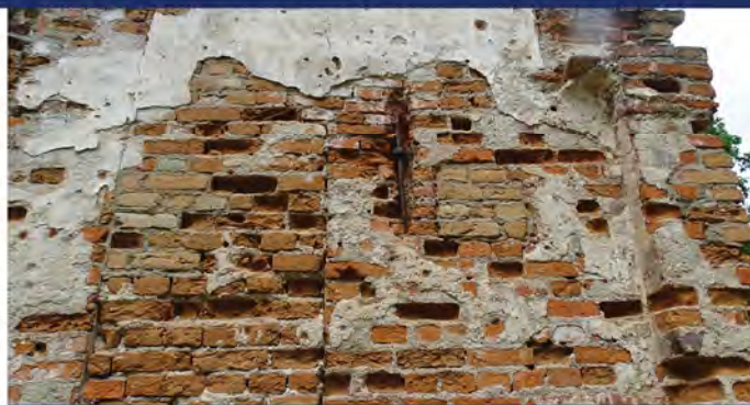
Fot. 1.15. Elewacja południowa.
