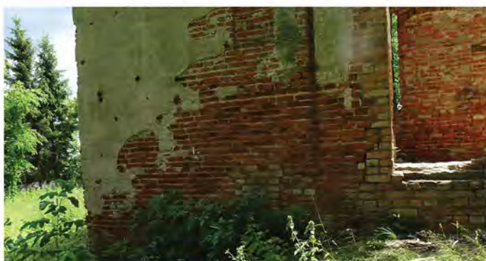
Fot. 1.16. Elewacja północna.
