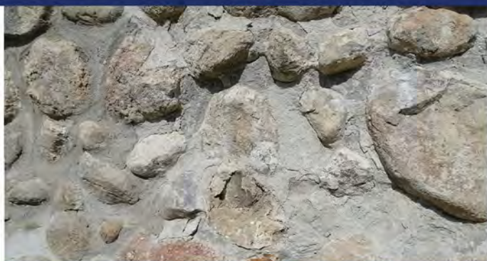
Fot. 5.14. Mur południowo-wschodni.
