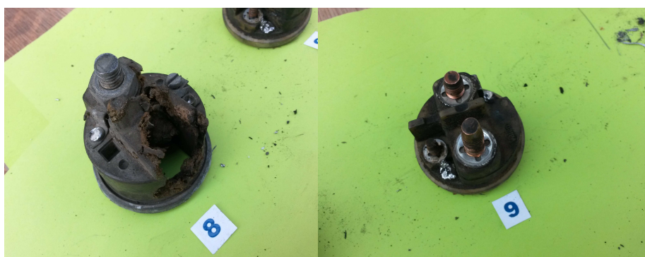
Rys. 5.26. Uszkodzenie styków wyłącznika: wyłamanie styku (8), nadpalenie styków (9)
