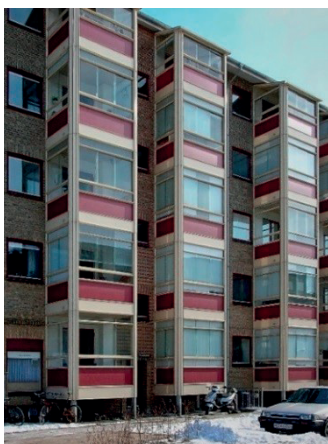
Rys. 1.2. Oszklone balkony dobudowane w obiekcie istniejącym (Dania, Aalborg).
