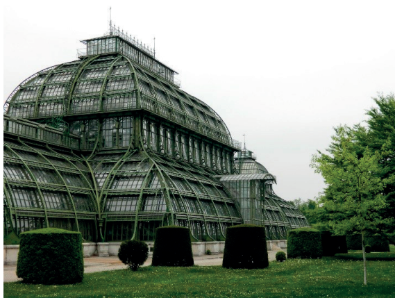
Rys. 2.10. Palmiarnia o konstrukcji nośnej z żelaza (Austria, Wiedeń, pałac Schönbrunn).
