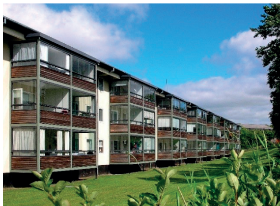
Rys. 1.4. Oszklone balkony w obiekcie nowoprojektowanym (Dania, Aalborg).
