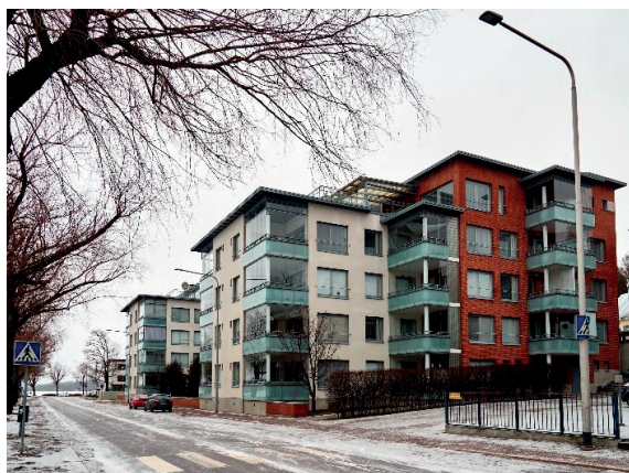
Rys. 2.20. Zabudowane balkony w budynku wielorodzinnym (Finlandia, Lappeenranta).
