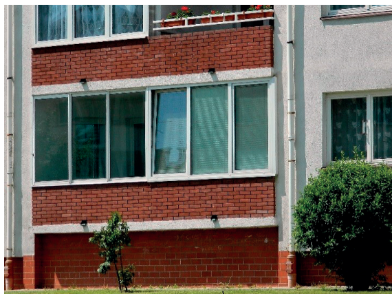
Rys. 2.15. Oszklone balkony w systemie ramowym przesuwnym – po lewej stronie, i z wykorzystaniem profili okiennych – po prawej stronie (Lublin).
