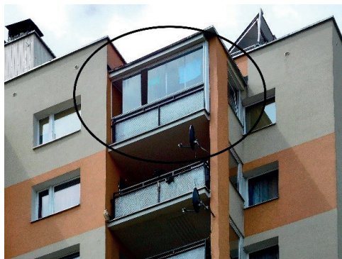
Rys. 9.2. Zabudowany balkon, mieszkanie nr 1, Zamość.
