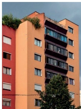
Rys. 1.3. Zabudowa loggii zrealizowana w obiekcie istniejącym (Francja, Lyon).
