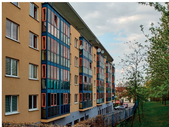
Rys. 2.13. Oszklone loggie w budynku przy ulicy o dużym natężeniu ruchu (Lublin).
