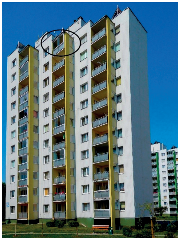
Rys. 9.4. Zabudowany balkon, mieszkanie nr 2, Zamość.
