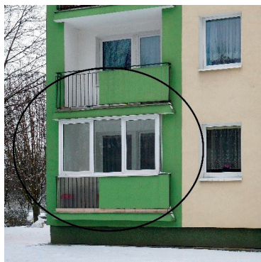
Rys. 9.10. Zabudowany balkon, mieszkanie nr 4, Lublin.
