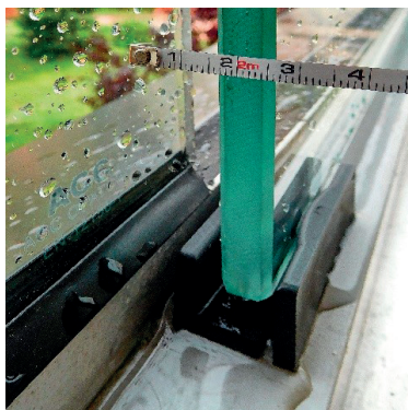
Rys. 9.9. Luzy międzyszybowe w obudowie balkonu, mieszkanie nr 3, Lublin.
