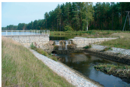
Fot. 6. Jaz w zaporze głównej o świetle 5 m, wys. piętrzenia 3,9 m zbiornika wodnego Aleksandrów o obj. 140,5 tys. m 3
