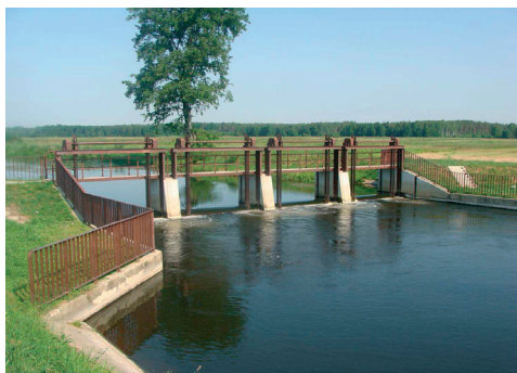
Fot. 8. Jaz Czosnówka o świetle 4 x 4,0 m, wys. piętrzenia 1,75 m na rzece Krzna w systemie Kanału Wieprz – Krzna
