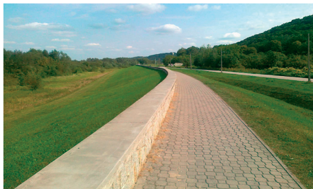
Fot. 18. Parapet stały o długości 3,155 km w koronie wału w Kazimierzu Dolnym, oddany do użytkowania w latach 2001 – 2006
