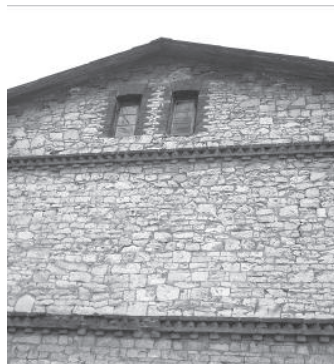
Rys. 8. Charakterystyczny detal XIX zabudowy przemysłowej wznoszonej z opoki wapiennej i cegły ceramicznej, Zagłoba, 2013, fot. autor
