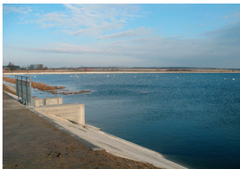
Fot. 9. Odbudowany zbiornik wodny Mosty o objętości 6,8 mln m 3 w systemie KWK w ramach I-go etapu
