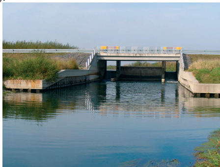
Fot. 13. Jaz zaporowy zbiornika wstępnego Nielisz na rzece Por o pojemności 1,57 mln m 3
