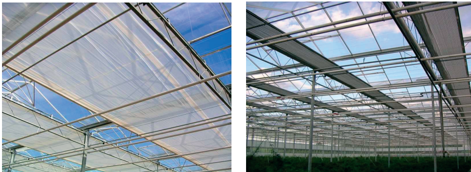
Rys. 9. Ekrany w szklarni: cieniówka (po lewej) i cieniująco-energooszczędny (po prawej) [11]
