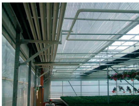
Rys. 10. Ekrany w szklarni: cieniówka (u góry) i ekran energooszczędny (u dołu) [11]
