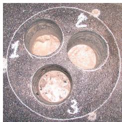
Rys. 13. Widok wykonanych odwiertów próbek z obszarów punktów obciążanych bezpośrednio pod obciążnikiem nawierzchni w przypadku rozważania konstrukcji Wapeco typu II
