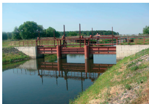
Fot. 10. Odbudowany jaz Sycyna - Puchacze o świetle 3 x 4,0 m, wys. piętrzenia 2,0 i 1,2 m na rzece Krzna w systemie Kanału Wieprz – Krzna
