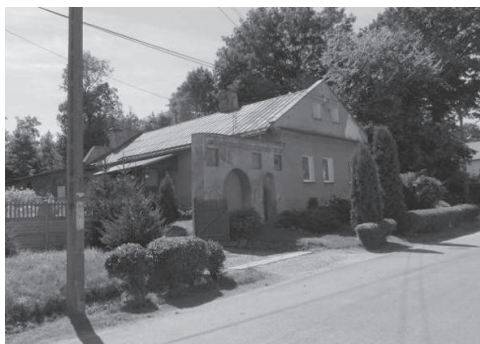
Rys. 6. Obiekt po modyfikacjach, Stan w 2012 r. fot. I. Niedźwiecka-Filipiak
