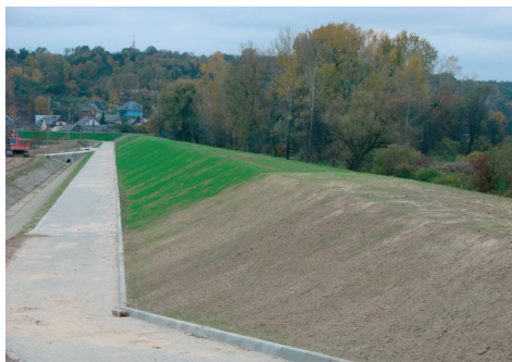
Fot. 20. Rozbudowa wału przeciwpowodziowego w dolinie Puławsko – Parchacko – Bochotnickiej na długości 8,992 km, przekazano do użytkowania w latach 1998 – 2012
