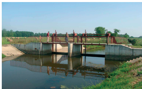
Fot. 7. Jaz Ortel Królewski o świetle 2 x 4,0 m i wysokości piętrzenia 2,0 m na rzece Zielawie w systemie Kanału Wieprz – Krzna
