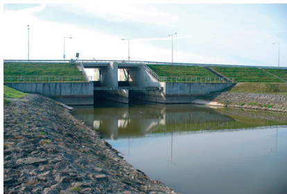
Fot. 16. Jaz zapory głównej zbiornika Nielisz, przekazanego do użytkowania w 2008 r.
