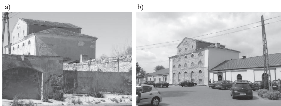
Rys. 5. Zespół zabudowy folwarku w Garbowie, a) młyn, stan w 2008roku, b) w trakcie prac remontowych, i rewitalizacji otoczenia zabytkowego młyna, 2013, fot. autor
