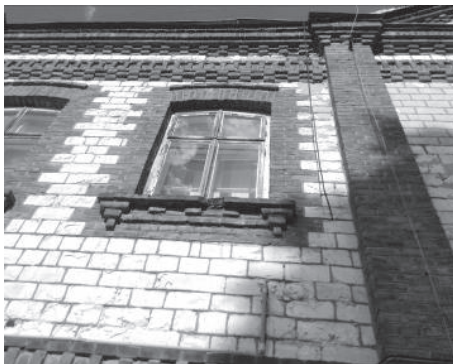
Rys. 8. Charakterystyczny detal XIX zabudowy przemysłowej wznoszonej z opoki wapiennej i cegły ceramicznej, Zagłoba, 2013, fot. autor
