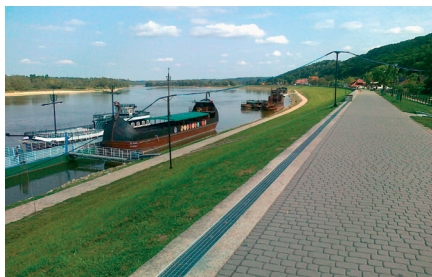
Fot. 19. Parapet rozbiegający na dł. 0,870 km, przekazany do użytkowania w latach 2001 – 2006.
