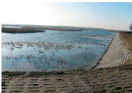
Fot. 21. Odbudowa I-go etapu zbiornika wodnego Mosty o objętości 6,8 mln m 3 przekazanego do użytkowania w 2011 r.
