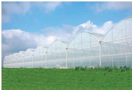
Rys. 7. Ciepłarnia Sur-Pneumatic TM Multi z pokryciem z nadmuchiwanego powietrzem podwójnej folii odpornej na działanie UV i opcjonalnie przeciwdziałającej kondensacji pary wodnej na powierzchni [11]
