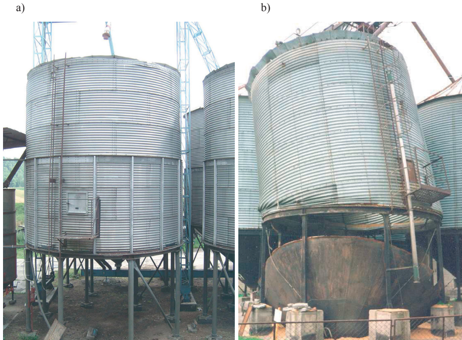
Rys. 6. Awarie silosów na zboże rozpoczynające się od oberwania leja: a) silos K850/2 PETKUS po usunięciu oberwanego leja, b) silos V = 200 \text{ m}^3 z żebrami wewnętrznymi płaszcza
