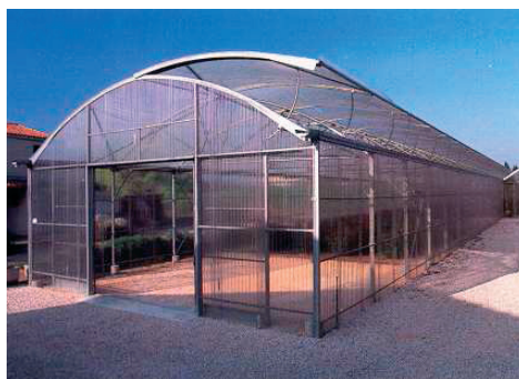
Rys. 6. Ciepłarnia z pokryciem dachu z podwójnej folii polietylenowej i ścianami pionowymi z płyt poliwęglanowych [10]
