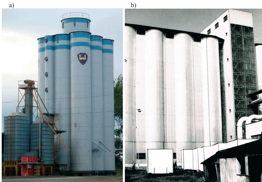
Rys. 2. Baterie stalowych prefabrykowanych silosów zbożowych z blachy gładkiej: a) w Jaworze z roku 1934, b) fragment baterii o ładowności 50 tys. ton firmy TMS Pardubice z 1986 r
