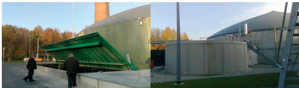
Fot. 1. Prawidłowo zaprojektowany węzeł podawania biomasy w biogazowni 2 MW w Dreźnie: lewa strona – substraty płynne, prawa - kiszonka (fot.A.Myczek)
