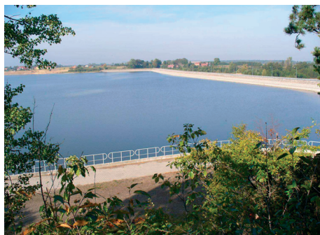
Fot. 4. Zapora główna na rzece Wieprz na długości 845 m i wys. 6,5 m zbiornika Nielisz o objętości 19,48 mln m 3
