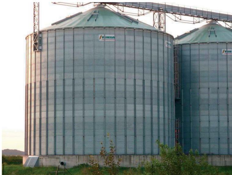
Rys. 5. Duże płaskodenne silosy na produkty rolne z blachy falistej
