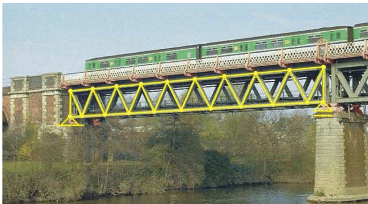
Rys. 6.8 Kratownica płaska obciążona przez przejeżdżający pociąg
