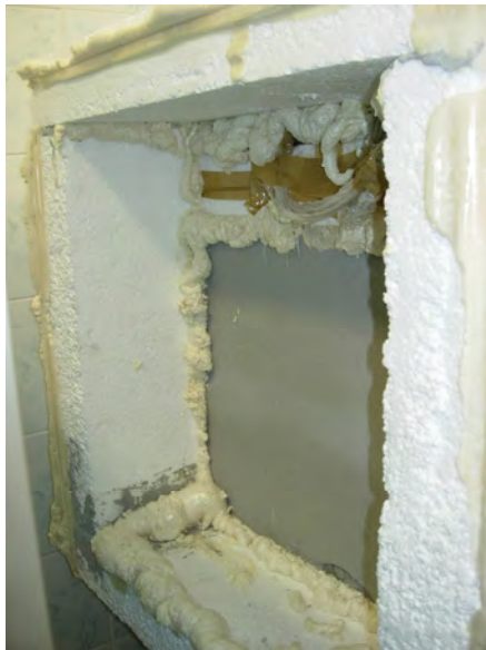
Rys. 5.24. Wygląd próbki i tunelu styropianowego
