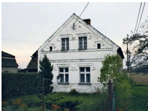
Ryc. 3. Zachowana elewacja szczytowa (2010)
