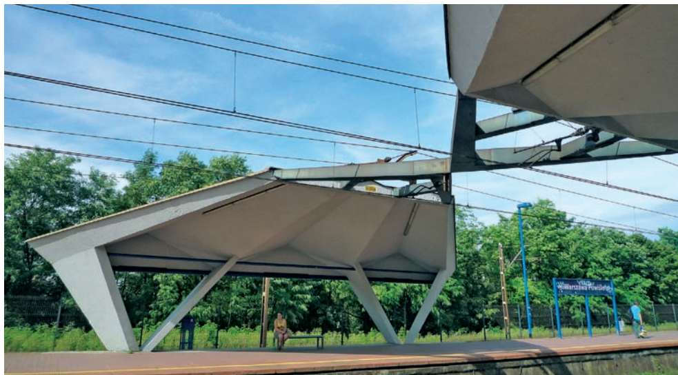
Ryc. 4. Przystanek kolejowy Warszawa Powiśle, wiata nad peronami. Projekt ok. 1955 r., realizacja 1962 r. Architekci Arseniusz Romanowicz i Piotr Szymaniak. Fot. Karol Guttmejer
