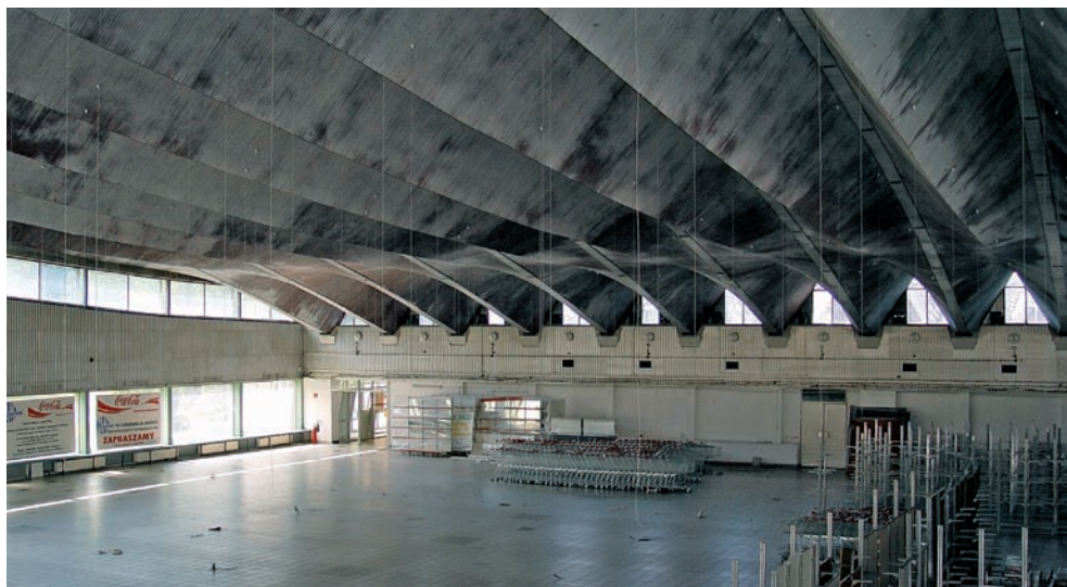
Ryc. 2. Dom handlowy Supersam. Projekt 1953 r. realizacja 1959-1962; architekci: Maciej Krasiński, Ewa Krasińska, Jerzy Hryniewicz, konstrukcja Wacław Zalewski i Andrzej Żórawski. Foto Urszula Bryłowska
