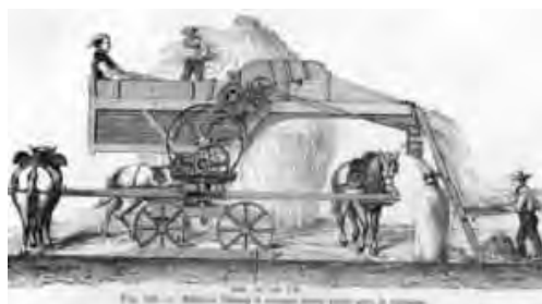
Rys. 2.3. Młockarnia z roku 1881, napędzana kieratem
