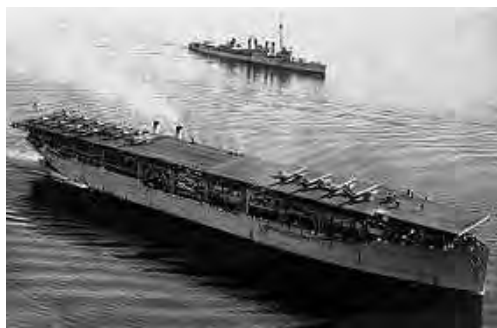
Rys. 7.34. „USS Langley” – pierwszy amerykański lotniskowiec. Okręt został zbudowany w 1913 r. jako węglowiec pod nazwą „USS Jupiter”. W 1920 r. rozpoczęto jego przebudowę na lotniskowiec i nazwano imieniem Samuela Pierponta Langley’a
