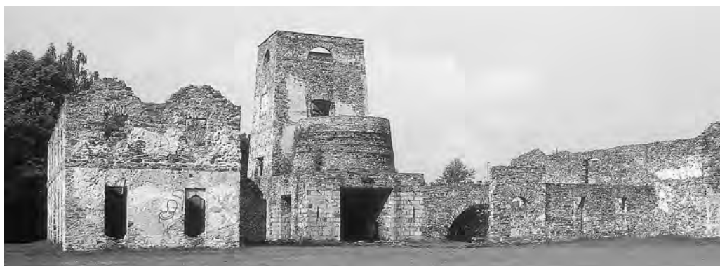
Rys. 3.31. Pozostałe po pożarze w 1866 roku ruiny zakładów przetwórstwa żelaza w Samsonowie (wielki piec to budynek cylindryczny)
