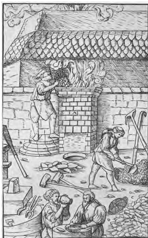
Rys. 3.7. Piec sztukowy z XVI wieku (wg Agri-coli), przednia dolna część pieca zrobiona jest z gliny, by można było ją rozbić w celu wyjęcia bochna (stąd też nazwa piec sztukowy)
