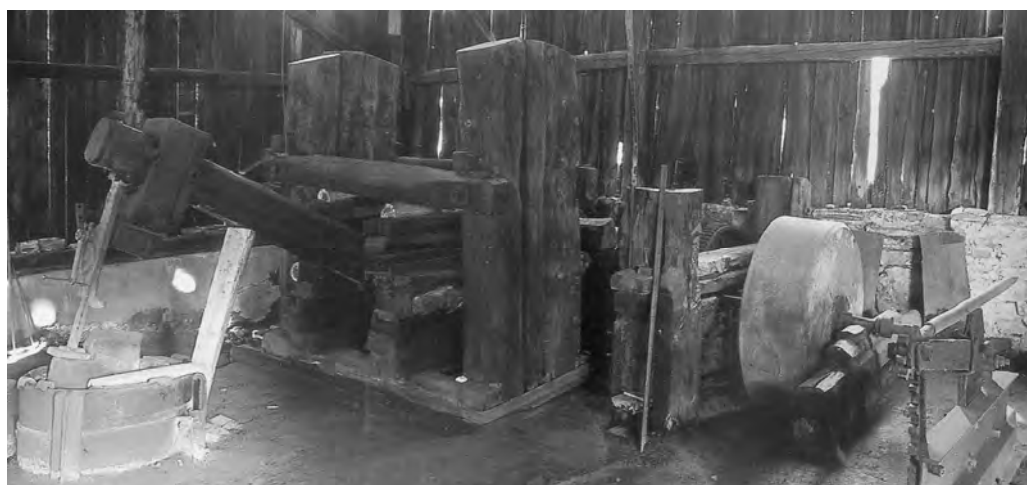
Rys. 4.14. Zabytkowy młot napędzany kołem wodnym położony nad rzeką Młynkówką w Starej Kuźnicy
