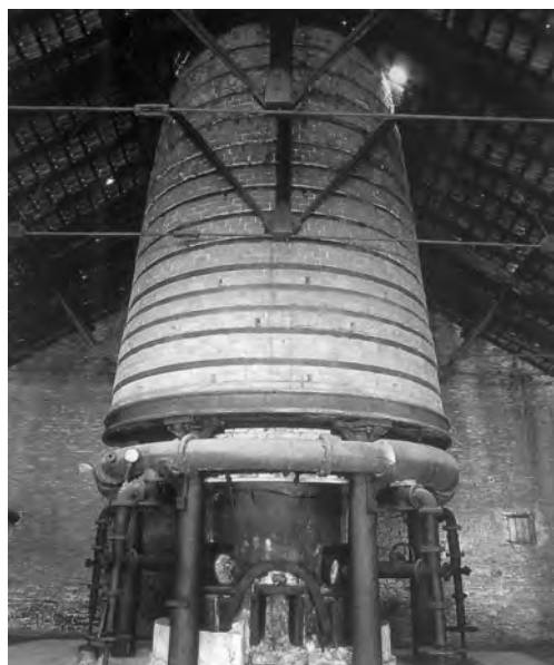
Rys. 3.33. Wielki piec w Chlewiskach, uruchomiony w latach 1890 -1892, pracujący do roku 1940. Ostatni w Eurpie piec (o wydajności 13-15 ton surówki na dobę) opalany węglem drzewnym
