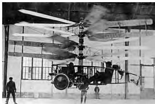
Rys. 8.73. Śmigłowiec Pescara No 3 (silnik 135 kW, średnica rotora 7,2 m, waga 1000 kg, prędkość max. 13 km/h), wykorzystany w próbie z roku 1924 - poprzednie maszyny Pescary budowane od roku 1919 były mniej udane
