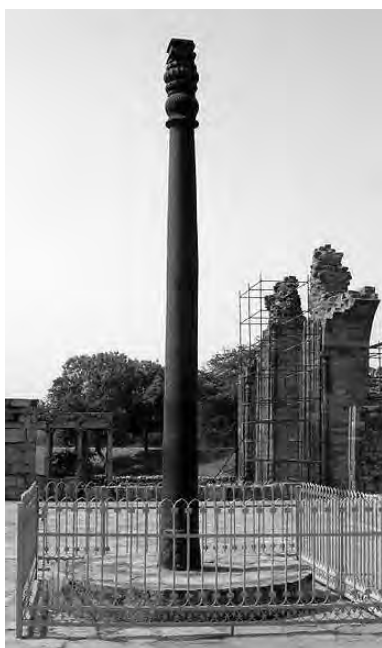
Rys. 3.6. Kolumna w Qutub (Indie), wykonana prawdopodobnie ok. 415 r., która nie rdzewieje
