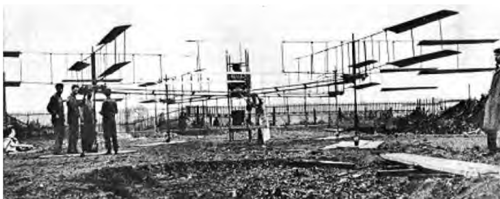
Rys. 8.68. Pierwszy śmigłowiec Breguet'a Gyroplane 1 (1907 r.). Maszyna ta czasem odrywała się od ziemi, ale była zupełnie niesterna, na zakończenie prób pogalopowała około 100 metrów i skraksowała na polu burzającym.
