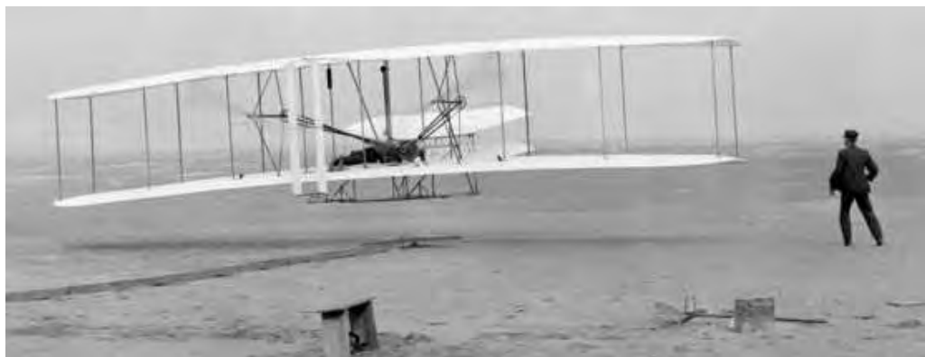
Rys. 8.25. Samolot braci Wright w czasie prób wykonywanych 17 grudnia 1903
