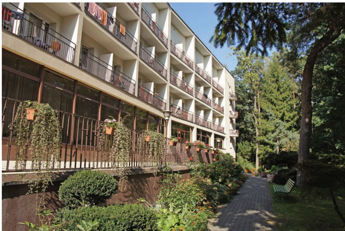
Il. 200. Sanatorium ZNP, widok elewacji od strony południowej, fot. N. Przesmycka, 2018
