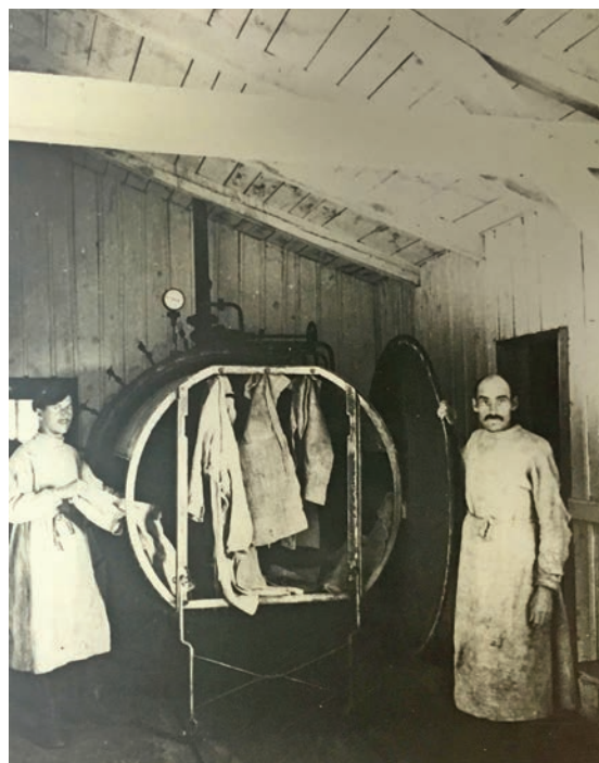
Il. 143. Baraki sanatoryjne – wnętrze dezynfekcji zakładowej i kotłowni, fot. Z. Czarkowski, pomiędzy 1911 a 1920 rokiem, źródło: Miejsko-Gminna Biblioteka Publiczna im. Faustyny Morzyckiej w Nałęczowie
