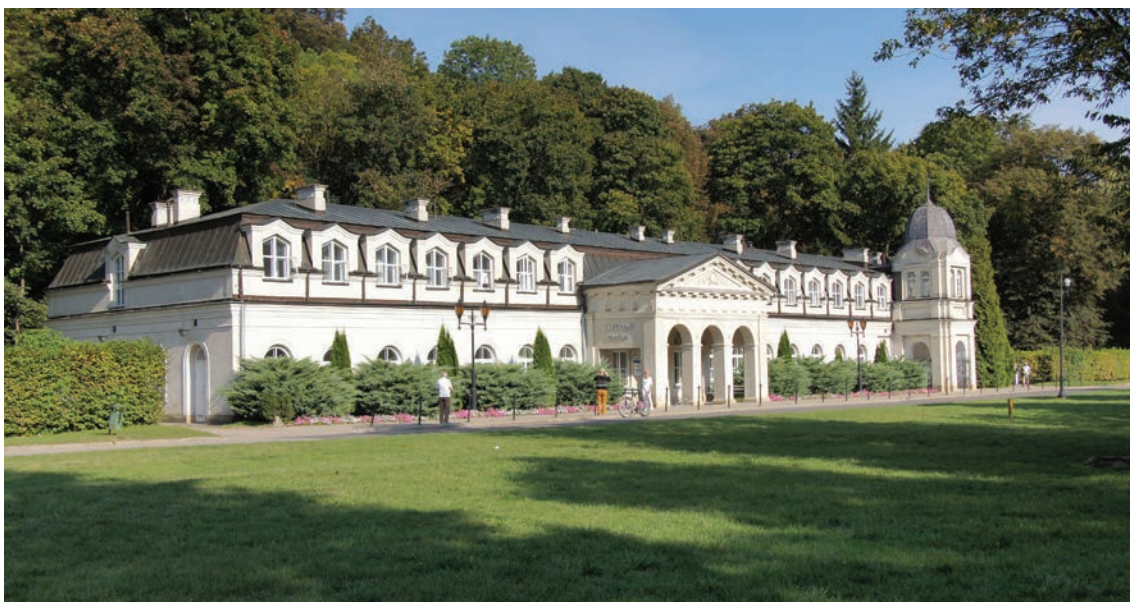
Il. 113. Stare Łazienki, widok od strony zachodniej, fot. N. Przesmycka, 2018
