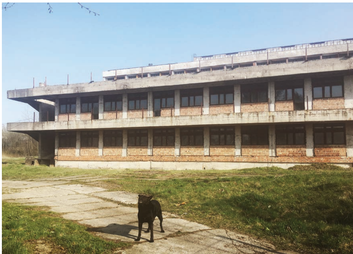
Il. 210. Sanatorium MSWiA widok od strony południowej, fot. N. Przesmycka, 2018
