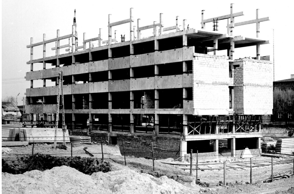
Budynek IIBiS w trakcie budowy.
