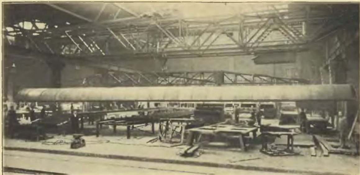
Przenoszenie gotowego dachu wagonu żelaznego na miejsce montażu.
