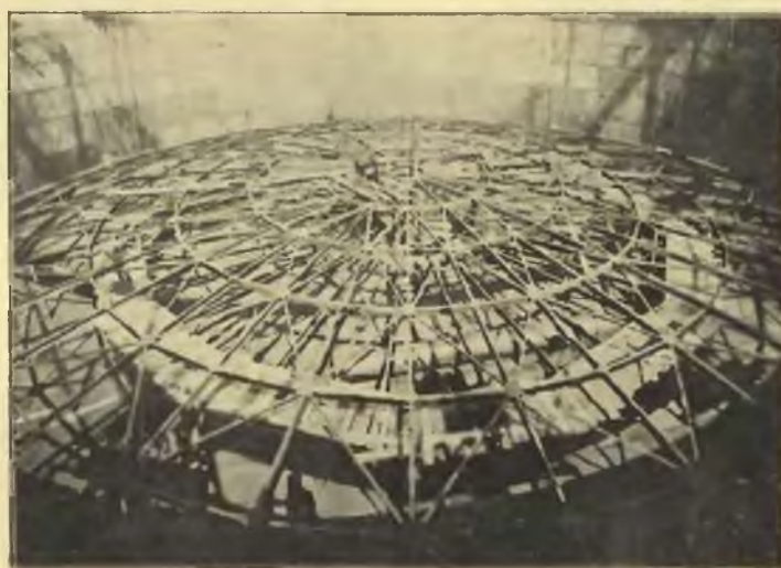
Konstrukcja nośna kopuły zbiornika gazowego.
