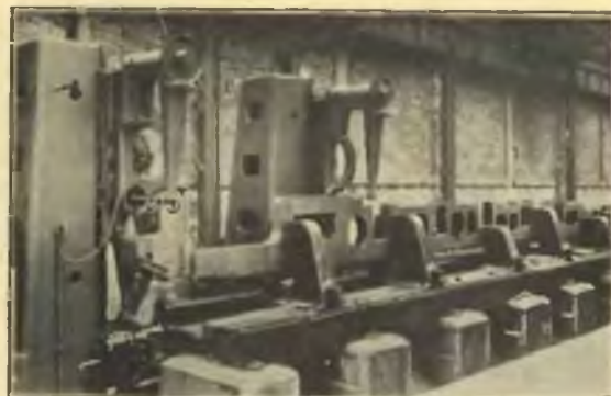
Frezowanie osłojnic parowozowych.
