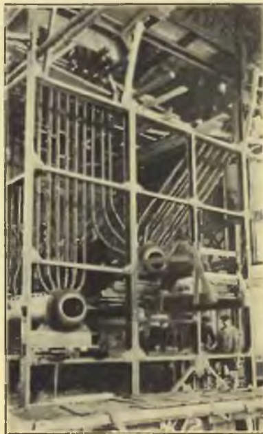
Kocioł stromorurkowy na 35 atm. o zgiętych opłomkach (typ Stirling)
