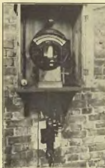
Aparat Szucha kontrolujący nitowanie.
