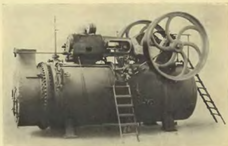
Lokomobila jednocylindrowa z paleniskiem wyciągalnem o płomieniu zwrotnym.
