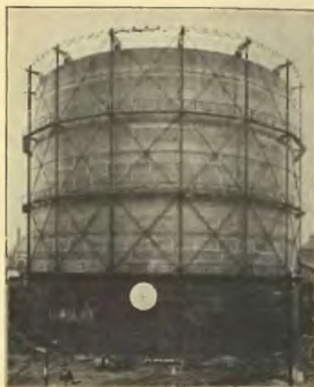
Zbiornik do gazu 30.000 m 3 pojemności.
