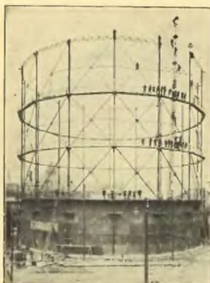
Montaż zbiornika do gazu
