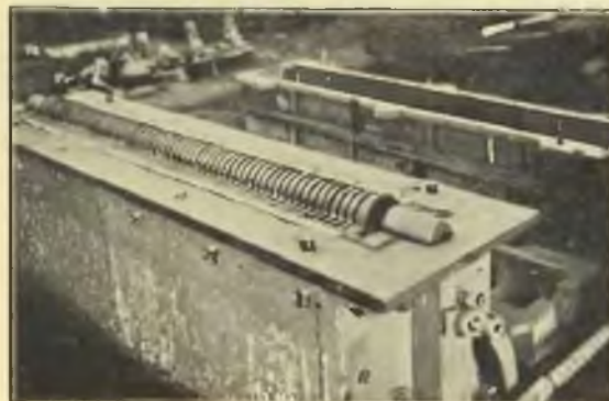
Maszyna do formowania rur do ekonomizerów.
