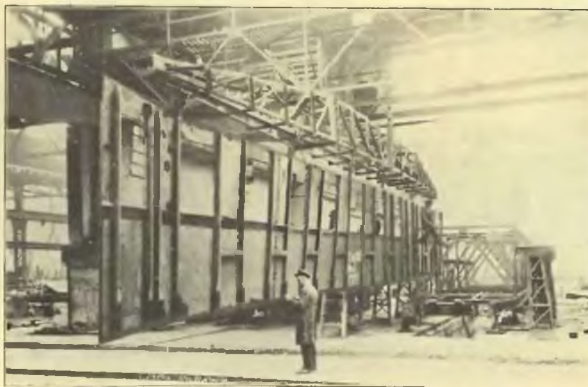
Przenoszenie gotowej ściany bocznej wagonu żelaznego w fabr. H. Cegielski Sp. Akc. w Poznaniu.
