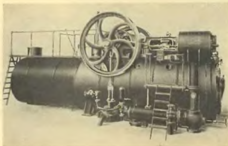
Lokomobila stacyjna sprężona na parę przegrzaną z kondensacją.
