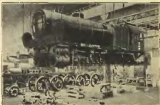
Hala montażowa parowozów Parowóz podniesiony suwnicą 120 ton nośności
