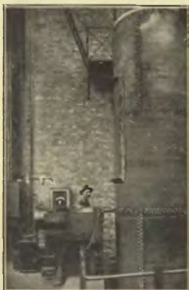
Nitarka hydrauliczna — zagłębiona.
