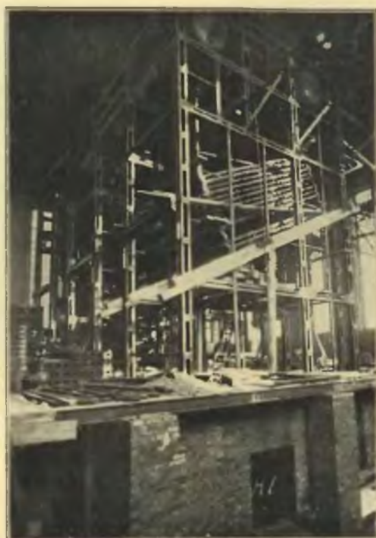
Kocioł sekcyjny współczesny o wysokiej wydajności w montażu.
