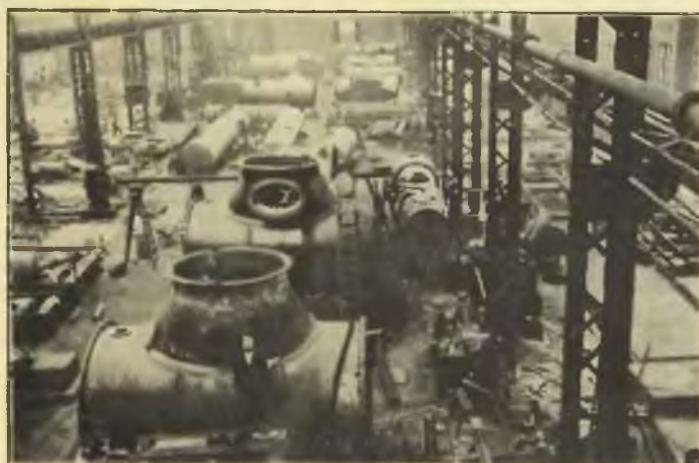
Rzut oka na kotłarnię.
