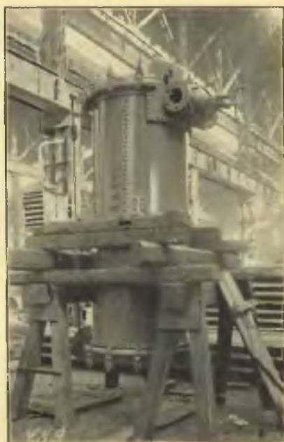
Ogrzewacz szybkooprądowy w montażu.
