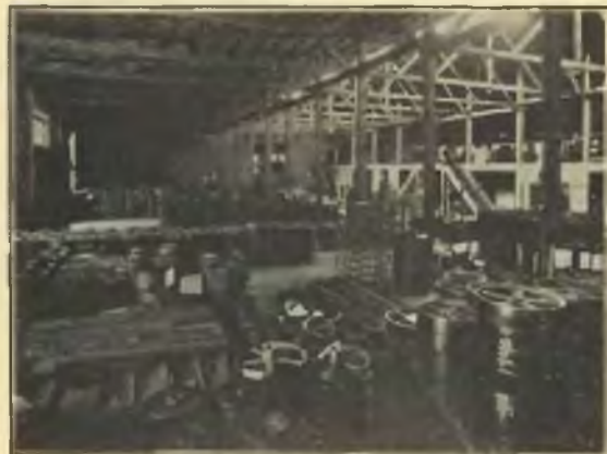
Magazyn półfabrykatów żelaznych.
