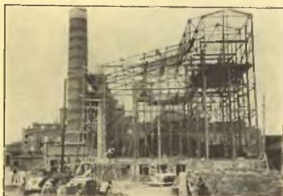
Konstrukcja żelazna w Cukrowni w Szamotułach.
