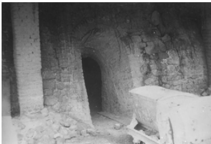
Ryc. 9. Wjazd wózków do komory pieca na Wietrzni. (Fot. K. Dumala)
