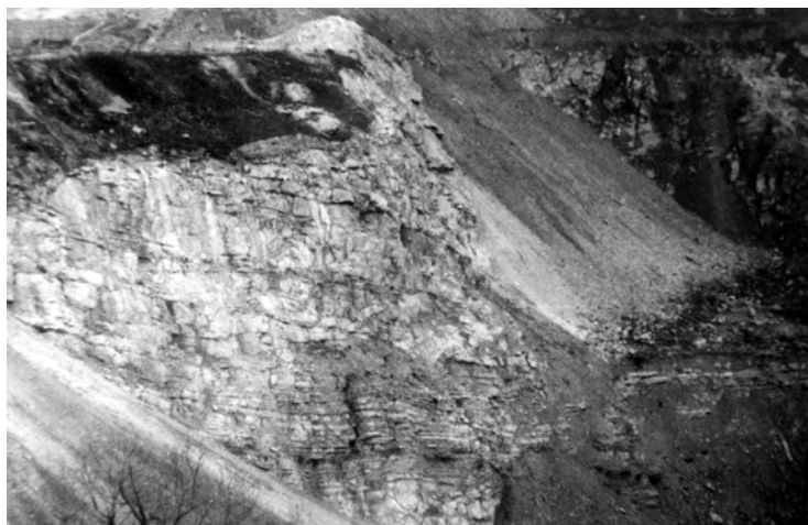
Rys. 23. Wyrobisko Zakładów Wapienniczych „Wietrznia” w Kielcach. Stan – lipiec 1984 r. (Fot. A. Paszkiewicz)
