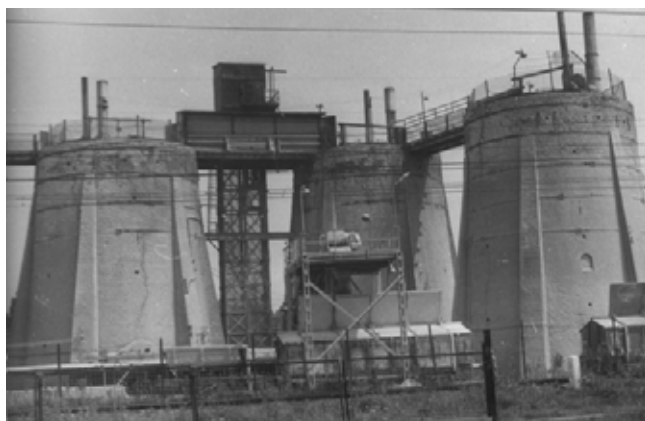
Ryc. 17 Piec szybowy „trójniak” w Krapkowicach. (Fot. A. Paszkiewicz)
