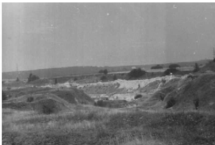
Ryc. 22. Wyrobisko w okolicach Gogolina. Kamieniołom był eksploatowany na przełomie XIX i XX wieku. Stan – lipiec 1984 r. (Fot. A. Paszkiewicz)
