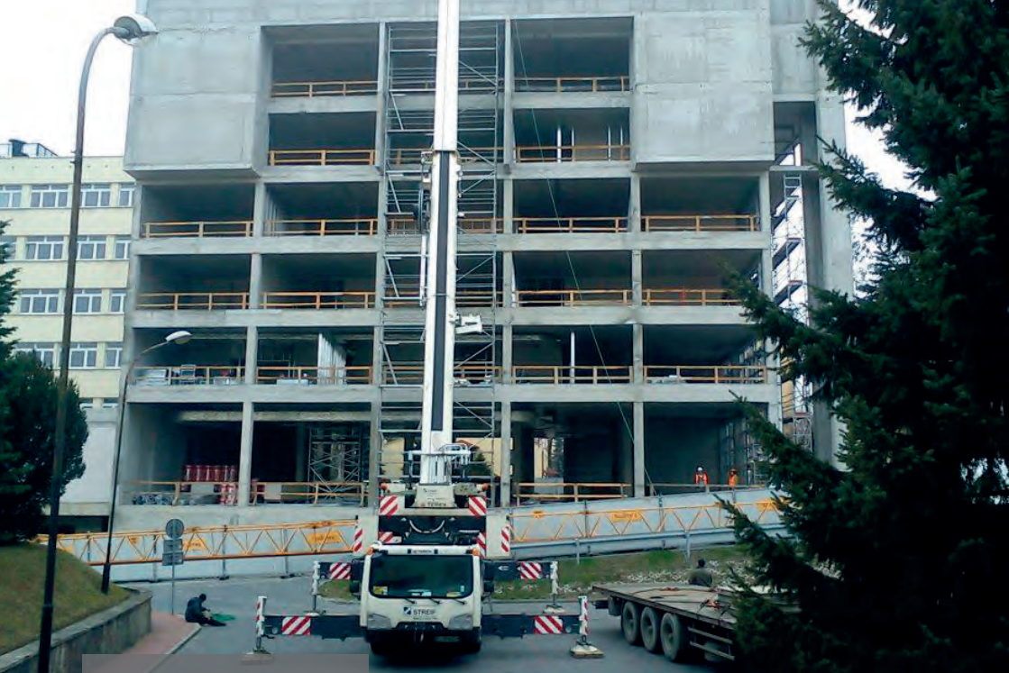
Kwiecień 2012 r. Demontaż dźwigu stacjonarnego. April 2012. Dismantling the stationary crane
