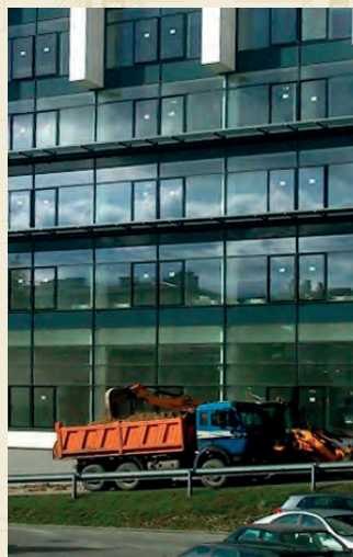
Listopad 2012 r. Prace porządkowe wokół budynku
