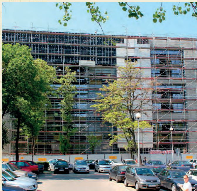
Maj 2012 r. Prace przy montażu okładzin elewacyjnych i stolarki okiennej na elewacji północnej May 2012. Installation of cladding and windows on the northern elevation
