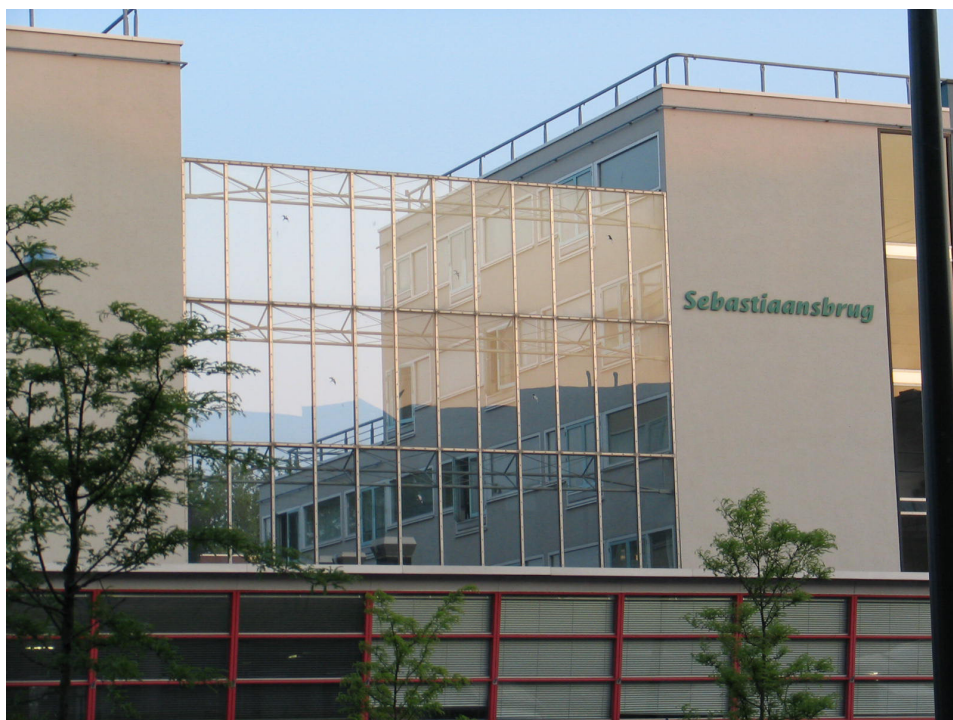
Rys. 5.19. Przykład domknięcia ścian szczytowych ekranem akustycznym (Holandia)
