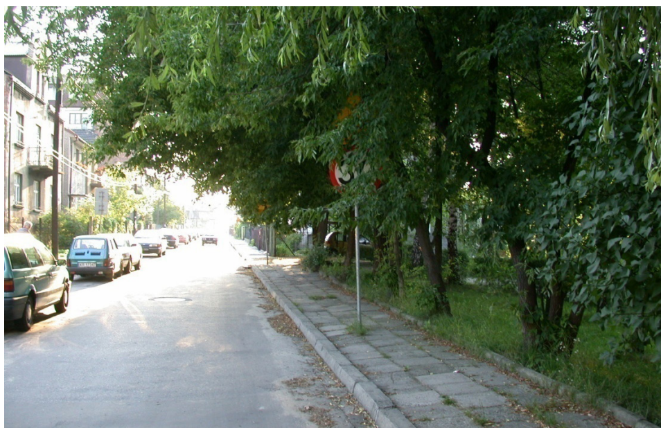
Rys. 5.12. Przykład nieprawidłowego zastosowania progu zwalniającego przed skrzyżowaniem z niewidocznym znakiem pionowym
