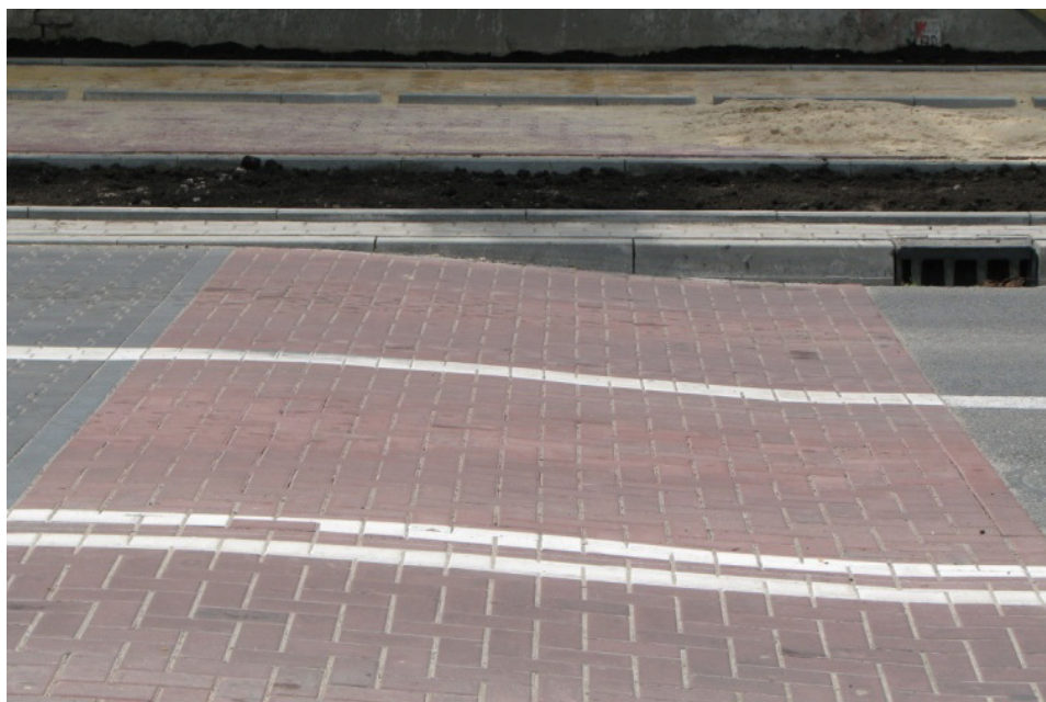
Rys. 5.15. Typowy najazd i zjazd stosowany w przypadku progów oraz powierzchni wyniesionych w Miasteczku Holenderskim w Puławach
