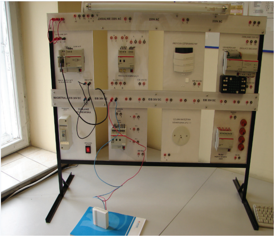
Rys. 14. Stanowisko pomiarowe do badania warunków wewnętrznych pomieszczenia za pomocą sensora jakości powietrza
