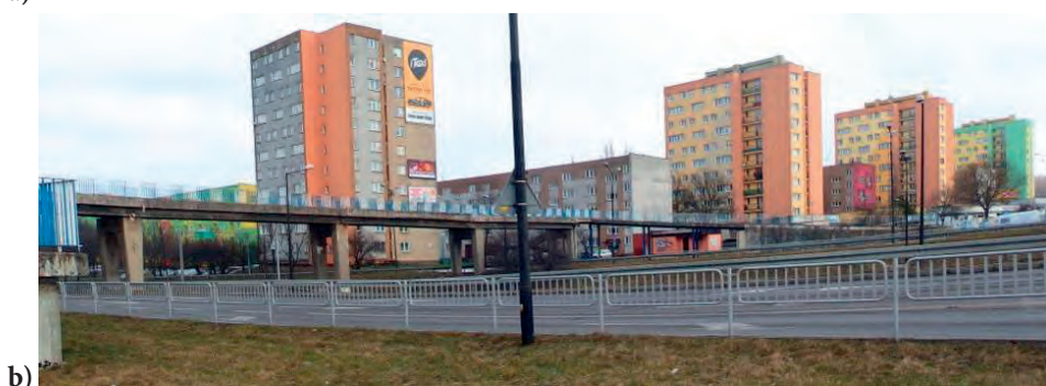
Il. 25. Kładka dla pieszych nad aleją W. Witosa a) widok nad jezdnią al. W. Witosa b) widok w kierunku północnym, fot. SLK (2017).
