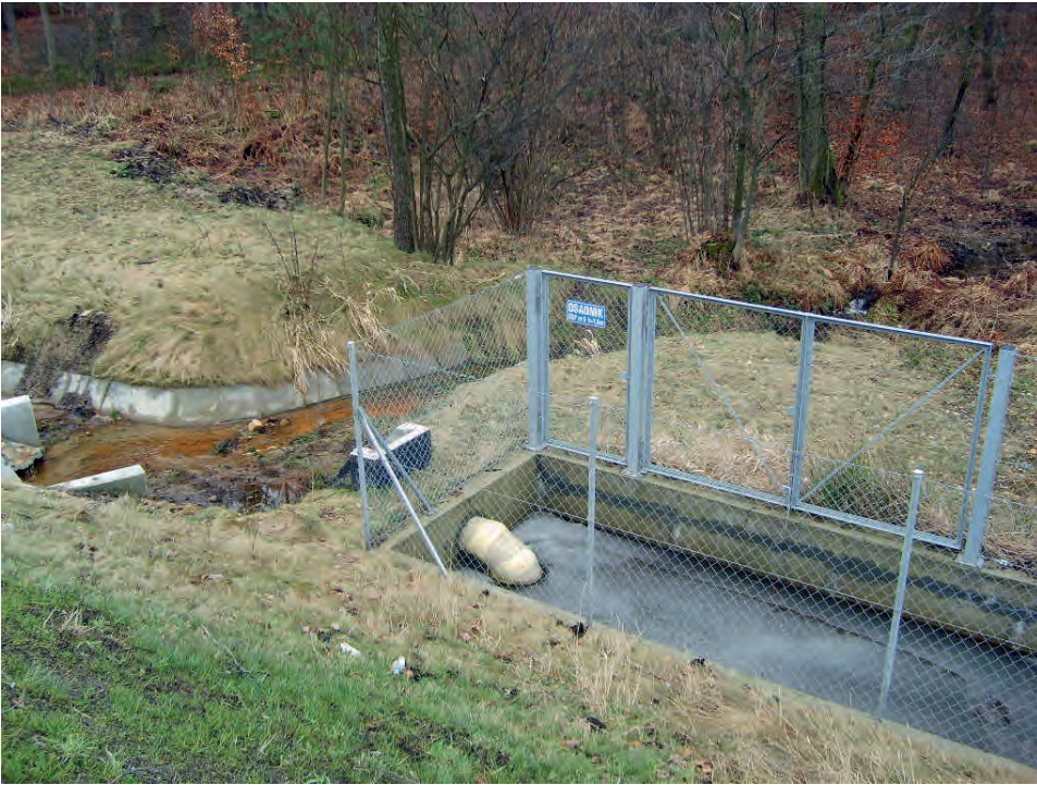
Il. 5. Przykład osadnika zastosowanego przed odpływem wód z rowu do odbiornika, fot. autor
