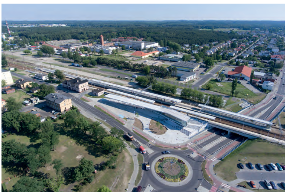
Il. 12., Il. 13. Dworzec w Solcu Kujawskim, autor zdjęć: Piotr Krajewski (materiały prywatne pracowni Rysy Architektki) Il. 12., Il. 13. Railway station in Solec Kujawski, photos by Piotr Krajewski (courtesy of Rysy Architektki)
