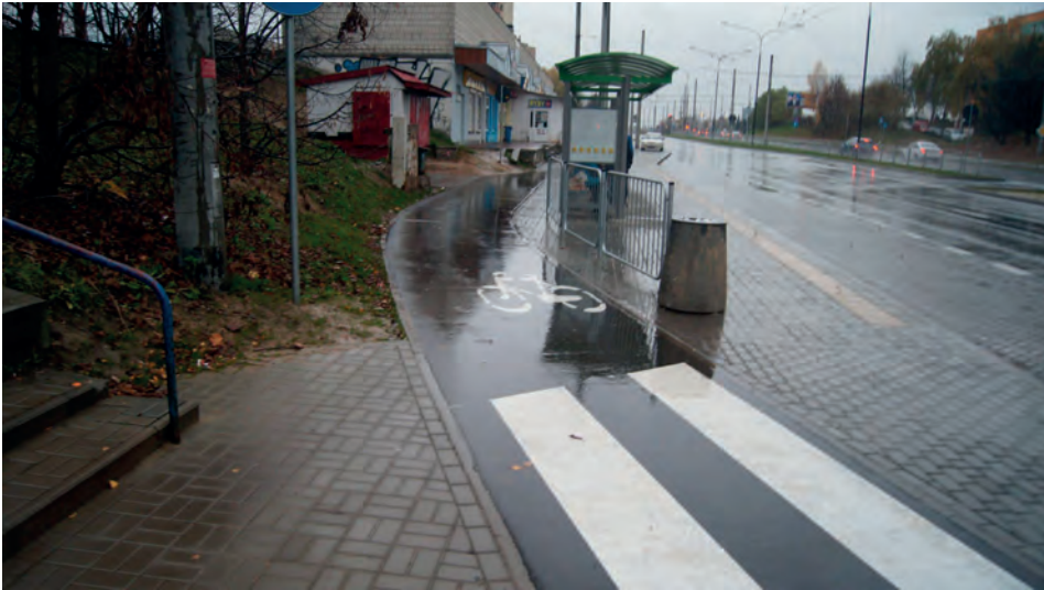
II. 3. Prawidłowe oddzielenie drogi rowerowej od przystanku, fot. autor
