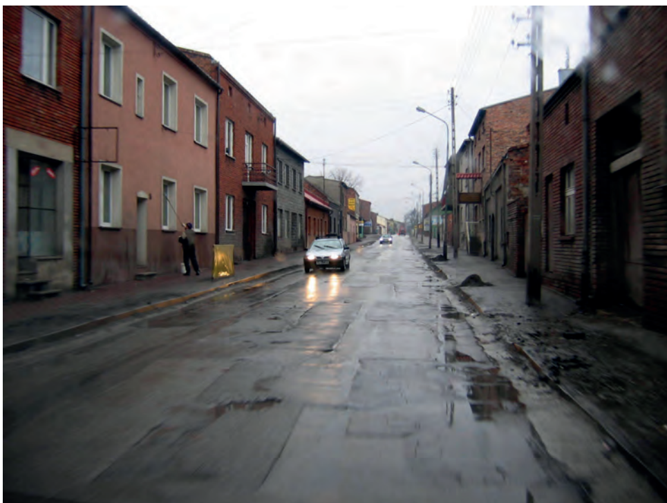
Il. 4. Przykład negatywnego wpływu braku systemu odwodnienia ulicy na otoczenie ulicy, fot. autor
