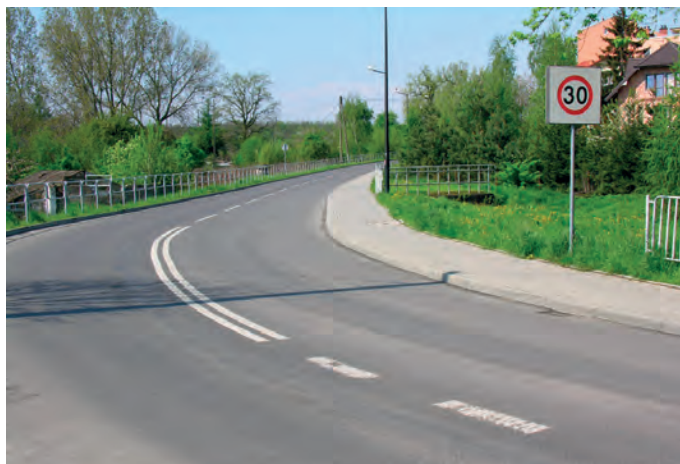
Il. 17. Oznakowanie wjazdu do strefy „30” bez fizycznego wyróżnienia zmiany przekroju drogi
