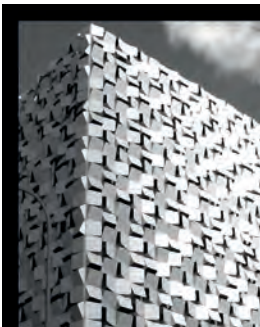
II. 8. Q Park parking, Arundel gate, Sheffield, Wielka Brytania. Fragment elewacji. Źródło archdaily.com / opracowanie graficzne własne. Odczyt 23.04.2018
