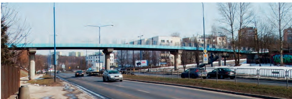
Il. 26. Kładka dla pieszych z belek prefabrykowanych Płońsk nad Aleją Sikorskiego.
