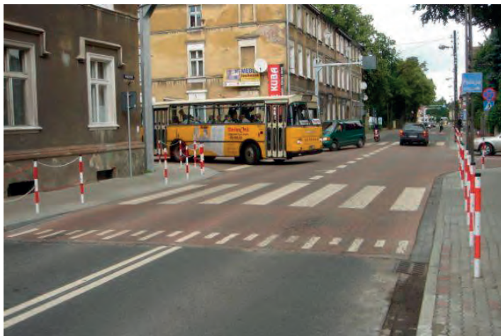
Il. 6 Wyniesiona powierzchnia skrzyżowania wraz z przejściem dla pieszych w ciągu drogi pełniącej funkcję rozprowadzającą
