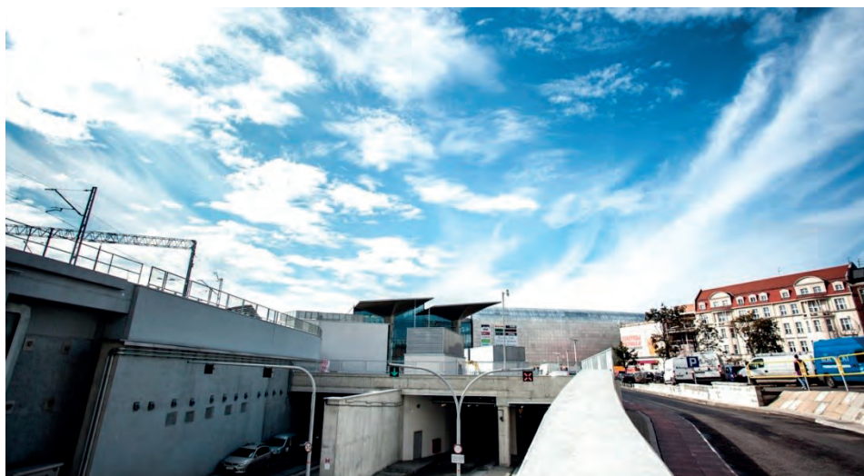
Zdjęcie 23. Widok na podziemną ulicę Dworcową i wjazd na podziemny dworzec, fot. z archiwum Galerii Katowickiej Picture 23. View of the underground Dworcowa street and the entrance to the underground station, photo from the archives of Galeria Katowicka
