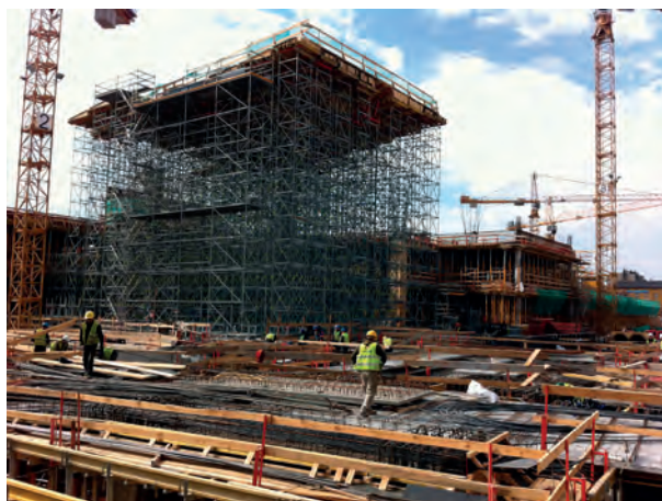
Zdjęcie 25. Budowa pierwszego kielicha, fot. Katarzyna Jakuć Photo 25. Construction of the first umbrella shape chalice, photo by Katarzyna Jakuć
