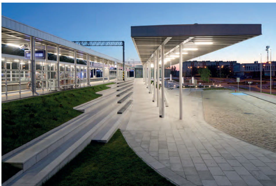
Il. 14., Il. 15. Dworzec w Solcu Kujawskim, autor zdjęć: Piotr Krajewski (materiały prywatne pracowni Rysy Architektki) Il. 14., Il. 15 Railway station in Solec Kujawski, photos by Piotr Krajewski (courtesy of Rysy Architektki)
