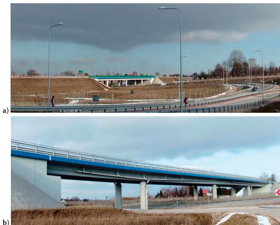
Il. 29. Typowe wiadukty na S19 a) węzeł Szerokie b) wiadukt w ciągu Traktu Kazimierskiego, fot. SLK (2018).
