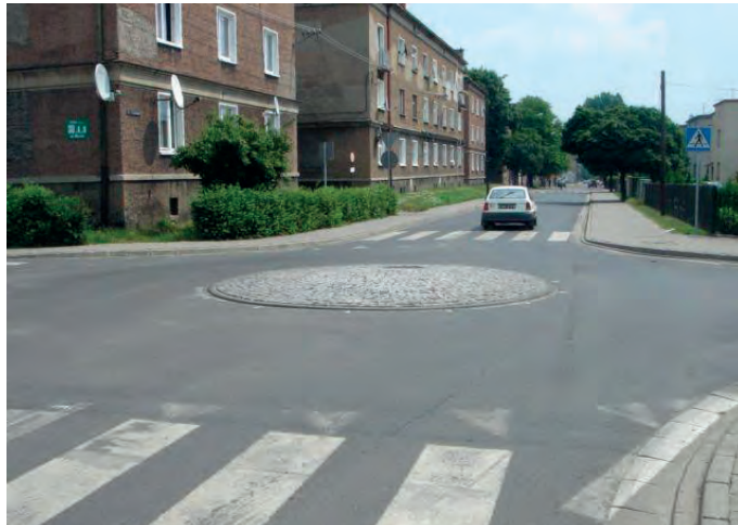
Il. 9. Przykład mini ronda (tzw. „pinezka”) z wyspą przejezdną
