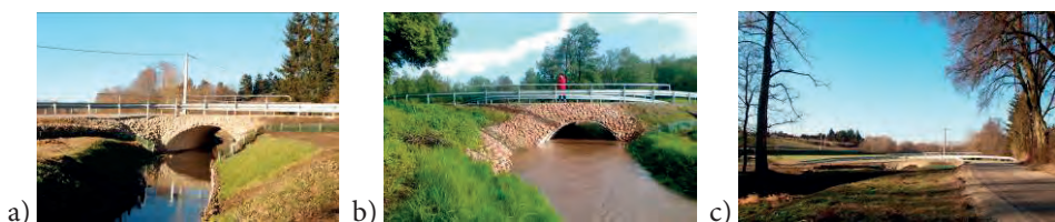
Il. 19. Przepust na rzece Czechówce w ciągu drogi gminnej a) średni poziom wody b) woda wysoka c) krajobraz z przepustem, fot. SLK (2014).
