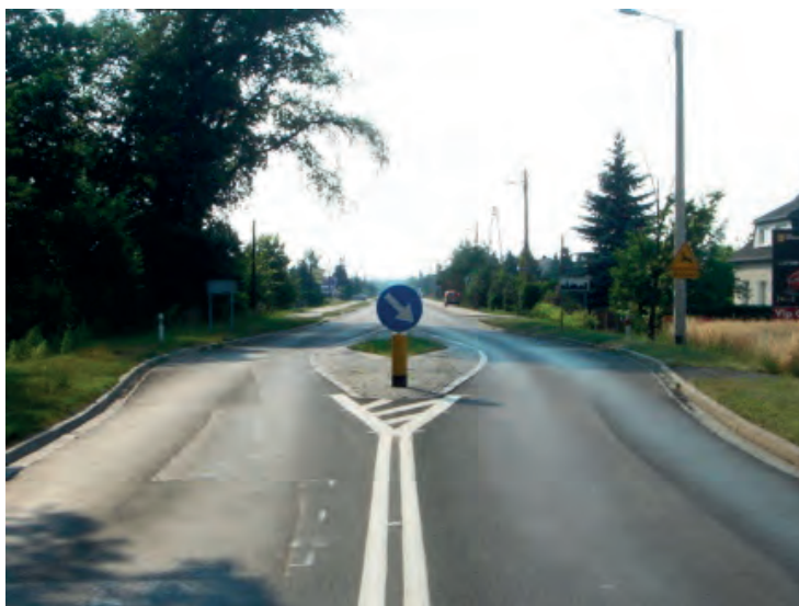
Il. 3. Przykład „bramy wjazdowej” do obszaru zabudowanego – odgięcie toru jazdy wymuszające spowolnienie
