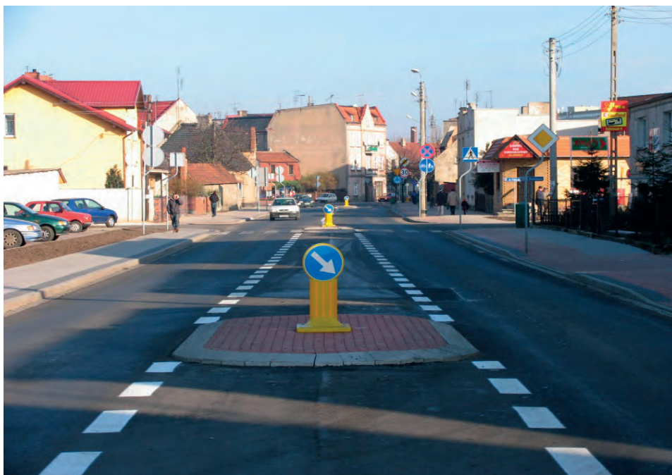
Il. 20. Wykorzystanie środkowej części jezdni o przekroju trzypasowym do obsługi posesji
