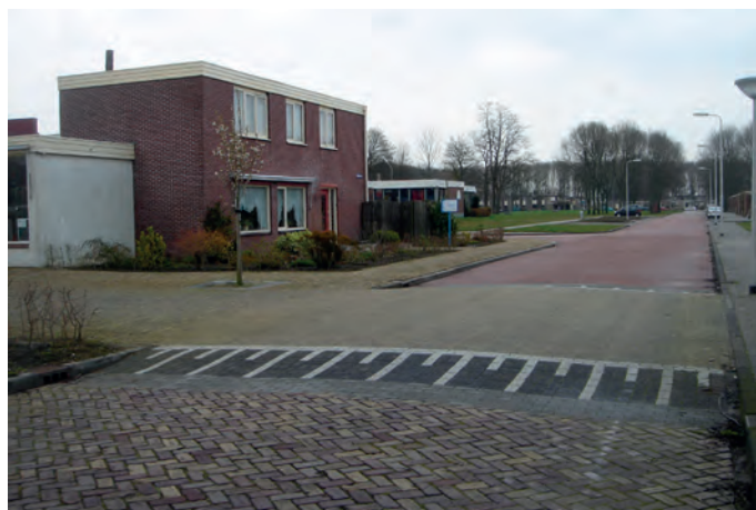
Il. 12. Powierzchnia spowalniająca z najazdami w postaci progów typu „A” w strefie 30 Il.12. The deceleration area with overruns in the form of speed bumps type A in zone 30
