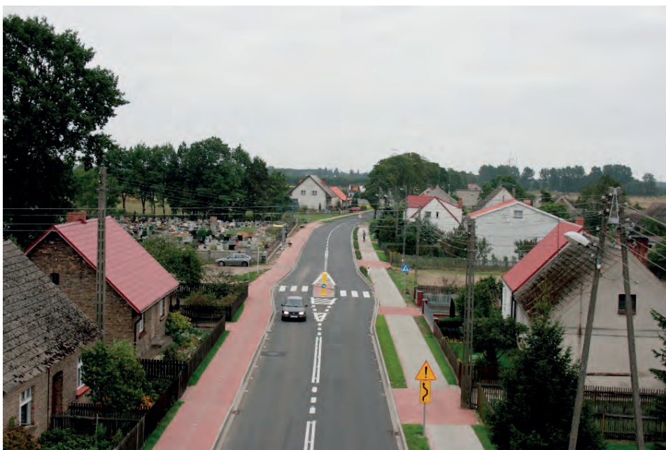
Il. 25. Azyl na przejściu dla pieszych wraz z odgięciem torów jazdy
