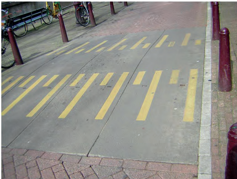
Il. 10. Typowy prefabrykowany próg zwalniający stosowany w Holandii Il.10. The typical prefabricated speed bump used in the Netherlands
