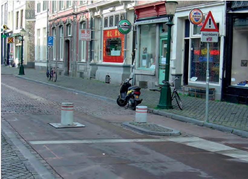
II. 21. Przykład ograniczenia dostępu za pomocą urządzeń zagłębianych w nawierzchnię II.21. An example of an access restriction by solutions embedded in the surface
