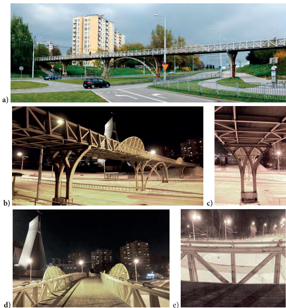
II. 10. Kładka nad ul. Filaretów w Lublinie a-b) widok z boku c) filar d) pomost e) balustrada, fot. SLK (2018).
