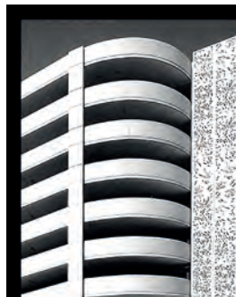
Il. 11. Skypark Car Park Phillip ACT, Australia, Architekci: May + Russell Architects. Fragment elewacji. Źródło archdaily.com / opracowanie graficzne własne. Odczyt 23.04.2018
