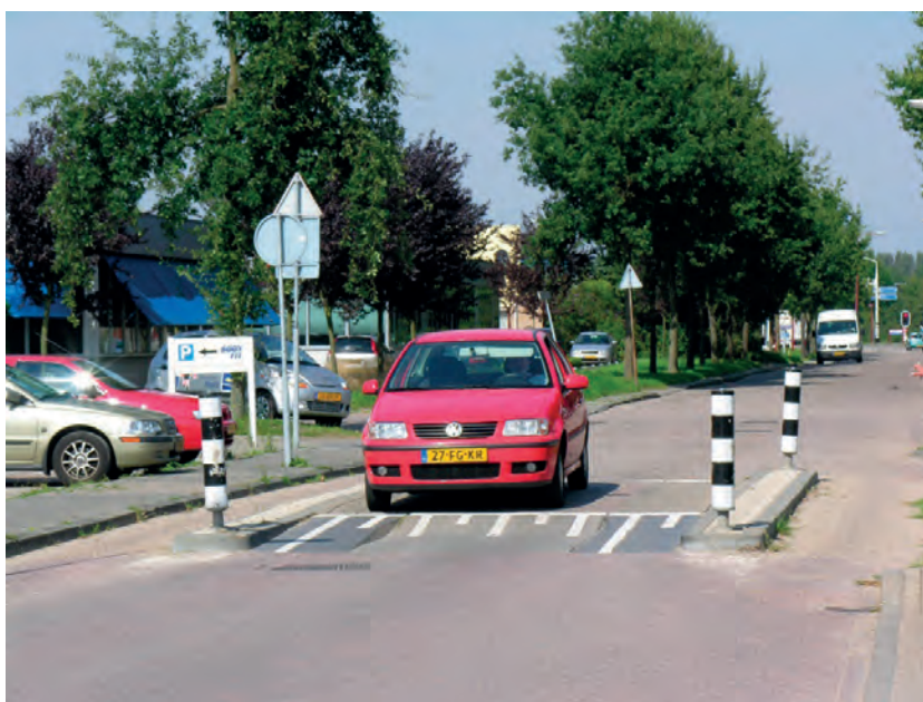
Il. 13. Zawężenie przekroju drogi z powierzchnią spowalniającą – przejazd pojazdów jednośladowych możliwy w jednym poziomie
