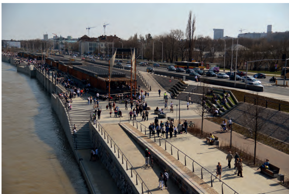
Il. 5. Wielopoziomowe bulwary wiślane w Warszawie, położone poniżej Wisłostrady, na odcinku pomiędzy Mostem Świętokrzyskim a ul. Karową, fot. K. Krupa
