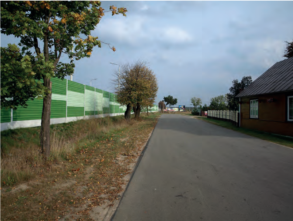
Il. 8. Przykład poprawnego wprowadzenia ekranu akustycznego w pobliżu zabudowy mieszkaniowej, fot. autor Il. 8. An example of the correct introduction of an acoustic screen near a residential building, photo by the author
