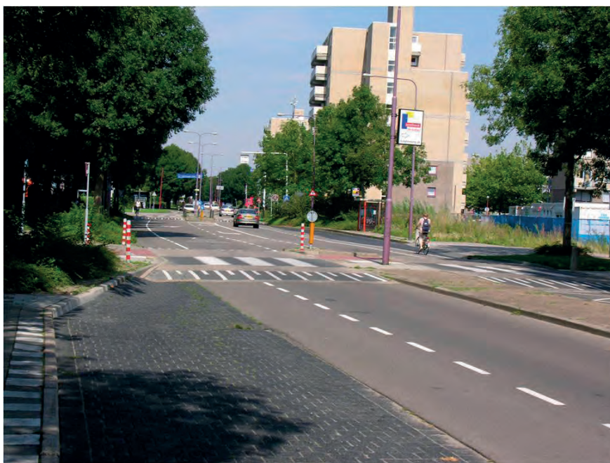
Il. 23. Przykład prowadzenia ciągów pieszych w jednym poziomie dzięki wyniesionej powierzchni przejścia dla pieszych
