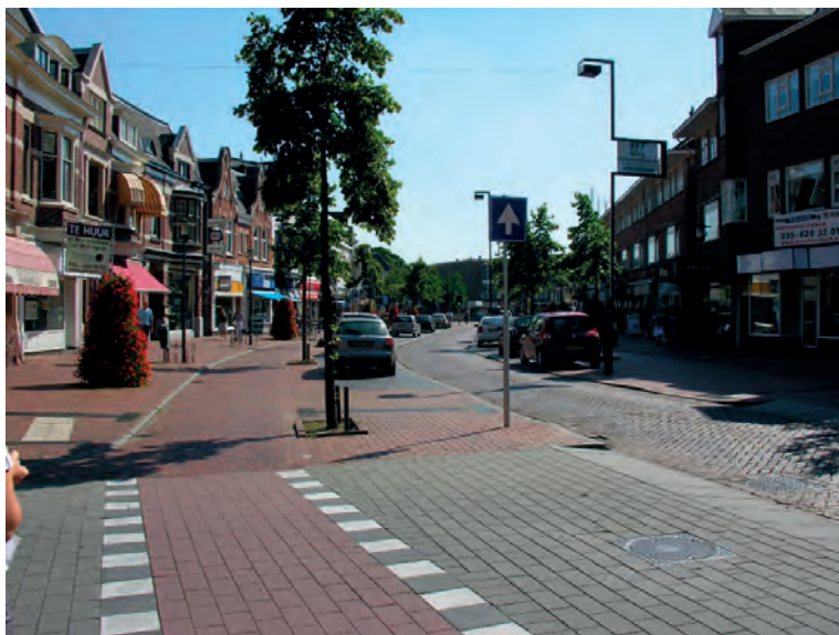
Il. 19. Miejsca postojowe wyznaczone równoległe wzdłuż krawędzi drogi jednokierunkowej, wyraźnie wydzielone z powierzchni jezdni Il.19. The parking places parallel to the edge of the unidirectional road, clearly separated from the road area
