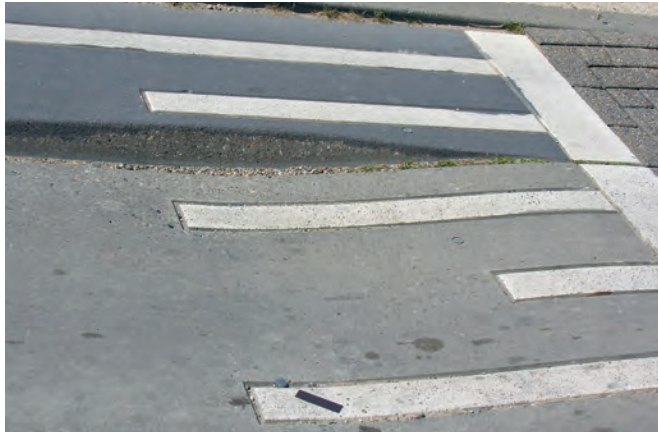
Il. 14. Najazd na powierzchnię spowalniającą o zmiennym przekroju, dostosowanym do różnych rodzajów pojazdów
