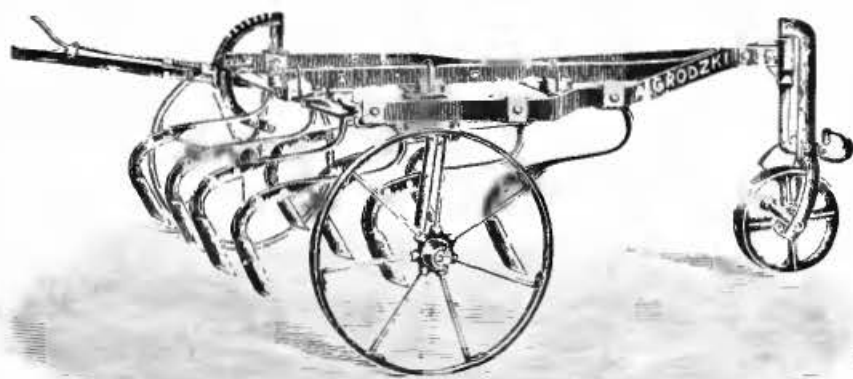
Rys. 39. Skaryfikator.
