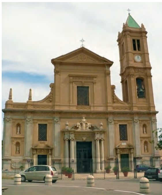
Fot. 8. Italia – fasada katedry w Termini Imerese po pracach. Malowanie nie doprowadziło do skontrastowania starego z nowym, nie zniszczyło estetycznej spójności, nie zatarło dawności zabytku.
