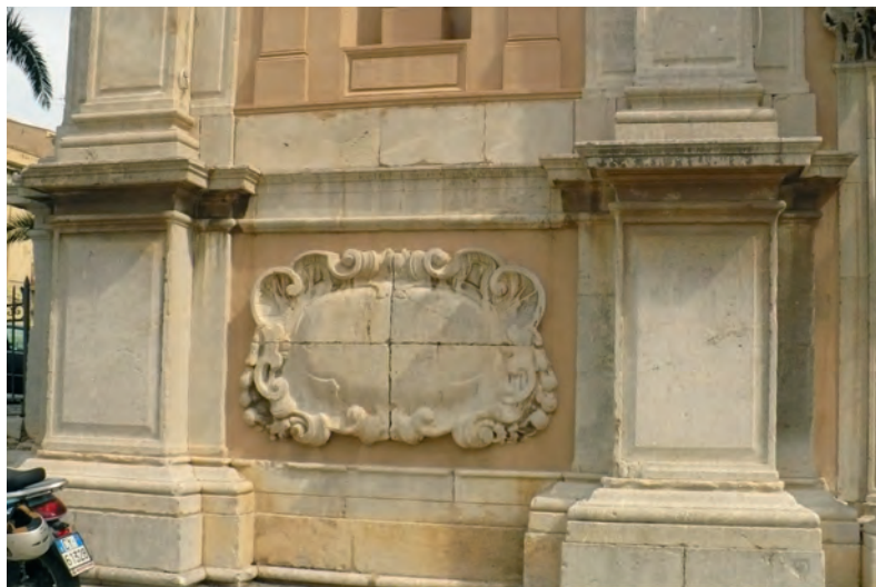
Fot. 9. Fragment fasady – prace zostały zrealizowane z zastosowaniem zasady minimalnej niezbędnej ingerencji - drobne uszkodzenia detali kamiennych pozostawiono bez uzupełnień, malowanie płaszczyzn tynku wykonano farbami półkryjącymi, co dało efekt lekkiej, żywej powierzchni. Widoczne tu i ówdzie przebarwienia i plamki nie dominują, nie przyciągają wzroku jak typowe uszkodzenia. Są estetycznie wtopione w płaszczyznę koloru, dzięki czemu czyta się je nie jako świadectwo zaniedbania, ale jako świadectwo minionego czasu i dawności obiektu.
