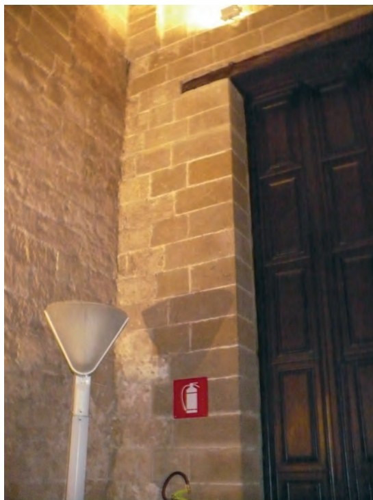
Fot. 1. Wnętrze kruchty obok Capella Palatina w Palazzo dei Normani w Palermo stanowi przykład bardzo dobrze zrealizowanych prac konserwatorsko-restauratorskich. Uzupełnienia ubytków kamienia wykonano z zachowaniem zasady odróżnialności, ale bez rozbijania jedności dzieła. Kamień uzupełnień odróżnia się nieco bardziej gładką fakturą. Niekonkurencyjność wobec oryginału i jedność estetyczną wnętrza uzyskano poprzez minimalne przyciemnienie, podbarwienie w tonacji chłodniejszej kamienia uzupełnień po to, by uzupełnienia nie dominowały nad materią oryginału.
