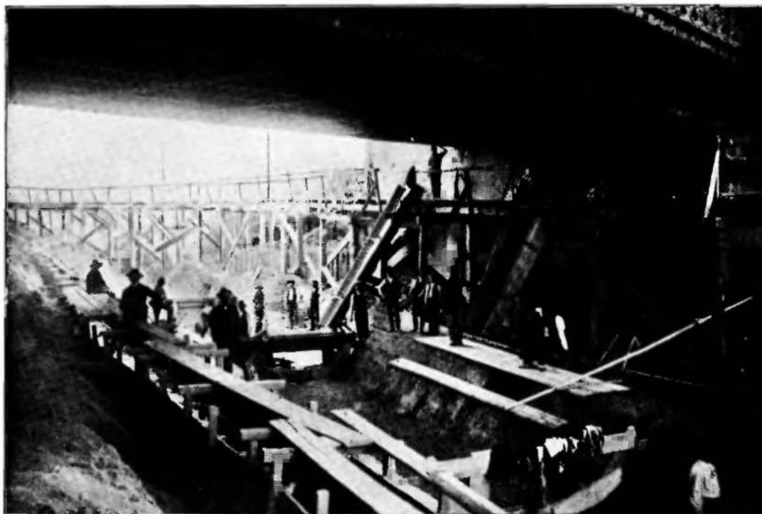
Fot. 7. Fundamentowanie mostu na nowem korycie Rudawy w km 3.7.
