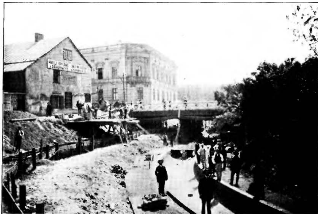
Fot. 11. Budowa dna zasklepienia starego koryta Rudawy powyżej dawnego mostu w ulicy Wolskiej.
