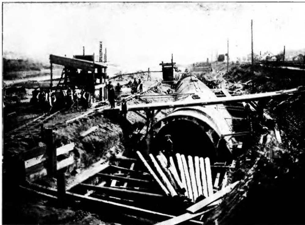
Fot. 13. Budowa kolektora lewobrzeżnego w Grzegórkach.
