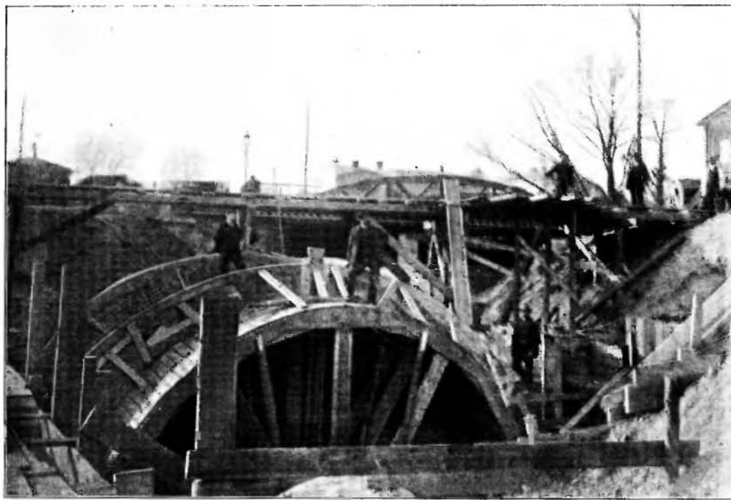
Fot. 9. Rusztowanie pod zasklepiecie starego koryta Rudawy przy ul. Retoryka.
