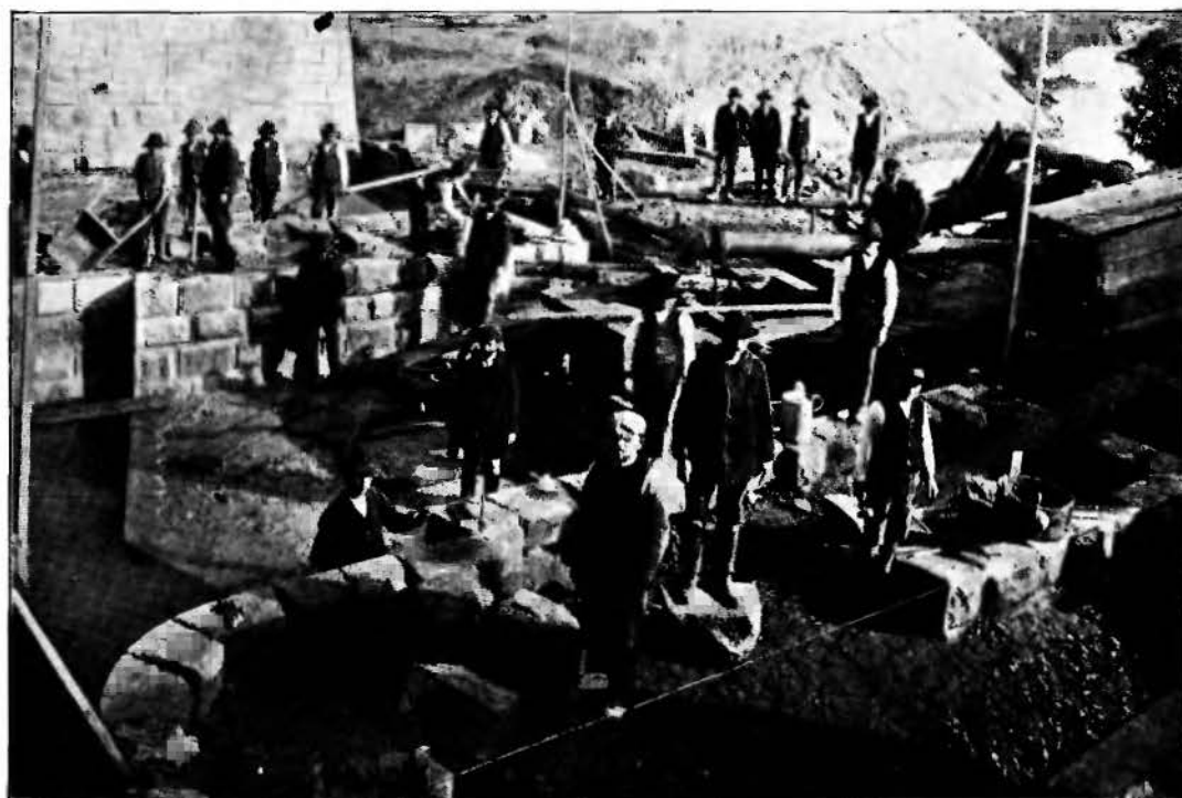
Fot. 8. Budowa dna zasklepienia starego koryta Rudawy pod dawnym mostem na ul. Zwierzynieckiej.
