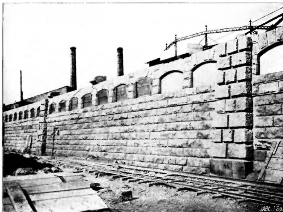
Fot. 18. Lewy wyższy mur bulwarowy.
