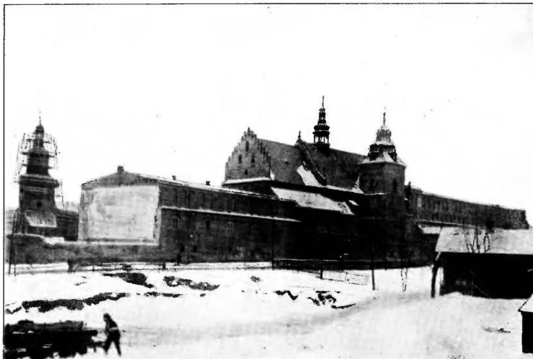
Fot. 1. Widok klasztoru PP. Norbertanek na Zwierzyncu przed rozpoczęciem budowy nowego koryta Rudawy.
