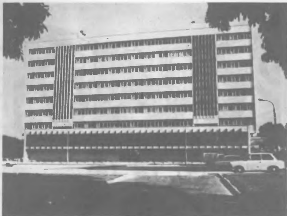
Budynek Wydziału Mechanicznego przy ul. Nadbystrzyckiej
