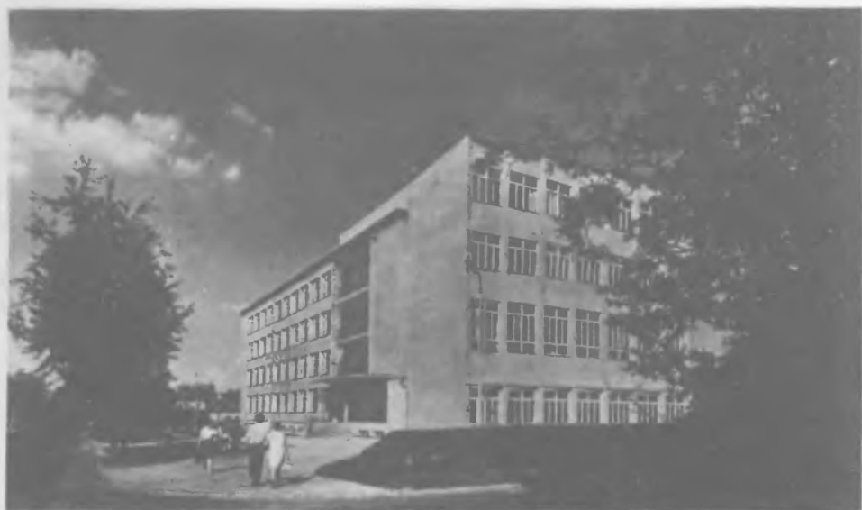
Budynek Wydziału Elektrycznego przy ul. Nadbystrzyckiej
