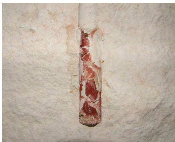
Rys. 9.9 Zakończone niepowodzeniem tłoczenie preparatu I
