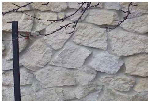
Rys. 5.7 Mur wykonany z kamienia łamanego sortowanego
