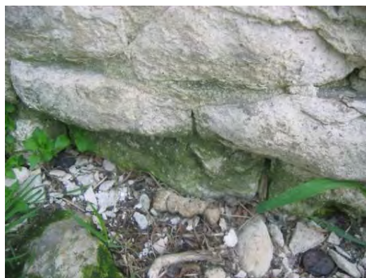
Rys. 13.22 Elewacja zachodnia. Pas przyziemia.
