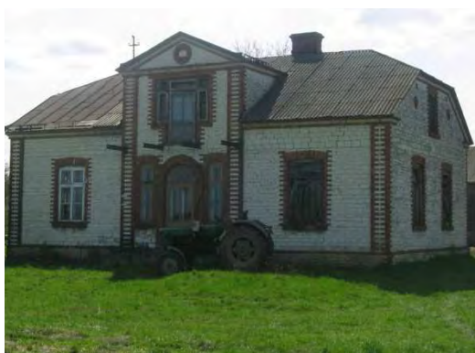
Rys. 5.26 Budynek jednorodzinny. Gmina Trawniki.
