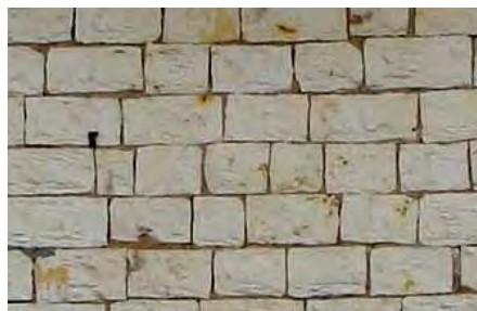
Rys. 5.13 Mur wykonany z kamienia łupanego rzędowo
