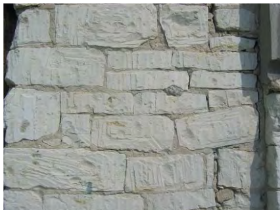
Rys. 13.19 Wątek murowy. Fragment elewacji południowej
