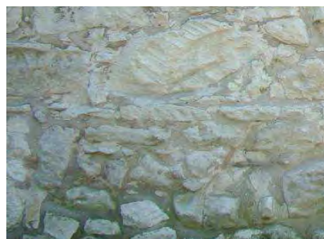
Rys. 5.5 Mur wykonany z kamienia łamanego niesortowanego
