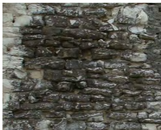
Rys. 13.16 Rozwój porostów na licu muru.
