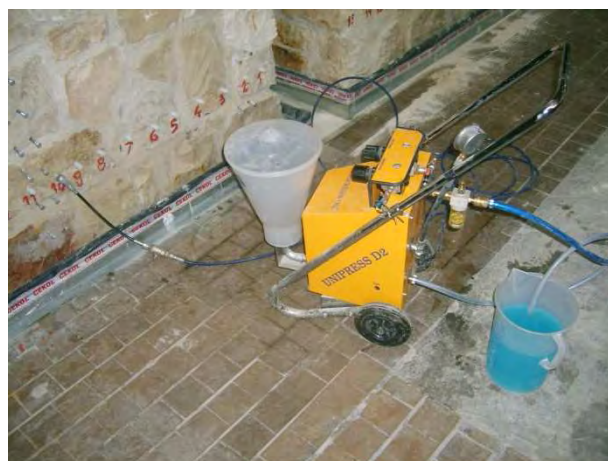
Rys. 10.21 Iniekcja muru emulsją silikonową
