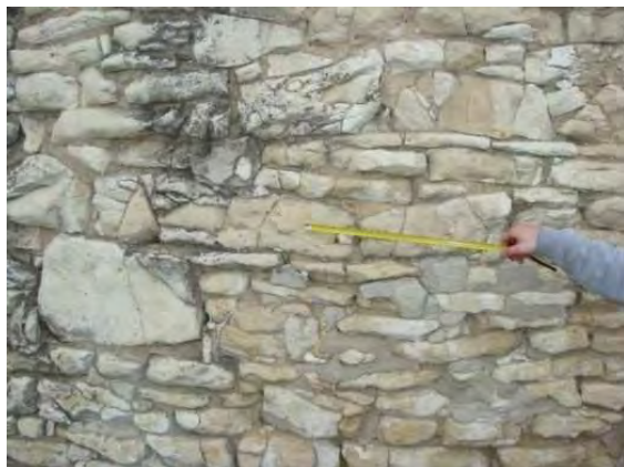
Rys. 13.11 Wątek murowy. Układ warstwowy.
