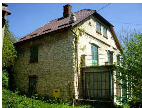
Rys. 5.20 Budynek wolnostojący w Kazimierzu Dolnym
