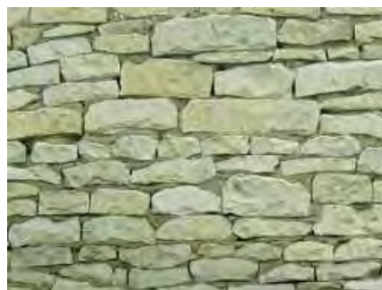
Rys. 5.11 Mur wykonany z kamienia łupanego warstwowo
