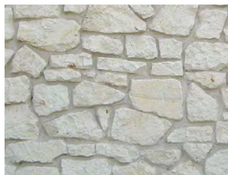
Rys. 5.9 Mur wykonany z kamienia łamanego przycinanego
