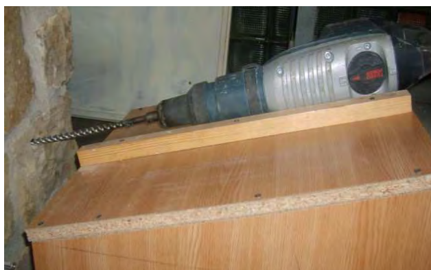
Rys. 10.16 Przygotowanie otworów pod iniekcję
