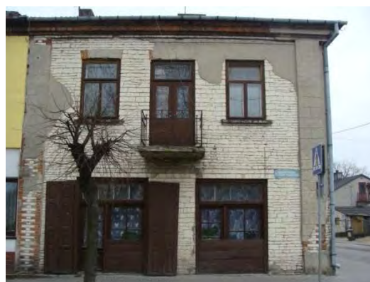
Rys. 5.23 Budynek w zabudowie pierzejowej. Piaski
