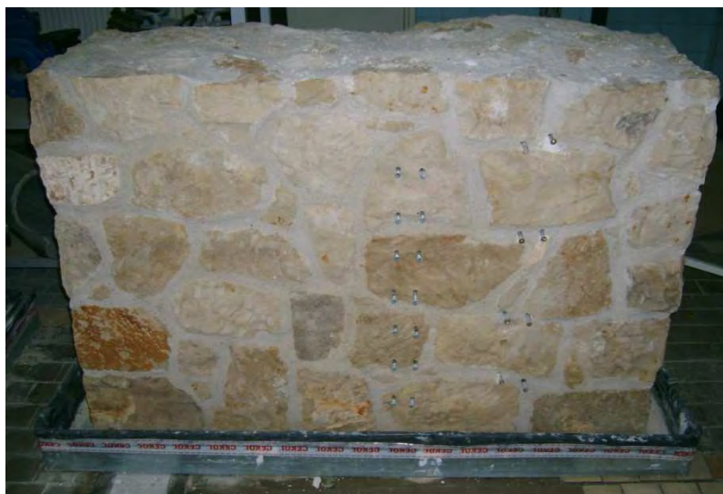
Rys. 10.10 Widok zamontowanych sond igłowych w murze
