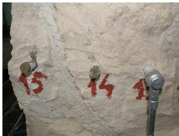
Rys. 10.19 Tłoczenie zaprawy trasowej
