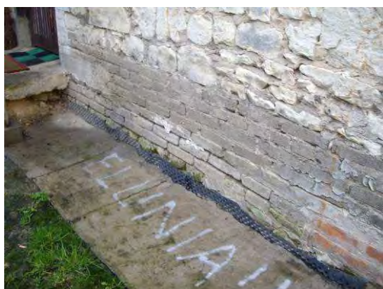
Rys. 13.5 Folia kubelkowa pełniąca rolę izolacji pionowej
