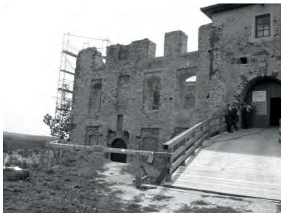
II. 10. Widok na ścianę północną zamku dolnego od zewnątrz, lipiec 2011.
