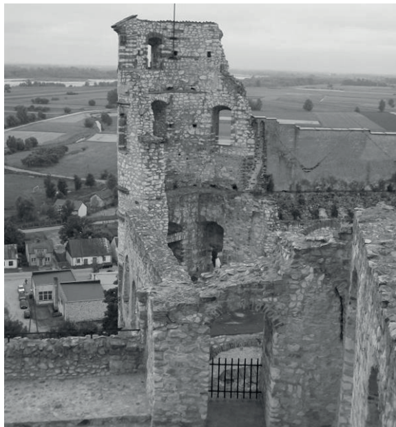
Fot. 7. Janowiec. Zamek. Wieża wschodnia widok z budynku bramnego – 2011 r.
