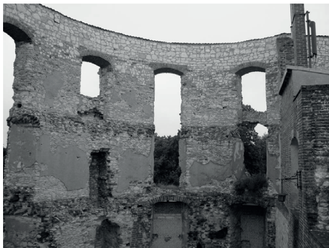
Fot. 13. Janowiec. Zamek- Basteja Wielka fragment zachowanej ściany z odtwarzaną koroną i umieszczonym w niej wieńcem żelbetowym – 2011 r.
