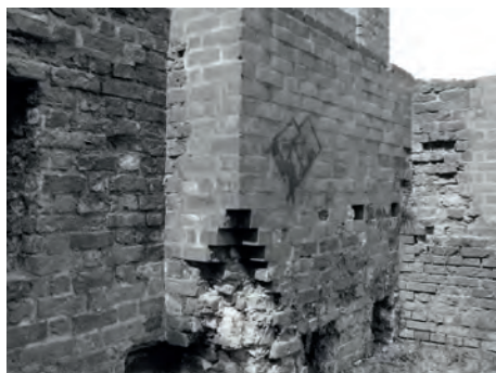
Rys. 16. Fragmentaryczna rekonstrukcja ściany północno-zachodniej budynku mieszkalnego wyraźnie odróżnialna na podstawie użytego materiału, kwiecień 2012 r.
