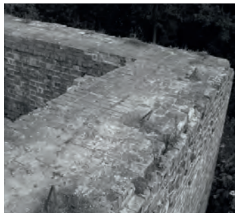
Rys. 4. Stan koron zabezpieczonych przez nadmurowanie szczelnym materiałem.
