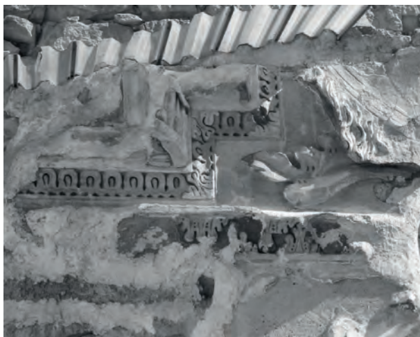
Fot. 1. Janowiec. Zamek. Amfilada południowa (pałac Tarłów) –południowa. Przykład zabezpieczenia trwałego reliktyw dekoracji sztukatorskiej. Daszek z tworzywa sztucznego zamocowany do rusztu – 2011r.
