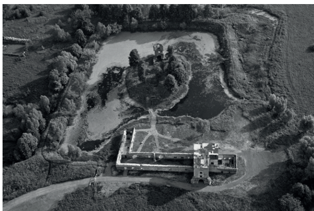
Fot. 16. Ćmielów. Zamek. Fotografia kompleksu zabudowań z lotu ptaka. Widoczne bastiony obronne-2011r. (Materiały dostarczone przez właściciela).
