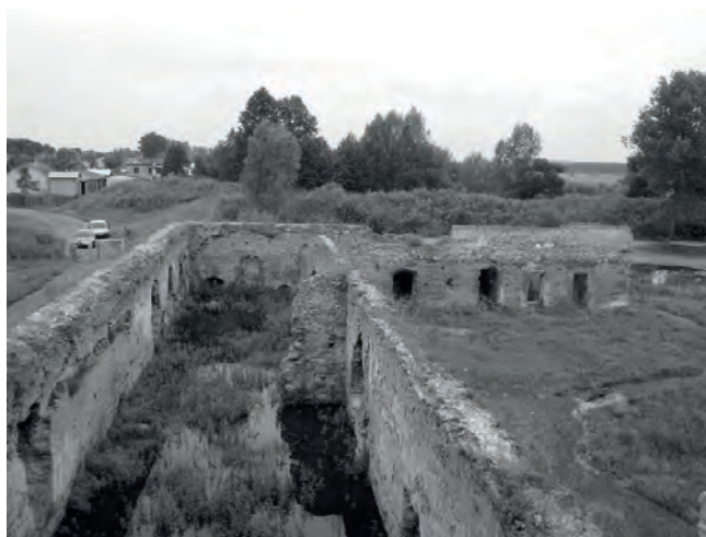
Fot. 11. Ćmielów. Zamek, mury przedzamcza. Ściany wolnostojące i korony murów skrzydła zach.-płn. zamku – 2011 r.
