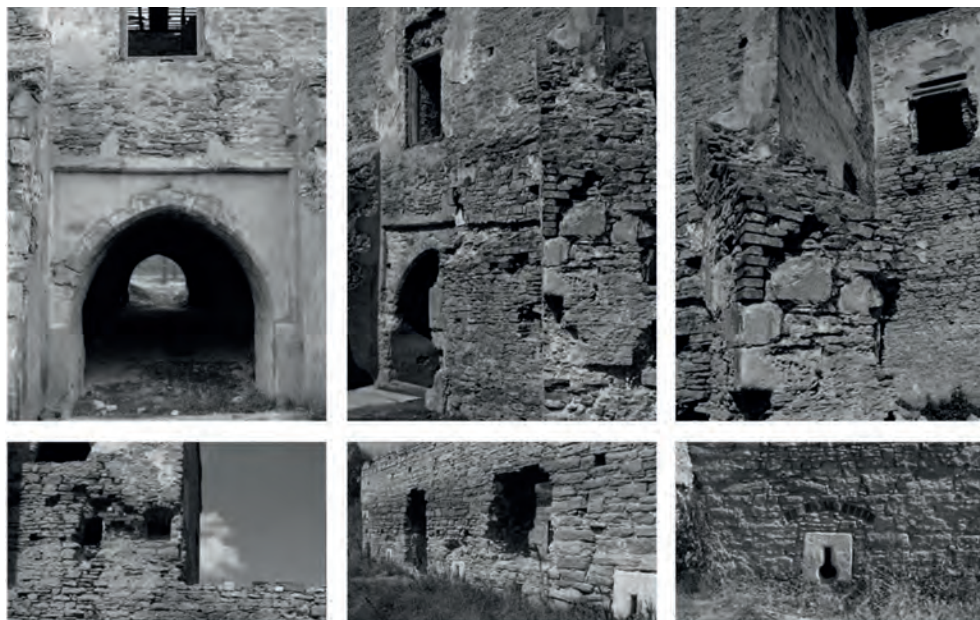
Il. 7. Zamek w Ćmielowie. Przedzamcze. Od strony przedpola fortyfikacji po obu stronach wieży bramnej z przejazdem, kurtyny obronne z dwoma poziomami strzelnic do broni palnej. W przyziemiu kluczowe strzelnice wykuvane w płycie kamiennej, na murach obronnych ganek bojowy z reliktoowo zachowanymi wnękami i strzelnicami, i chodnik z murem przedpiersia. Na ścianach korpusu bramnego zachowane tynki zewnętrzne. Na piętrach części pałacowej oraz w oknach skrzydła zachodniego, fragmenty kamieniarki okiennej. Kamieniarka portalowa śladowo zachowana. Fot. M.L. Lewicka, 2010
