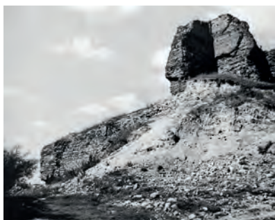
Rys. 6. Widok na naroże wschodnie. Fragment południowo-wschodni. Z. Nawrocki, 1965 r. 9
