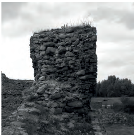
Rys. 14. Podcięty z obu stron wolnostojący fragment muru północno-wschodniego, kwiecień 2012 r.
