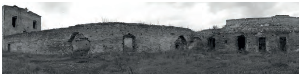
Fot. 12. Ćmielów. Zamek, mury przedzamcza. Panorama zabudowań skrzydła zachodnio- północnego od strony dziedzińca zamku – 2011 r.
