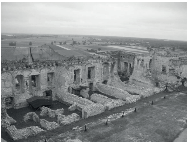
Fot. 8. Janowiec. Zamek –Widok amfiladę południową, 2011 r.
