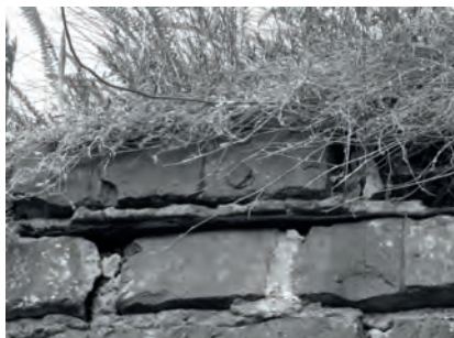
Rys. 1. Widok korony zabezpieczonej przez nadmurowanie z wprowadzoną warstwą izolacji.
