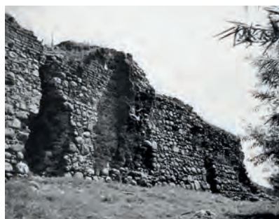
Rys. 5. Mur południowo-zachodni. Widoczna szkarpa zachowana fragmentarycznie przy murze. Z. Nawrocki, 1965 r. 9
