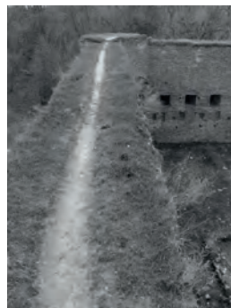
Rys. 17. Korona muru dziedzińca zabezpieczona papą, nadmurowowana i wykończona roślinnością płtykorkorzenną, kwiecień 2012 r.
