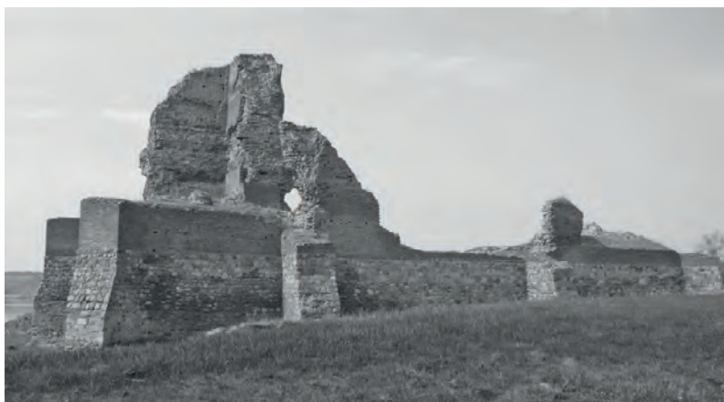
Rys. 16. Stan obecny ruin, widok od strony wschodniej, czerwiec 2011 r.
