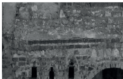
Rys. 6. Zabezpieczenie nadmurowaniem (typ I – wyprofilowanie spadku).
