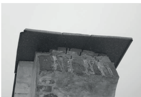
Rys. 7. Przekrycia korony blachą płaską.
