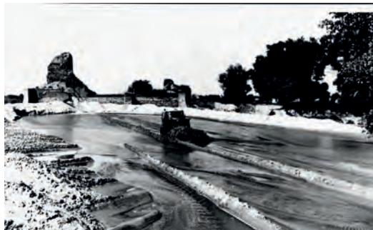
Rys. 11. Zasypywanie koryta bocznego Wisły 24 .
