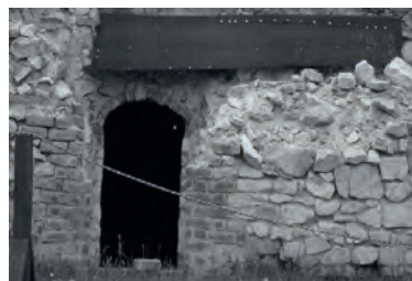
Rys. 10. Zabezpieczenie korony konstrukcją drewnianą z papą bitumiczną
