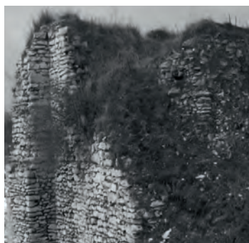
Rys. 20. Fragment oryginalnej partii muru zamku średniego od strony zewnętrznej (widoczna korona muru).
