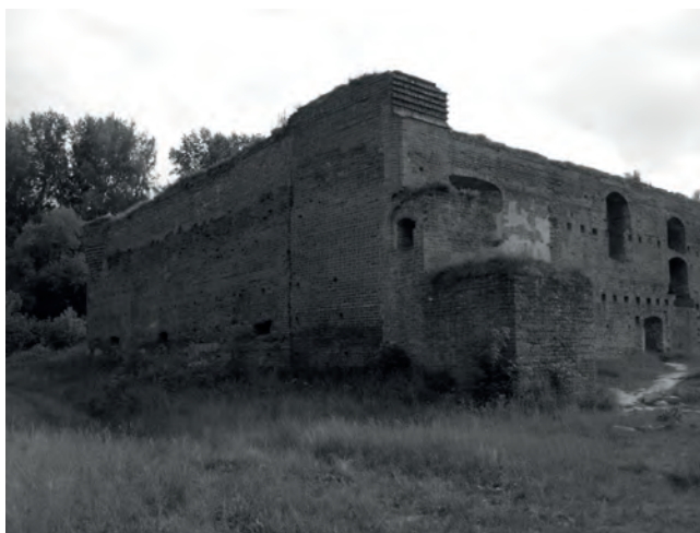
Rys. 1. Widok na zamek Toruń-Dybów od strony północno-zachodniej, czerwiec 2011 r.
