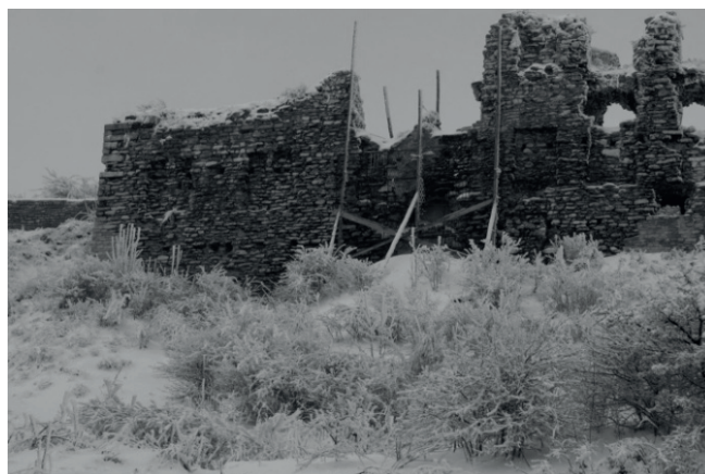
Il. 6. Tymczasowe zabezpieczenie ściany południowej, styczeń 2010 13 .
