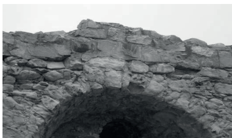
Rys. 5. Zabezpieczenie nadmurowaniem (typ II – nadmurowanie obcym materiałem).
