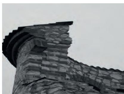
Rys. 8. Zabezpieczenie korony przez nadmurowanie i przekrycie dachówką ceramiczną.
