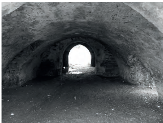
Fot. 8. Ćmielów. Zamek Budynek bramy – historyczne sklepienie kolebkowe – 2011 r.
