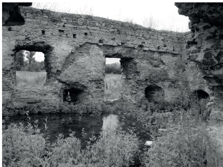
Fot. 13. Ćmielów. Zamek, mury przedzamcza. Lico muru w skrzydle zachodnim – 2011 r.
