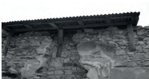
Rys. 9. Zabezpieczenie korony i detalu przez konstrukcją drewnianą z blachą falistą.
