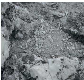
Rys. 19. Struktura niezabezpieczonej korony muru zamku górnego.
