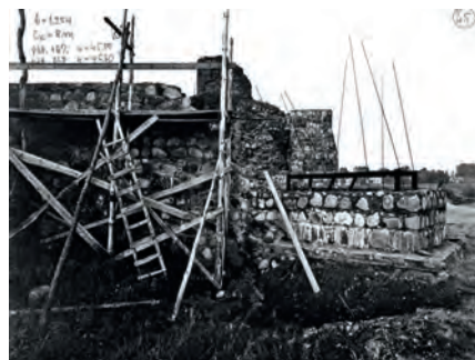
Rys. 10. Zrekonstruowana południowa część muru południowo – zachodniego wraz z przyporą 24 .
