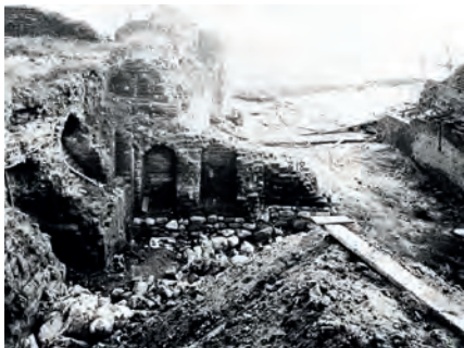
Rys. 9. Negatyw ukazujący prace odkrywkowe w piwnicach budynku mieszkalnego 24 .
