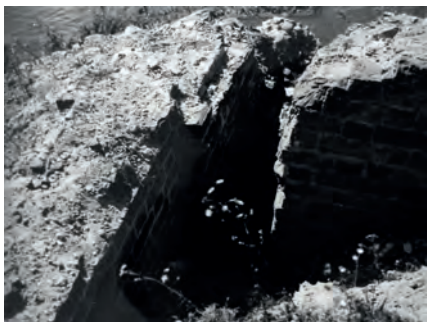
Rys. 12. Fotografia archiwalna ukazująca szczelinę powstałą na skutek odchylenia od pionu muru południowo – wschodniego 25 .
