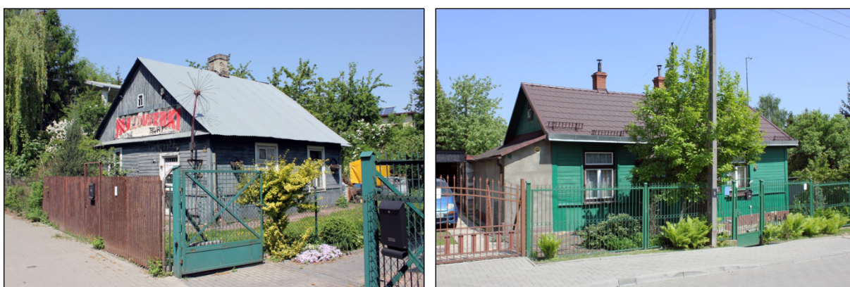
Ilustracja 76. Drewniane domy, przy ul. Ponikwoda 64 i Wielkiej 12 w Lublinie.
