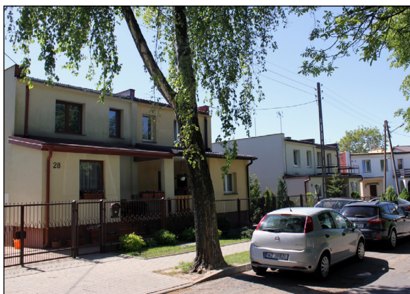
Ilustracja 7. Dom z prefabrykatów wielkowymiarowych w zabudowie bliźniaczej, na terenie osiedla Węglin Północny (część wschodnia – ul. Aksini 28 do 34) i szeregowej na terenie osiedla Węglin Południowy (ul. Podhalańska 43 do 61). Źródło: fotografia autorska – Michał Dmitruk, 2018
