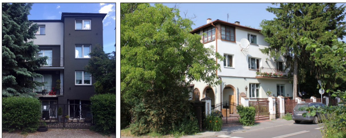
Ilustracja 42. Rozbudowa budynku przy ul. Ruckiego 19 i nadbudowa domku oficerskiego z 1940 roku, przy ul. Powstania Styczniowego 19.
