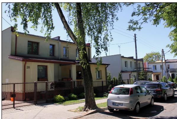
Ilustracja 107. Dom z prefabrykatów wielkowymiarowych w zabudowie bliźniaczej, na terenie osiedla Węglin Północny w Lublinie (część wschodnia – ul. Aksini 28–34).
