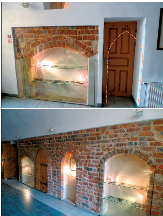
Fot. 3. Muzeum Dawnego Kupiectwa w Świdnicy – ciąg średniowiecznych witryn i kramów odkrytych w trakcie prowadzenia prac remontowo-renowacyjnych. Z powodu braku wyprzedzających badań architektonicznych jeden z gotyckich portali przegrał ze stylizowanymi drzwiami do nowoprojektowanej toalety. Naturalnie zgodnie z obowiązującymi przepisami.
