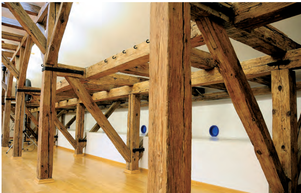
Fot. 11. Fragment konstrukcji więźby dachowej z widocznymi oryginalnymi elementami metalowymi.
