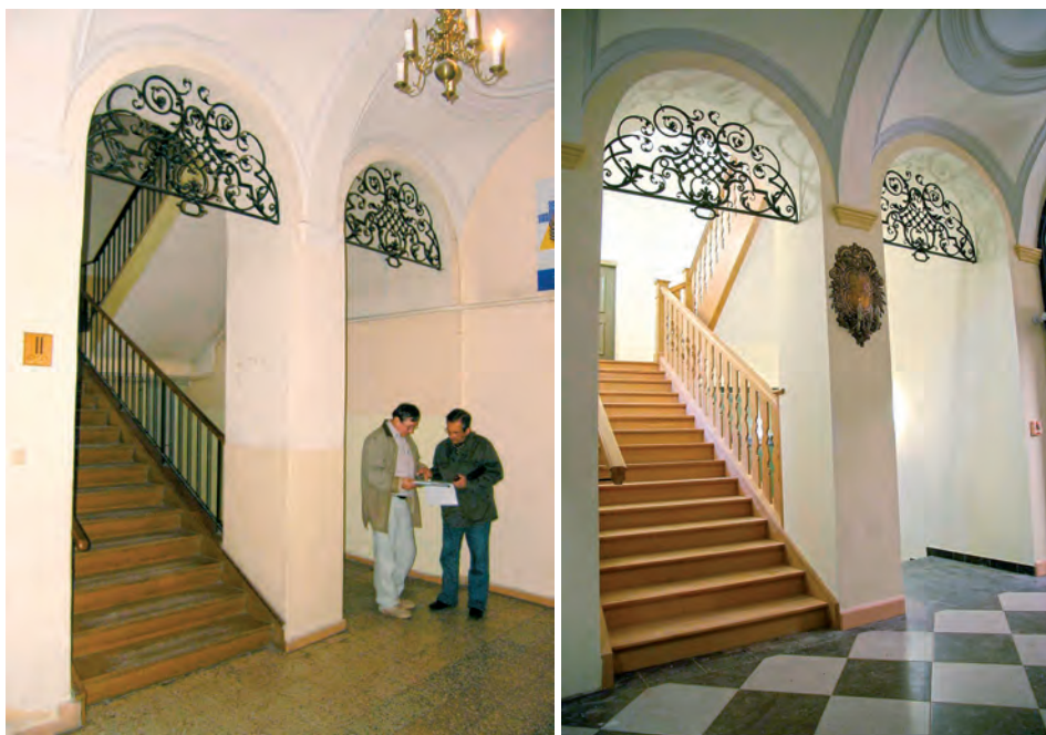
Fot. 6. D. Orphanotropheum, Wrocław, ul. Katedralna 4 – próba przywrócenia pierwotnej, barokowej formy żelbetowej klatki schodowej wykonanej w latach 60-tych XX w. Stan przed i po rewaloryzacji.
