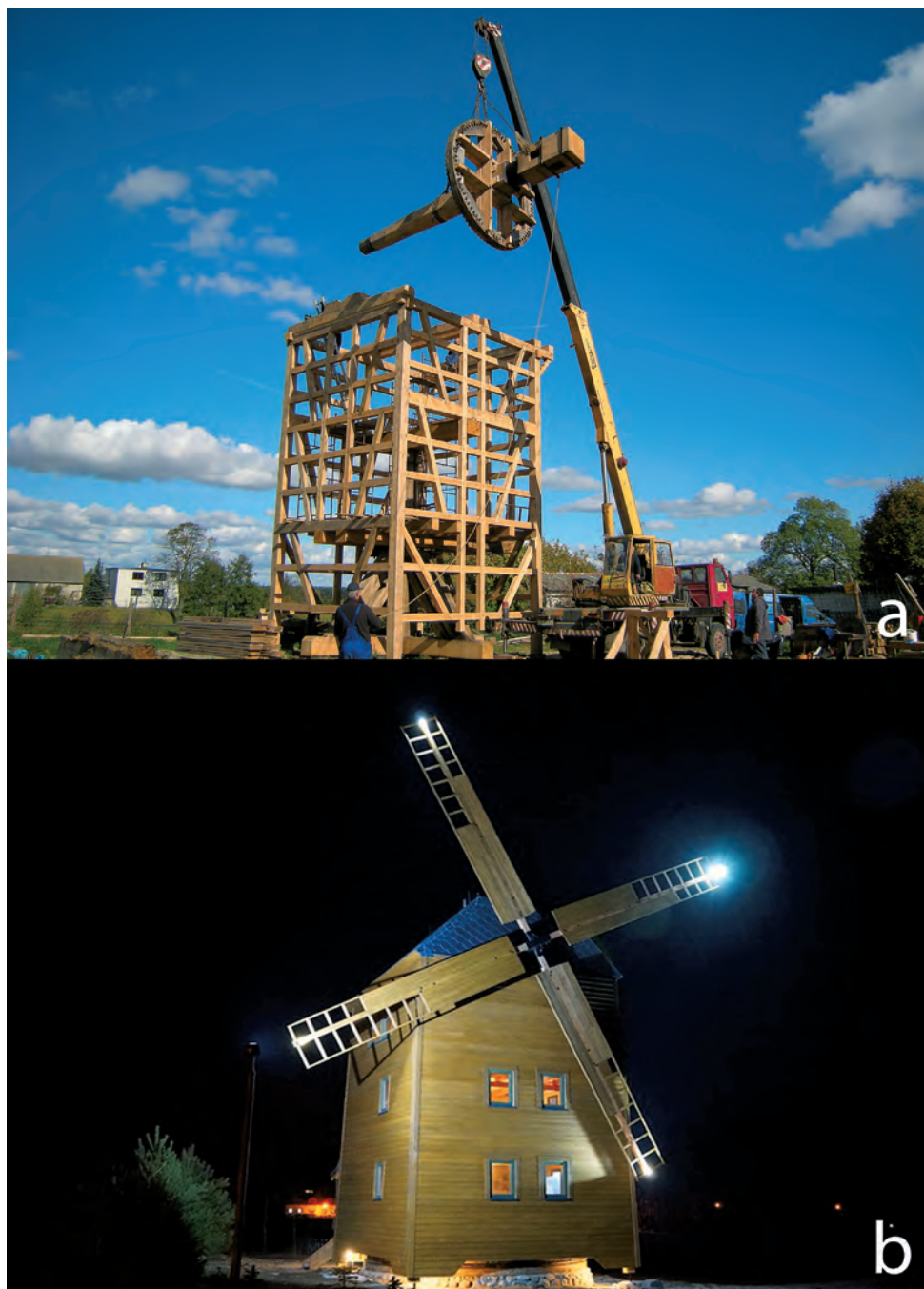
Il. 3. a) Bierzgłowo, pow. toruński. Wiatrak koźlak z 1867 r. po pracach. Widoczna całkowicie nowa konstrukcja młyna (fot. M. Prarat, 2010).
