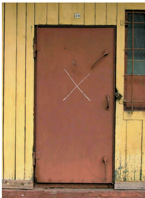
Fot. 5. Proste techniczne detale budowli zabytkowych, oderwane od obiektu tracą istotne wartości historyczne i informacyjne. Na zdjęciu: a) żeliwny, forteczny wentylator mechaniczny z 1905 r. tuż przed rozbiciem i wywiezieniem na złom; b) pancerne drzwi schronowe, przeniesione do drewnianego baraku stanowią jego kłopotliwy, najcięższy element. Krzyżyk na drzwiach oznacza „przeznaczone do kasacji”.
