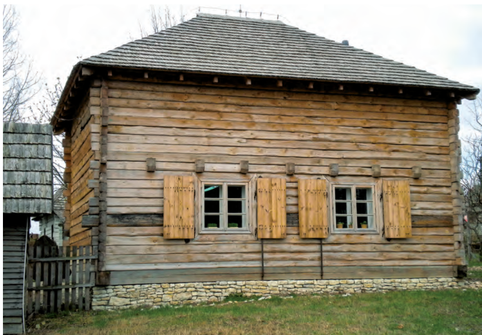
Il. 4. Spichlerz klasztorny z Chęcina – w MWK pełni funkcję kasy i galerii sztuki ludowej – wycięte okna w ścianie północnej – inwestycja zrealizowana ze środków unijnych. Fot. L. Gawlik.
