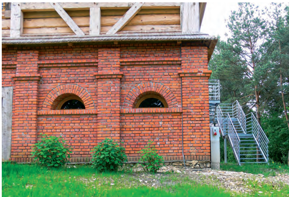
Il. 3. Spichlerz dworski z Rogowa (XVIII w.) w MWK w trakcie realizacji – schody ewakuacyjne, widoczne instalacje elektryczna, odgromieniowa – inwestycja realizowana z dotacji unijnych. Fot. E. Radziszewska.
