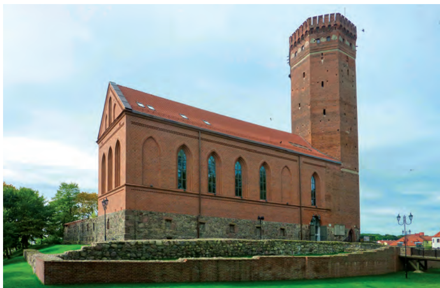
Ryc. 3. Bryła zamku po przeprowadzonych pracach (2013, fot. I. Dzierżko-Bukal).
