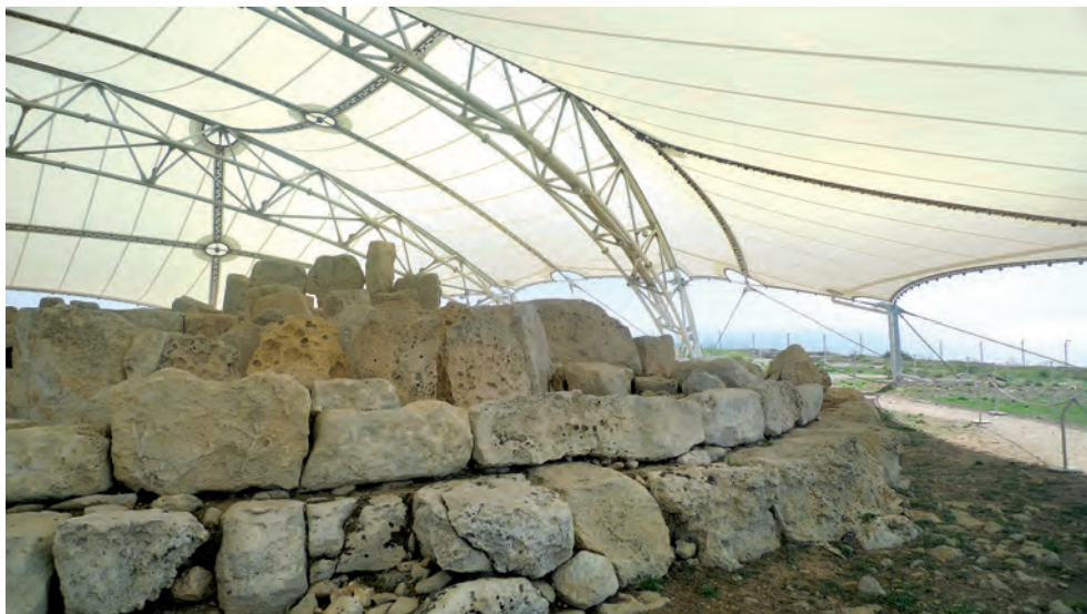
Fot. 10. Malta, ruiny megalitycznej świątyni – zabezpieczone neutralnym i odwracalnym zadaszaniem.
