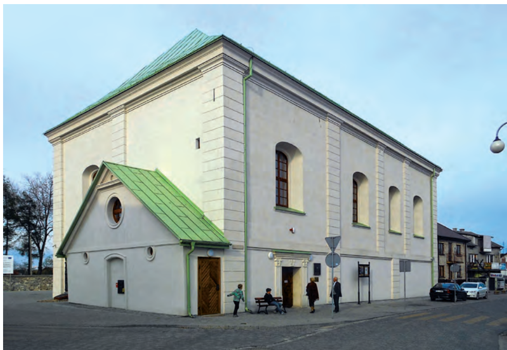
Ryc. 6. Chmielnik. Synagoga. Stan po restauracji, Fot. Własna
