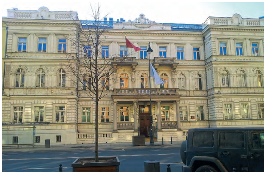
Fot. 5. Elewacja frontowa Kamienicy Bernsteina, Al. Ujazdowskie 41.
