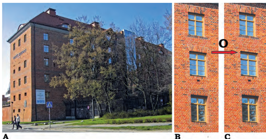
Il. 6. Budynek dawnych koszar przebudowany na Hotel Bulwar; Toruń.
