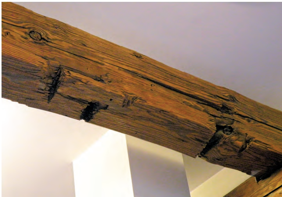
Fot. 7. Ślady po odłamkach w drewnianej belce
