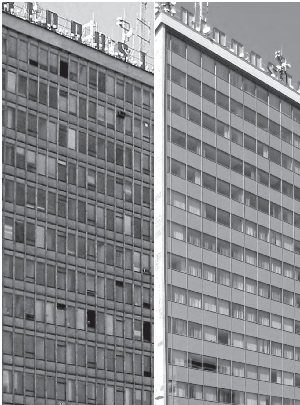
Il. 3. Budynek biurowy „Biprostal” przed modernizacją, rok 2002. Zdjęcie lewe (fot. Autor).
