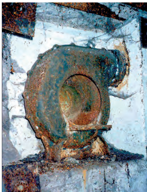
Fot. 5. Proste techniczne detale budowli zabytkowych, oderwane od obiektu tracą istotne wartości historyczne i informacyjne. Na zdjęciu: a) żeliwny, forteczny wentylator mechaniczny z 1905 r. tuż przed rozbiciem i wywiezieniem na złom; b) pancerne drzwi schronowe, przeniesione do drewnianego baraku stanowią jego kłopotliwy, najcięższy element. Krzyżyk na drzwiach oznacza „przeznaczone do kasacji”.
