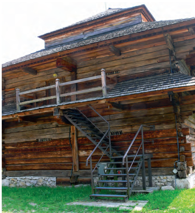
Il. 2. Spichlerz dworski ze Złotej (XVIII w.) – w MWK pełni funkcje ekspozycyjne – współczesne schody ewakuacyjne, widoczne instalacje elektryczna, odgromieniowa. Fot. E. Radziszewska.
