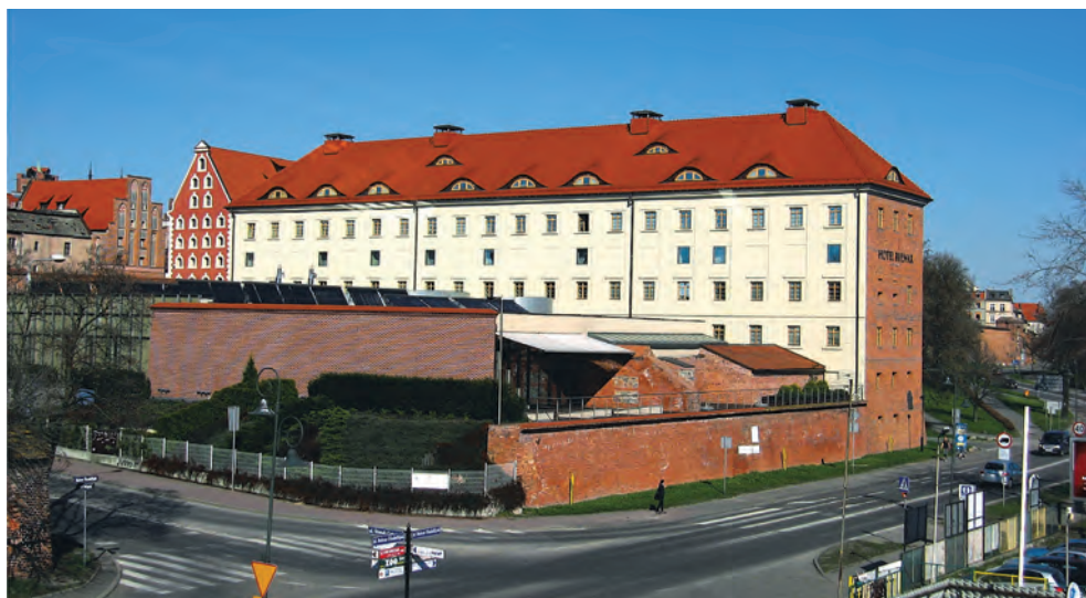
Il. 5. Budynek dawnych koszar przebudowany na Hotel Bulwar; Toruń.
