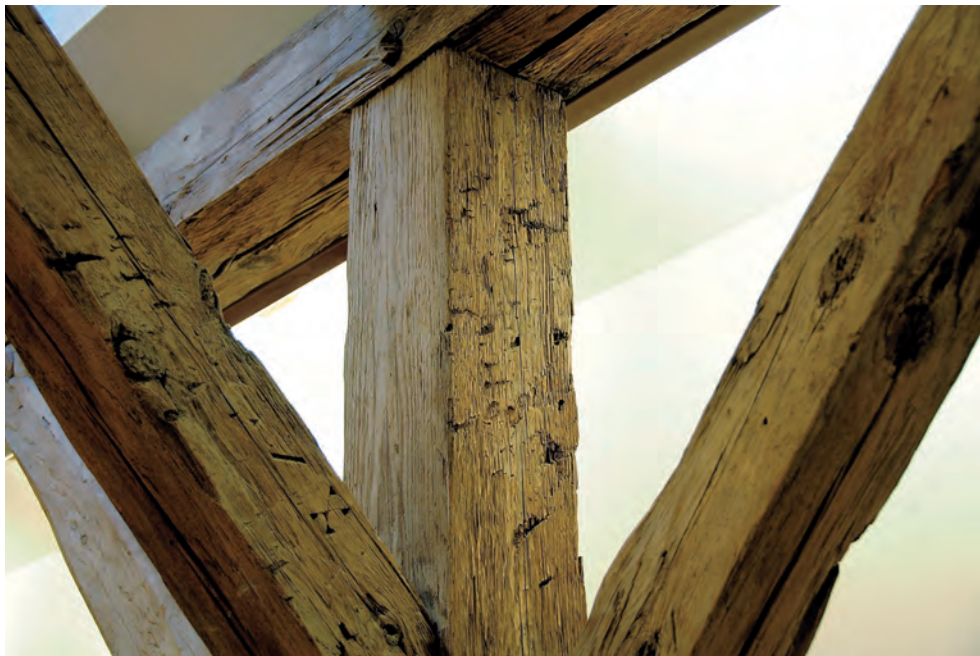
Fot. 13. Ślady po odłamkach pocisków oraz widoczne znaki ciesielskie
