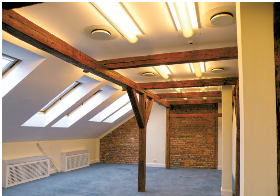
Fot. 6. Widok ogólny pomieszczenia poddasza po adaptacji na biuro.
