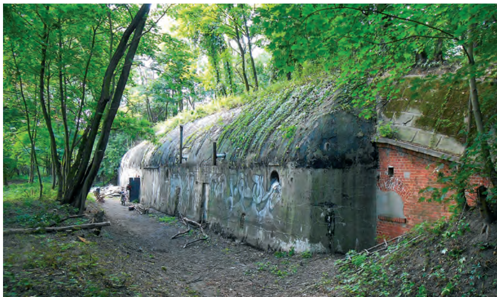
Il. 6. Betonowy płaszcz rozbudowanego schronu piechoty.
