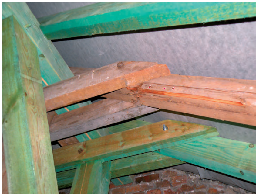
Fot. 2. Zachowana krokiew i kleszcze wkomponowane w nową więźbę dachową.
