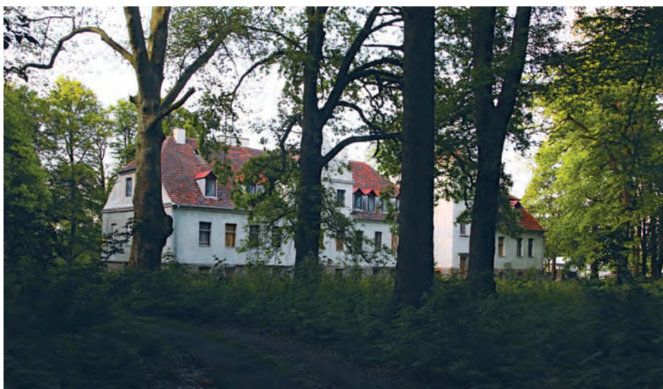
Fot. 1. Park dworski w Radzikowie – roślinność, która uległa nadmiernemu zagęszczeniu zarasta ścieżki i przysłania budynek dworu, fot. Ł. Woźniak.
