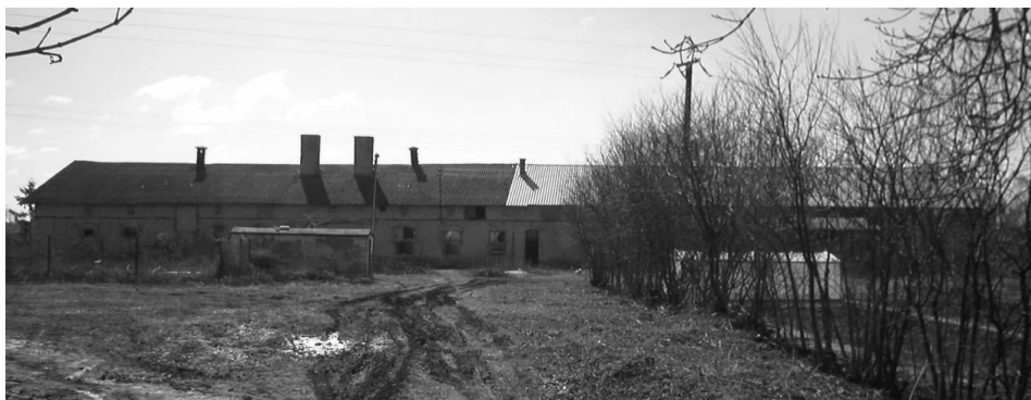
Ryc. 149. Jabłonna. Widok od strony południowej. Stan w 2004 roku. Fot. autor.
