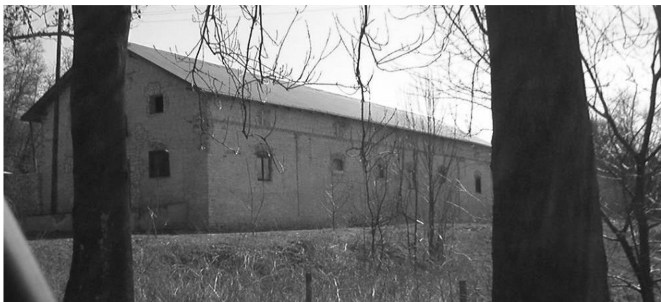
Ryc. 156. Jabłonna. Widok elewacji obory od strony wschodniej. Stan w 2004 roku. Fot. autor.
