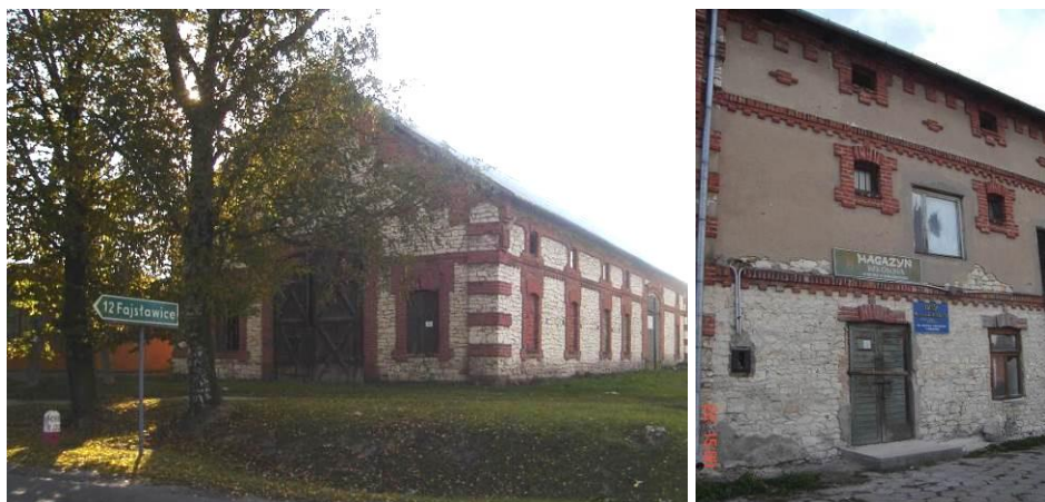
Ryc. 282. Przykłady elewacji budynków folwarcznych. Fot. autor.
