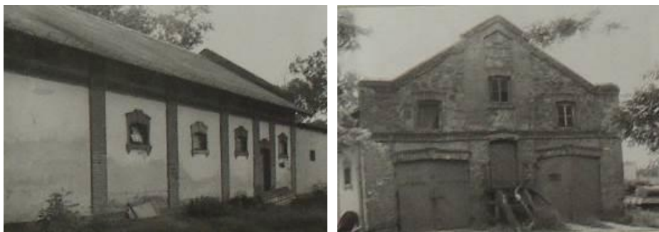
Ryc. 220. Podlodów, stajnia z wozownią. Stan w 1994 roku. Fot. M. Adrałojć.
