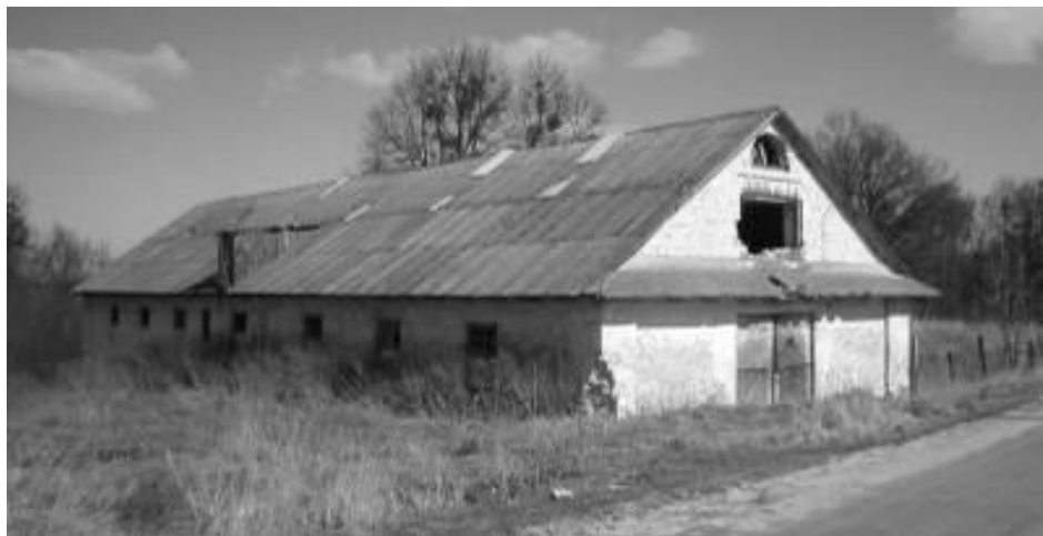
Ryc. 206. Pilaszkowice, widok na oborę od strony południowej. Stan w 2003 roku. Fot. autor.
