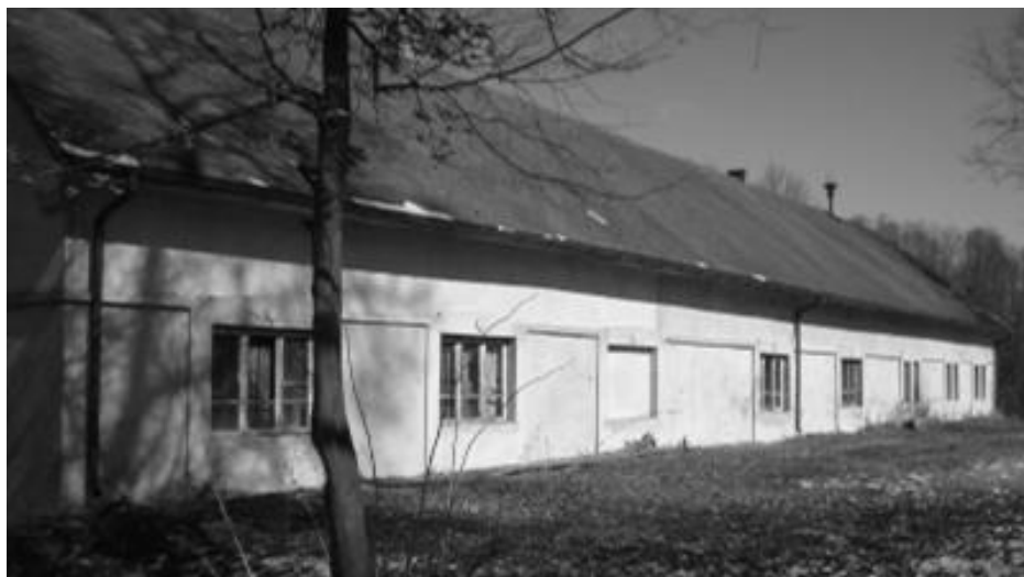
Ryc. 236. Stryj, dawna stajnia z wozownią. Stan w 2004 roku. Fot. autor.
