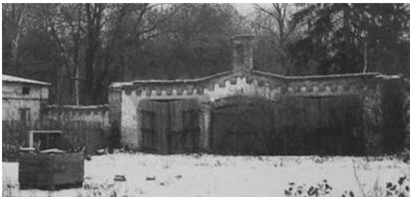
Ryc. 184. Łysołaje, budynek wozowni. Stan w 1995 roku. Fot. I. Synowska, P. Synowski.
