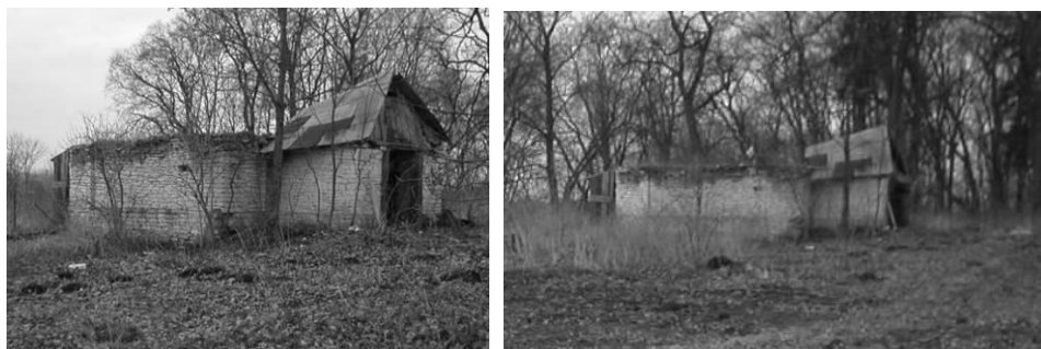
Ryc. 106. Brzezice, lodownia, widok elewacji północnej. Stan w 2003 roku. Fot. autor.
