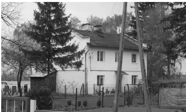
Ryc. 179. Łysołaje, budynek mieszkalny pracowników gorzelni. Stan w 2006 roku. Fot. autor.
