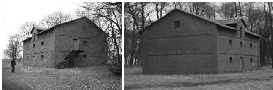
Ryc. 84. Bojanówka, Spichlerz, widok elewacji wschodniej i zachodniej. Stan w 2005 roku. Fot. autor.
