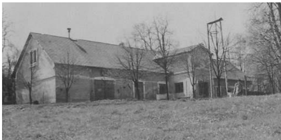
Ryc. 238. Stryjno, stajnia z wozownią. Stan w 1988 roku. Fot. Z. Pastuszek
