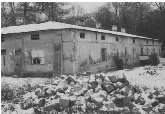
Ryc. 182. Łysołaje, pierwotnie stajnia, później spichlerz, obecnie budynek mieszkalny. Stan w 1995 roku. Fot. I. Synowska, P. Synowski.
