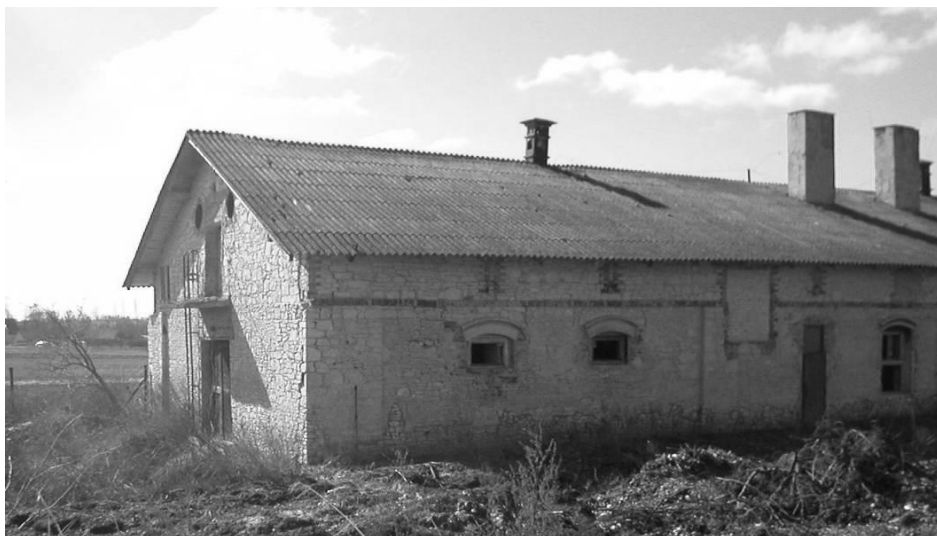
Ryc. 150. Jabłonna. Fragment elewacji południowej. Stan w 2004 roku. Fot. autor.
