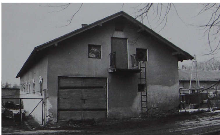
Ryc. 151. Jabłonna. Widok elewacji obory od strony wschodniej. Stan w 1988 roku. Fot. W. Boruch.
