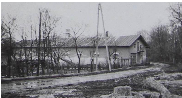
Ryc. 152. Jabłonna. Widok elewacji obory od strony wschodniej. Stan w 1988 roku. Fot. W. Boruch.
