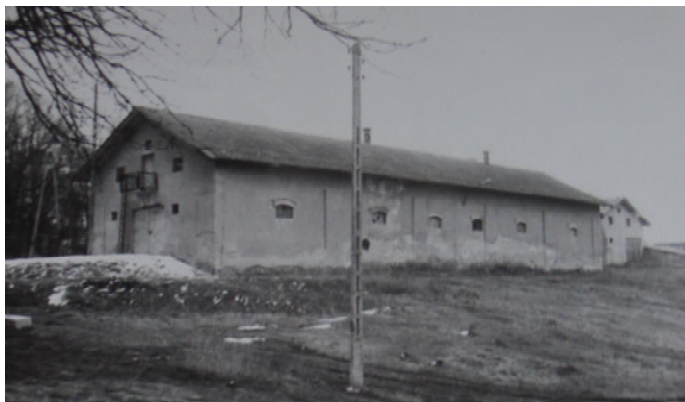
Ryc. 155. Jabłonna. Widok elewacji obory od strony wschodniej. Stan w 1988 roku. Fot. W. Boruch.
