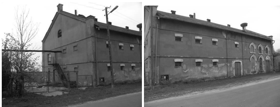
Ryc. 175. Łysołaje, budynek gorzelni. Stan w 2006 roku. Fot. autor.
