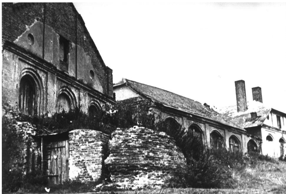
Ryc. 114. Bystrzyca, obora, wozownia i fragment stajni. Stan w 1986 roku. Fot. W. Rusin.
