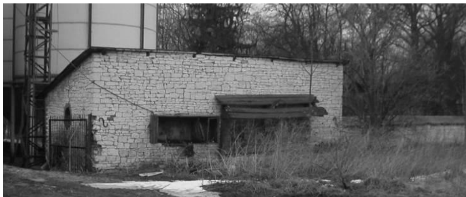
Ryc. 101. Brzeżice, stelmarnia, widok elewacji północnej. Stan w 2003 roku. Fot. autor.
