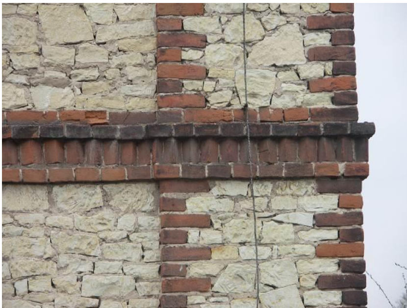
Ryc. 280. Przykład gzymsu ceglanego. Fot. autor.
