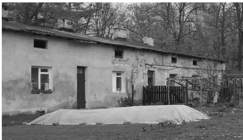
Ryc. 183. Łysołaje, pierwotnie stajnia, obecnie budynek mieszkalny. Stan w 2006 roku. Fot. autor.
