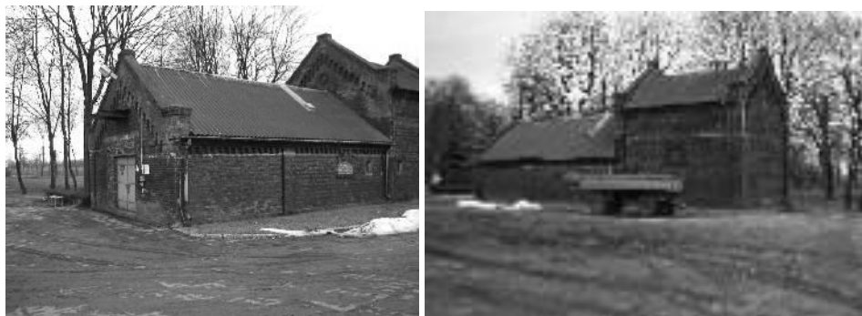
Ryc. 82. Bojanówka, magazyn spirytusu, elewacje. Stan w 2005 roku. Fot.. autor.
