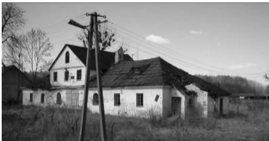
Ryc. 210. Pilaszkowice, budynek gorzelni, widok od strony południowej. Stan w 2003 roku. Opr. autor.
