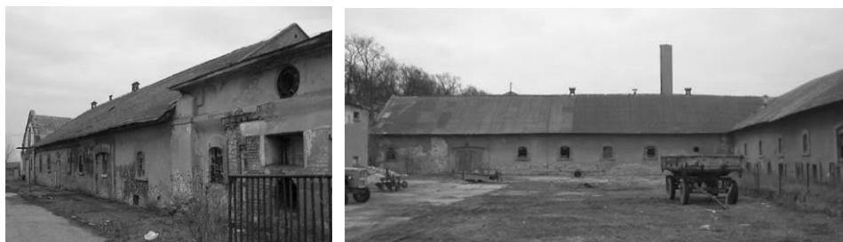
Ryc. 91. Brzezice, stajnia koni pociągowych, widok elewacji północnej i południowej (odokoło). Stan w 2003 roku. Fot. autor.
