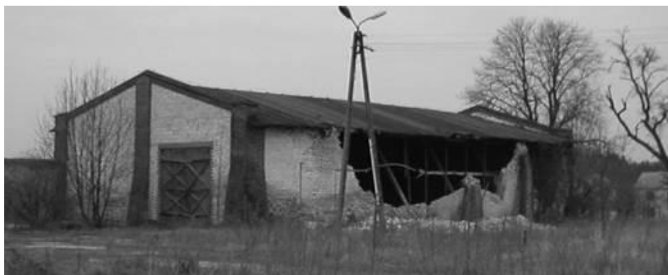
Ryc. 97. Brzezice, stodoła, widok elewacji północnej i zachodniej. Stan w 2003 roku. Fot. autor.
