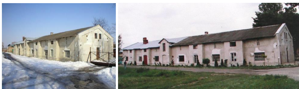
Ryc. 257. Wierchowiska, stajnia. Stan w 2003 roku. Fot. autor.
