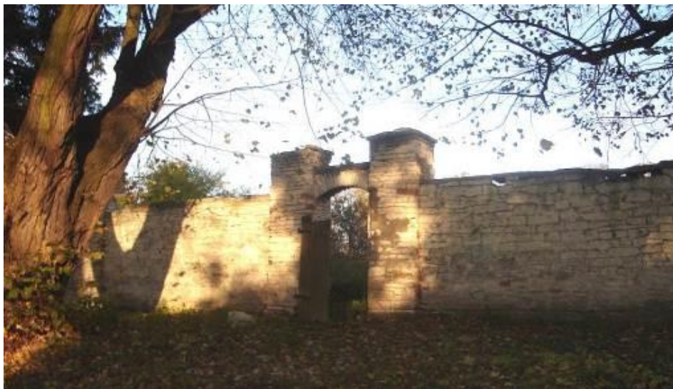
Ryc. 64. Furta w murze pomiędzy zespołem pałacowym, a folwarkiem w Gardzienicach. Stan w 2005 roku. Fot. autor.
