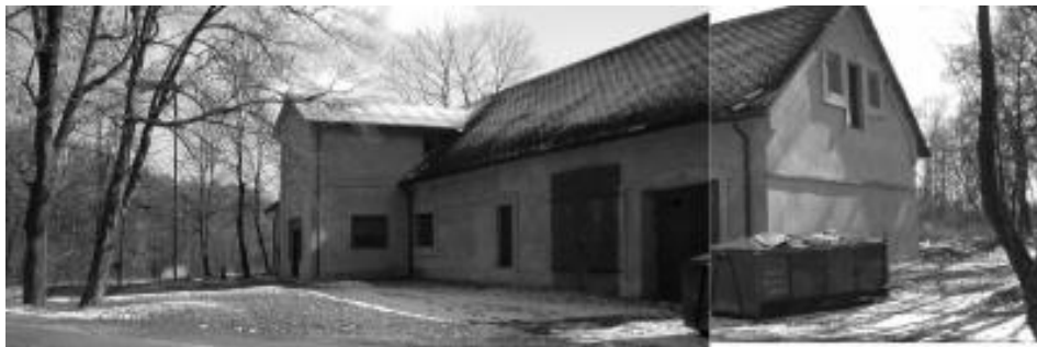
Ryc. 235. Stryj, dawna stajnia z wozownią. Stan w 2004 roku. Fot. autor.
