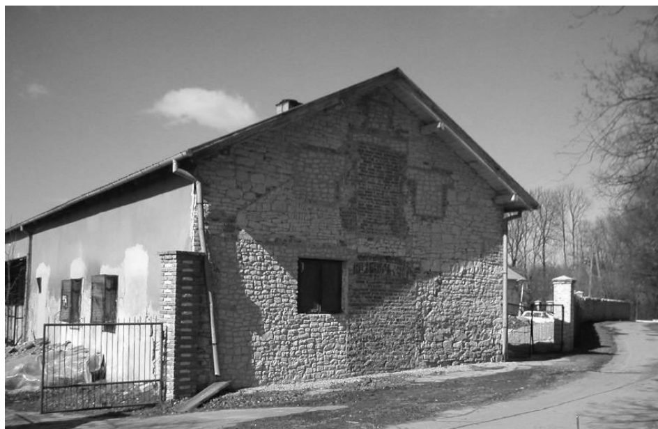
Ryc. 154. Jabłonna. Widok elewacji obory od strony wschodniej. Stan w 2004 roku. Fot. autor.
