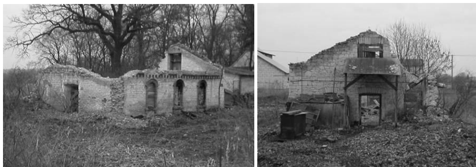
Ryc. 103. Brzezice, kuźnia, widok narożnika południowo-wschodniego i elewacji północnej. Stan w 2003 roku. Fot. autor.
