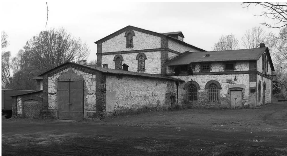
Ryc. 187. Milejów. Widok budynku gorzelni od strony północno wschodniej. Stan w 2005 roku. Fot. autor.
