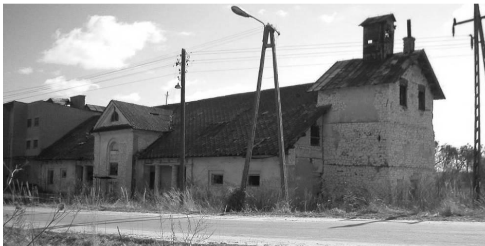
Ryc. 204. Pilaszkowice, elewacja frontowa spichlerza, Stan w 2003 roku. Fot. autor.
