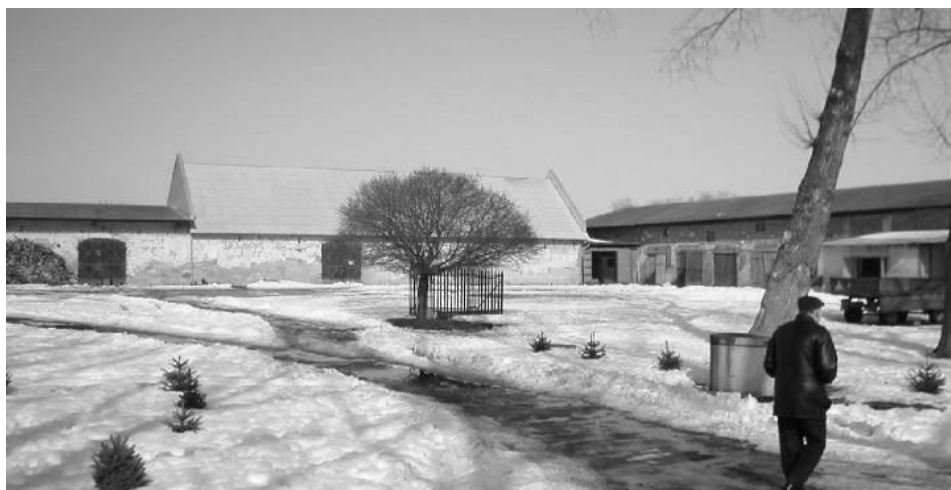
Ryc. 261. Wierchowiska, widok stodoły od strony okołu gospodarczego. Stan w 2003 roku. Fot. autor.
