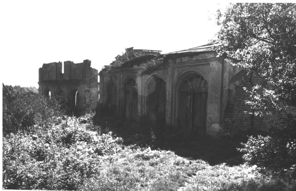
Ryc. 113. Bystrzyca, wozownia. Stan w 1986 roku. Fot. W. Rusin.
