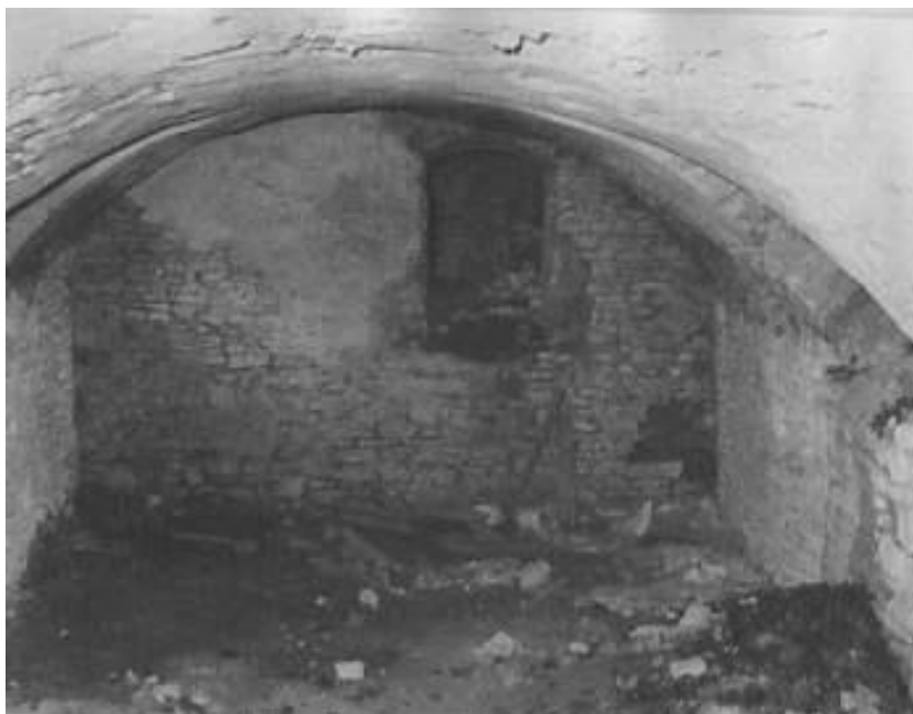
Ryc. 136. Jabłonna. Sklepienie kolebkowe w piwnicy budynku gospodarczego. Stan w 1996 roku. Fot. P. Wołyniak.
