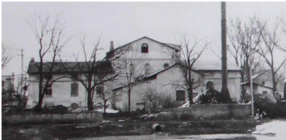
Ryc. 167. Jabłonna. Widok elewacji gorzelni od strony północnej. Stan w 1988 roku. Fot. W. Boruch.
