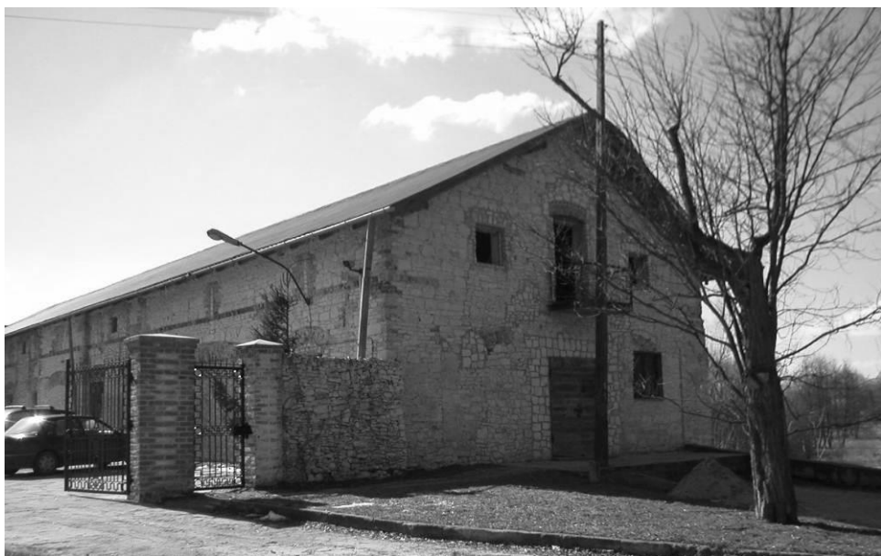
Ryc. 158. Jabłonna. Widok elewacji stajni od strony wschodniej. Stan w 2004 roku. Fot. autor.
