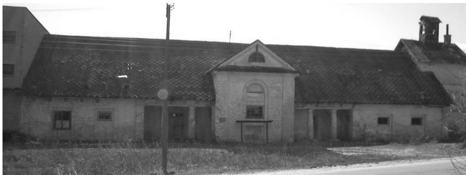
Ryc. 203. Pilaszkowice, elewacja frontowa spichlerza, Stan w 2003 roku. Fot. autor.
