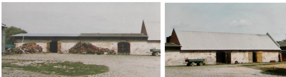
Ryc. 263. Wierchowiska, widok stodoły od stronyokołu gospodarczego. Stan w 2003 roku. Fot. autor.
