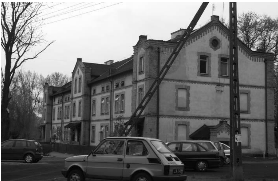
Ryc. 198. Milejów, budynek mieszkalny dla robotników cukrowni. Stan w 2005 roku. Fot. autor.
