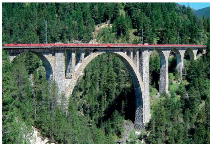
Fot. 5.3.32. Wiadukt kolejowy przez Landwasser pod Wiesen (1903), Szwajcaria. [I.38]
