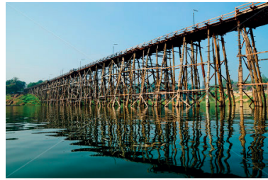
Fot 5.3.14. Przykłady podpór mostowych: a) kaszyce, Chorwacja; b) filary palowe, Tajlandia; [I.22, I.23]
