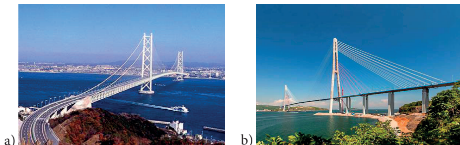
Fot. 5.3.49. Najdłuższe na świecie mosty: a) wiszący – Akashi-Kaikyo, Japonia; [I.62] b) podwieszony – Russky Bridge, Rosja; [I.63]
