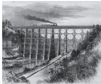
Rys. 5.3.1. Przykłady rozwiązań drewnianych podpór mostowych: a) schemat konstrukcji filara palowego w zależności od typowych wysokości filarów [87], b) rycina podpór kratowych o nietypowej wysokości w moście nad rzeką Genesee w Nowym Jorku, USA; [I.21]
