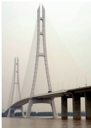
Fot. 7.1.6. a) Pylon zamocowany w dźwigarze głównym stojący na filarze o znacznie większym przekroju poprzecznym – wizualna smukłość pylonu wyraźnie maleje, Nowy Sad, Serbia; [Ł. Flaga] b) Pylon o kształcie funkcji e^x – wizualna smukłość zwiększona poprzez zachowanie ciągłości przebiegu sił do lustra wody, efekt potęgujący: zbliżenie do siebie ramion pylonu oraz zakończenie szczytu pylonu skosami, Nanjing, Chiny; [Ł. Flaga]
