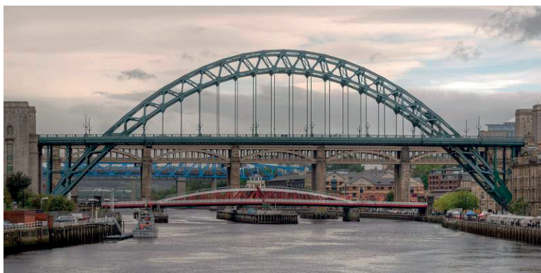
Fot. 5.3.36. Widok obiektu o dźwigarze w postaci łuku sierpowego, którego pasy górny i dolny zbiegają się za punktami podparcia. Newcastle, Anglia; [I.43]
