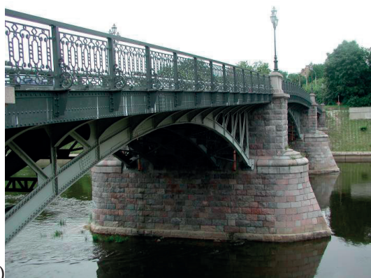
Fot. 5.3.26. Przykład mostu łukowego w Wilnie o kamiennych filarach: a) szkic techniczny (widok z boku, rzut) [46], b) fotografia, Litwa; [Ł. Flaga]
