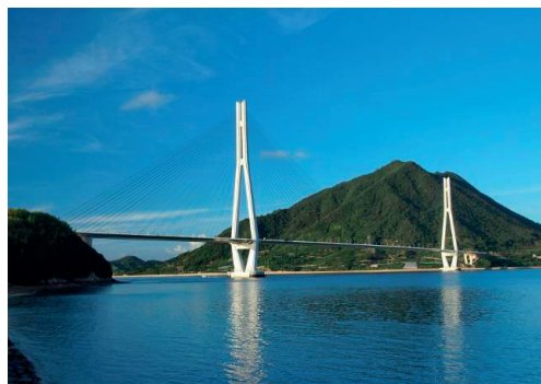
Fot. 5.3.50. Przykład koncentrowania uwagi na środkowej części opracowania (pylonach, olinowaniu oraz pomoście) – kluczach kompozycyjnych w moście podwieszonym Tatara, Japonia; [I.64]
