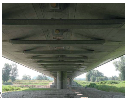
Fot. 5.3.41. Przykład wielokrzywiznowej powierzchni żelbetowego pomostu, Słowenia; [Ł. Flaga]
