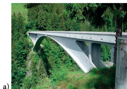
Fot. 7.1.9. Przykłady mostów o wizualnym braku ciągłości konturu dźwigara łukowego: a) most Maillarta, Szwajcaria; [I.98] b) most o linii łuków przenikających się z pomostem, USA; [I.99]
