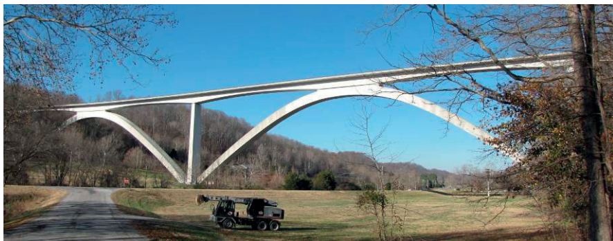
Fot. 5.3.40. Przykład dowolnych możliwości kształtowania konstrukcji żelbetowych, Niemcy; [I.49]
