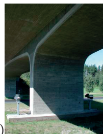
Fot. 5.3.42. Przykłady różnorodnych kształtów filarów żelbetowych, a) ZEA; b) Słowenia; c) USA; d) Rosja; [Ł. Flaga]
