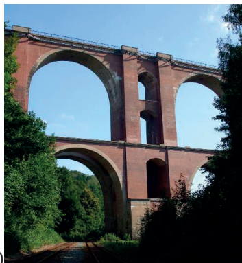
Fot. 5.3.27. Filary mostów kolejowych: a) Króla Karola 1 w kształcie krzywej e^x , Cernavoda, Rumunia; [Ł. Flaga] b) Elstertalbrücke o skokowo zmiennym przekroju w dolinie Elster, Niemcy; [I.33]
