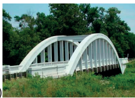
Fot. 5.3.45. Przykłady różnych proporcji dźwigara głównego w zestawieniu z pomostem, opis w tekście; [I.52, I.53, I.54]
