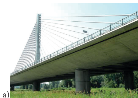
Fot. 5.3.41. Przykład wielokrzywiznowej powierzchni żelbetowego pomostu, Słowenia; [Ł. Flaga]
