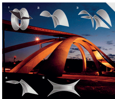
Fot. 5.3.8. Przykład dowolnego ukształtowania dźwigarów z drewna klejonego; most dla pieszych Leonardo da Vinci nad drogą E 18 Oslo, Norwegia; [I.11, I.12]
