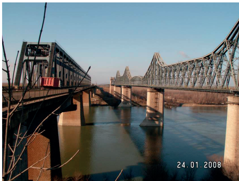
Fot. 6.8.1. Widok wnętrza między mostami, Cernavoda, Rumunia; [I.90]
