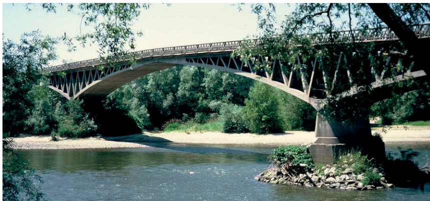
Fot. 5.3.43. Przykład masywnego charakteru ekspresyjności w żelbetowym moście kratowym, Vichy, Francja; [I.50]
