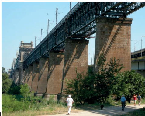
Fot. 5.3.27. Filary mostów kolejowych: a) Króla Karola 1 w kształcie krzywej e^x , Cernavoda, Rumunia; [Ł. Flaga] b) Elstertalbrücke o skokowo zmiennym przekroju w dolinie Elster, Niemcy; [I.33]
