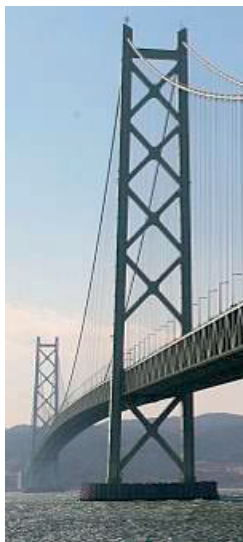
Fot. 5.3.39. Przykłady pylonów: a) ramowego, Chiny; b) skratowanego, Japonia; c) wieloramowego, USA; [I.46, I.47, I.48]
