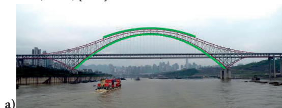
Fot. 7.1.10. Przykłady mostów o złożonych liniach dźwigarów: a) most o płynnie zmiennej linii złożonej z wielu krzywych, Chongqing, Chiny; [Ł. Flaga] b) kładka „Łuk Erośa” o linii złożonej z łuku i dwóch prostych, Polska; [I.100]
