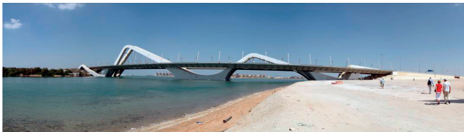
Fot. 7.1.8. Przykład obiektu mostowego o formie łuków dowolnych, Abu Dhabi, ZEA; [Ł. Flaga]
