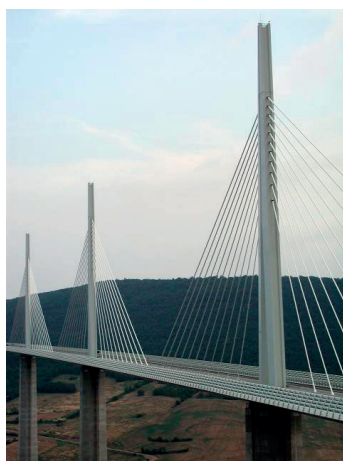
Fot. 7.1.5. Przykład pylonu zamocowanego w dźwigarze głównym o smukłości zmieniającej się wraz z wysokością, wiadukt Millau, Francja; [Ł. Flaga]
