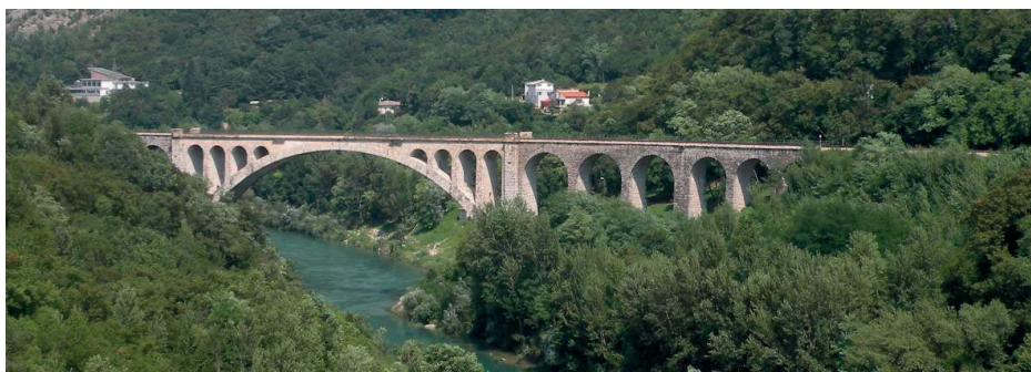
Fot. 5.3.25. Arkadowanie nad konstrukcją głównego sklepienia łukowego w moście kamiennym, Słowenia; [Ł. Flaga]
