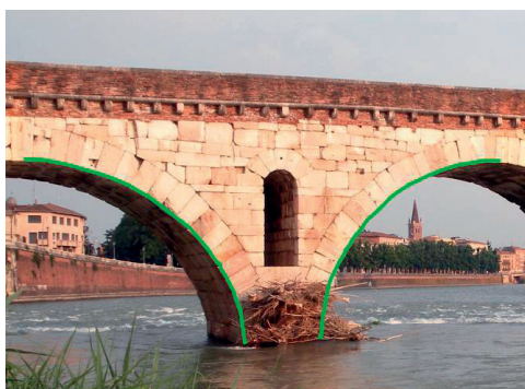
Fot. 5.3.29. Zestawienie porównawcze filarów mostowych z różnych okresów (z wyróżnieniem linii istotnych – konturów podkreślających proporcje i wyraz architektoniczny obiektu): a) XV w., Włochy; [Ł. Flaga] b) XX w., Francja; [I.35]
