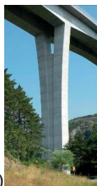
Fot. 5.3.42. Przykłady różnorodnych kształtów filarów żelbetowych, a) ZEA; b) Słowenia; c) USA; d) Rosja; [Ł. Flaga]
