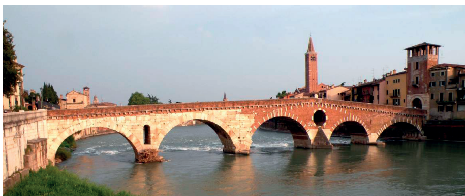
Fot. 5.3.23. Ponte della Pietra przez Adygę w Weronie (XV w.), Włochy; [Ł. Flaga]
