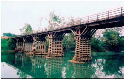
Fot 5.3.14. Przykłady podpór mostowych: a) kaszyce, Chorwacja; b) filary palowe, Tajlandia; [I.22, I.23]
