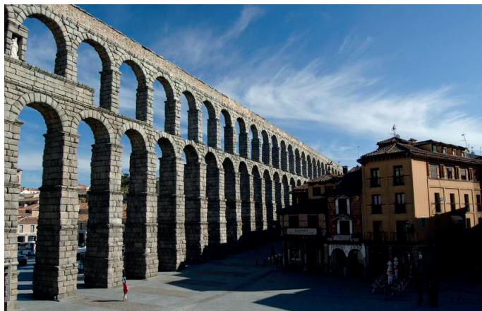
Fot. 5.3.30. Akwedukt w miejscowości Segovia, Hiszpania; [I.36]
