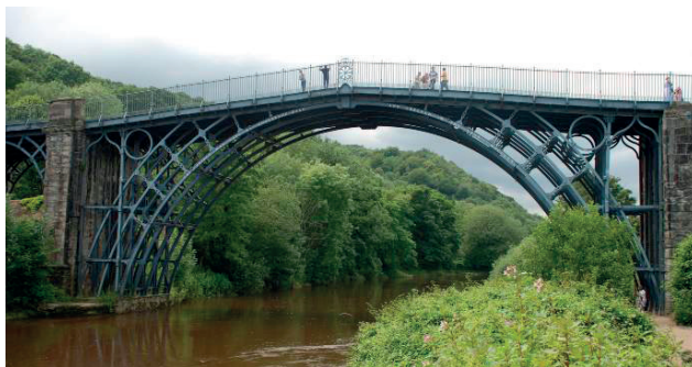
Fot. 5.3.33. Iron bridge przez rzekę Severn w Coalbrookdale (1779), Anglia; [I.39]
