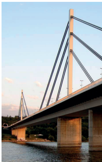
Fot. 7.1.6. a) Pylon zamocowany w dźwigarze głównym stojący na filarze o znacznie większym przekroju poprzecznym – wizualna smukłość pylonu wyraźnie maleje, Nowy Sad, Serbia; [Ł. Flaga] b) Pylon o kształcie funkcji e^x – wizualna smukłość zwiększona poprzez zachowanie ciągłości przebiegu sił do lustra wody, efekt potęgujący: zbliżenie do siebie ramion pylonu oraz zakończenie szczytu pylonu skosami, Nanjing, Chiny; [Ł. Flaga]
