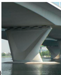
Fot. 5.3.42. Przykłady różnorodnych kształtów filarów żelbetowych, a) ZEA; b) Słowenia; c) USA; d) Rosja; [Ł. Flaga]
