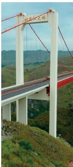
Fot. 5.3.39. Przykłady pylonów: a) ramowego, Chiny; b) skratowanego, Japonia; c) wieloramowego, USA; [I.46, I.47, I.48]
