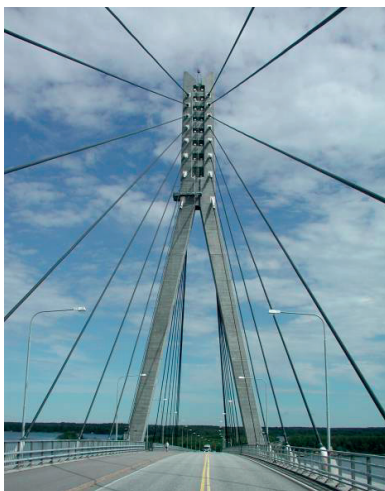
Fot. 7.1.2. Przykład żelbetowego pylonu Y-kształtnego w widoku od najazdu na most, Szwajcaria; [Ł. Flaga]
