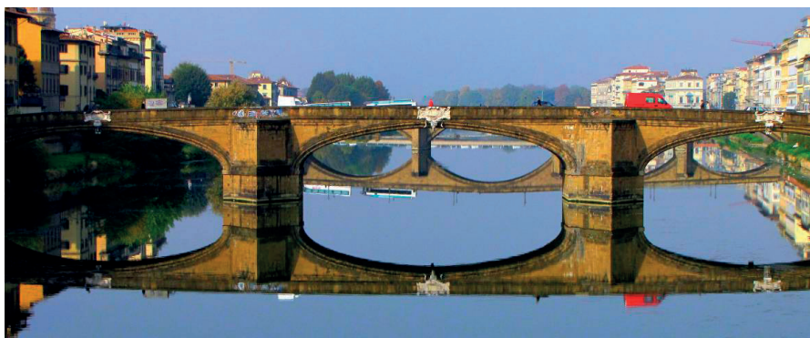
Fot. 5.3.20. Ponte Santa Trinita przez Arno we Florencji (1569), Włochy; [I.29]
