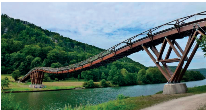
Fot. 5.3.7. Przykład kładki wstęgowej (dźwigary z drewna klejonego) przez kanał Ren-Men-Dunaj w Essing, Niemcy; [I.10]
