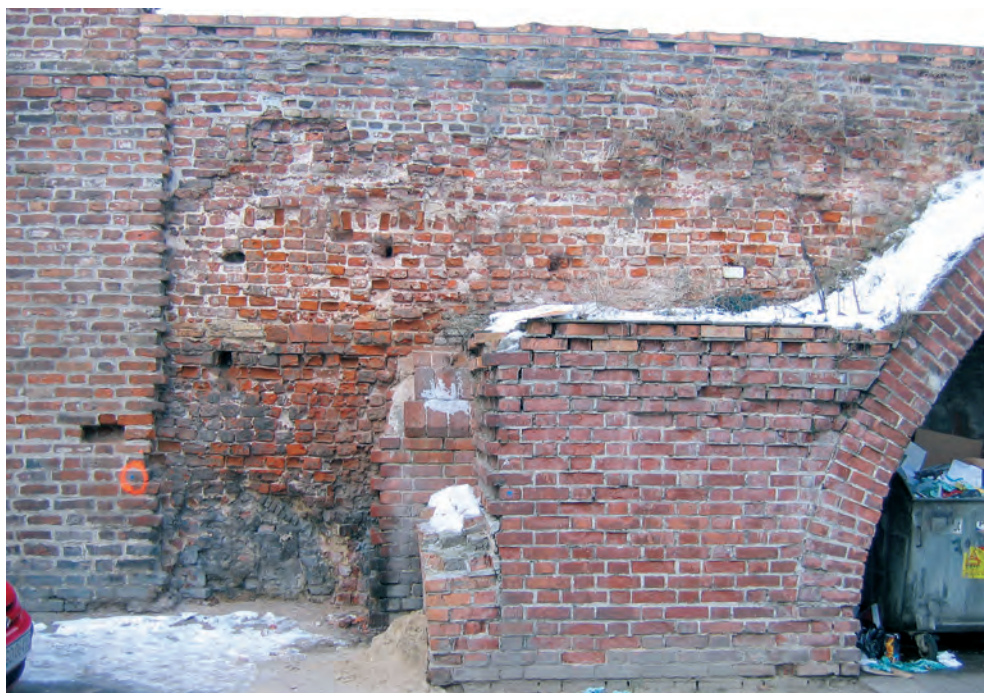
Fot. 6. Fragment muru obronnego po południowej stronie baszty Latarnianej z lewej strony lico odtworzone w latach 50., z prawej fragment arkad zrekonstruowanych w latach 70. XX w.
