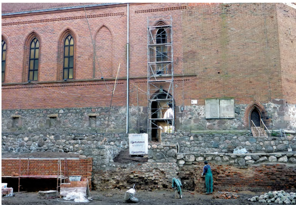
Fot. 4. Mur północne parhamu i brama zamku (2010).
