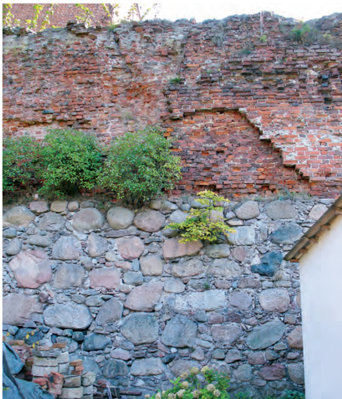
Fot. 5. Mur zachodni parchamu (fragment, 2008).
