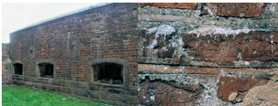
Fot. 6. Mur ceglany, Wrocław – Basteja Hioba; Gotycki wążek ceglany z malowanymi spoinami; Kamienne obramienia i boniowany cokół,
