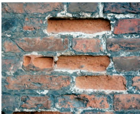
Fot. 15. Dezintegracja cegieł prawdopodobnie wywołana niszczącym działaniem bakterii nitryfikacyjnych
