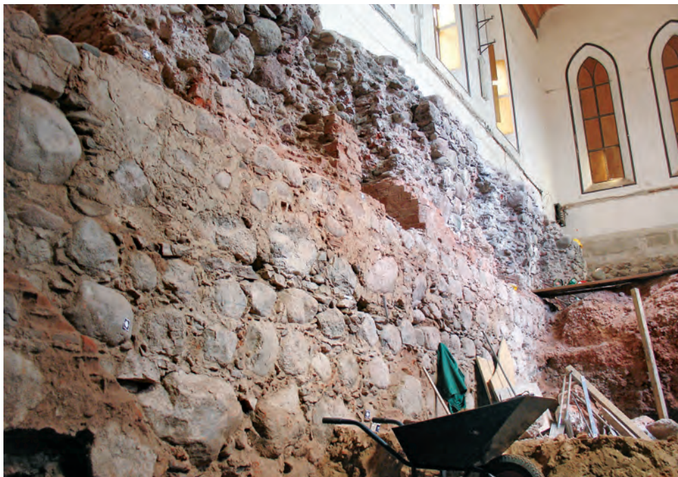
Fot. 3. Wnętrze piwnic i przyziemia skrzydła północnego. Powyżej widoczne mury dawnego kościoła.
