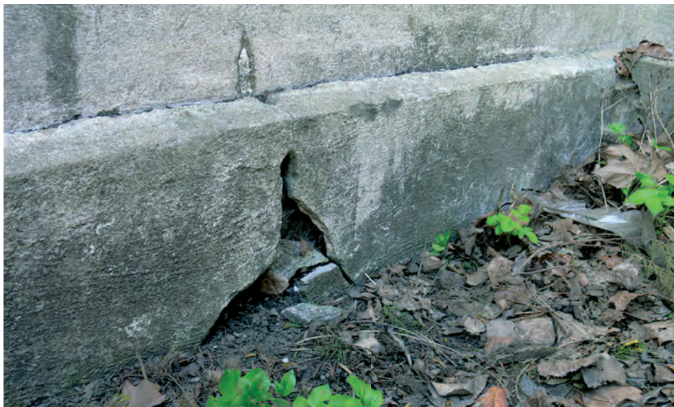
Fot. 20 W miejscu uszkodzenia widoczna jest przestrzeń wentylująca między odsadzką a murem. Fot. B. J. Rouba
