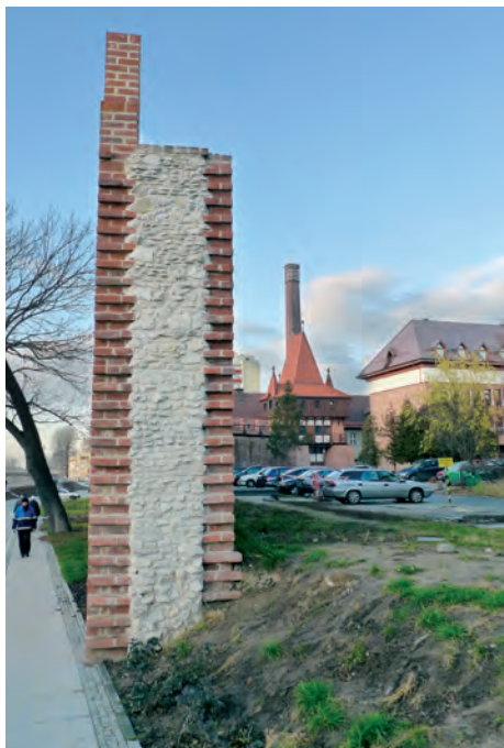
Fot. 7. Mur kamienno-ceglany z licem ceglany i rdzeniem z łamanego wapienia – Opole, miejski mur obronny z XIII w.
