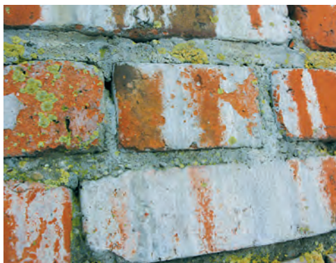
Fot. 4. Nawarstwienia zawierające sole trudnorozpuszczalne, głównie gips, węgiel, krzemian oraz glinian wapnia
