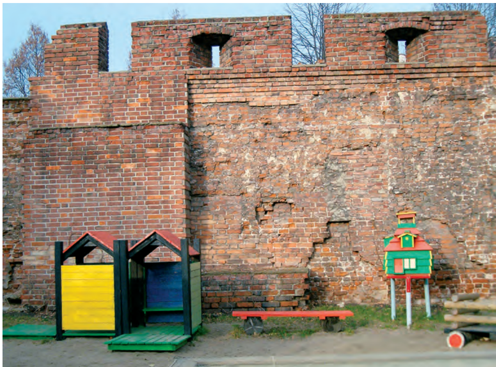
Fot. 3. Mur obronny ciągu północnego, po pracach konserwatorskich w latach 60. XX w. Zrekonstruowane blanki i fragment odsadzki murowej oraz zreperowana i zabezpieczona powierzchnia skutych partii muru.
