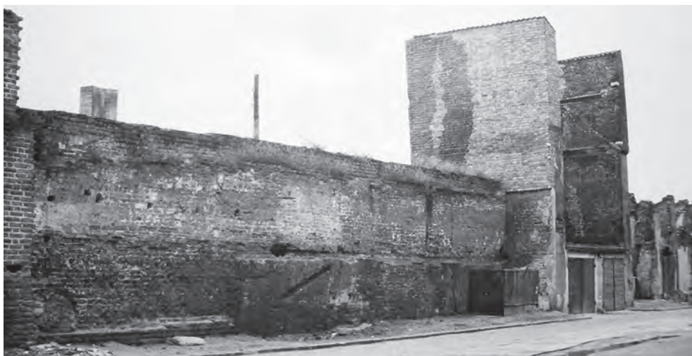
Fot. 2. Baszta Latarniana i mur obronny po pierwszym etapie odbudowy, widok około 1960 r., foto z archiwum WKZ w Gdańsku
