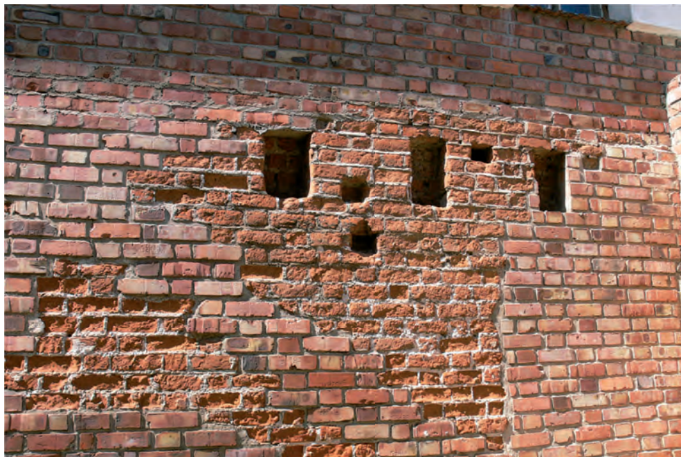
Fot. 12 Nowralgiczna ściana sali ze sprzętem oświetleniowym – od strony zewnętrznej. Fot. B. J. Rouba
