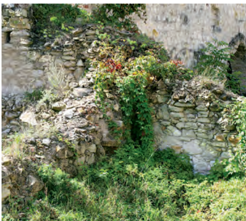
Rys. 16. Porastanie korony murów roślinami zielonymi.
