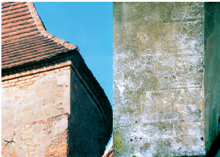
Fot. 9. Mury tynkowane przykłady: narożne bonie z tynku, bonie rytowane,
