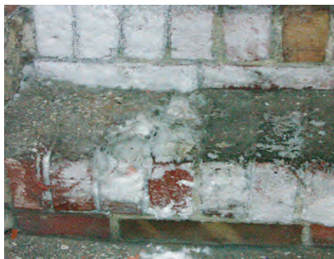
Fot. 3. Nawarstwienia zawierające sole rozpuszczalne w wodzie
