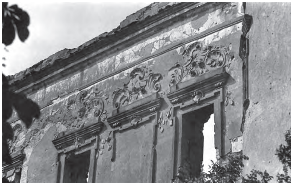
Fot. 1. Fragmenty dekoracji w części pd.-zach. zamku w Janowcu stan - przed 1995 (Fot. Zbiory Działu Dokumentacji i Biblioteki Muzeum Nadwiślańskiego w Kazimierzu Dolnym)
