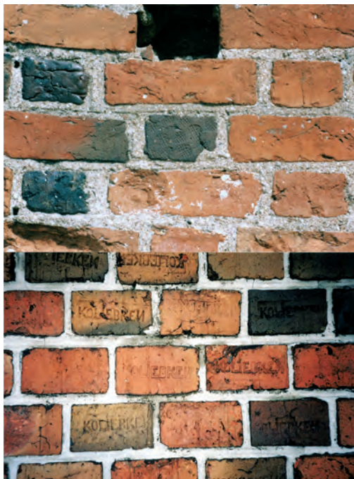
Fot. 8. Przykłady wątków ceglanych – średniowieczny wąż polski; nowożytny wąż główkowy
