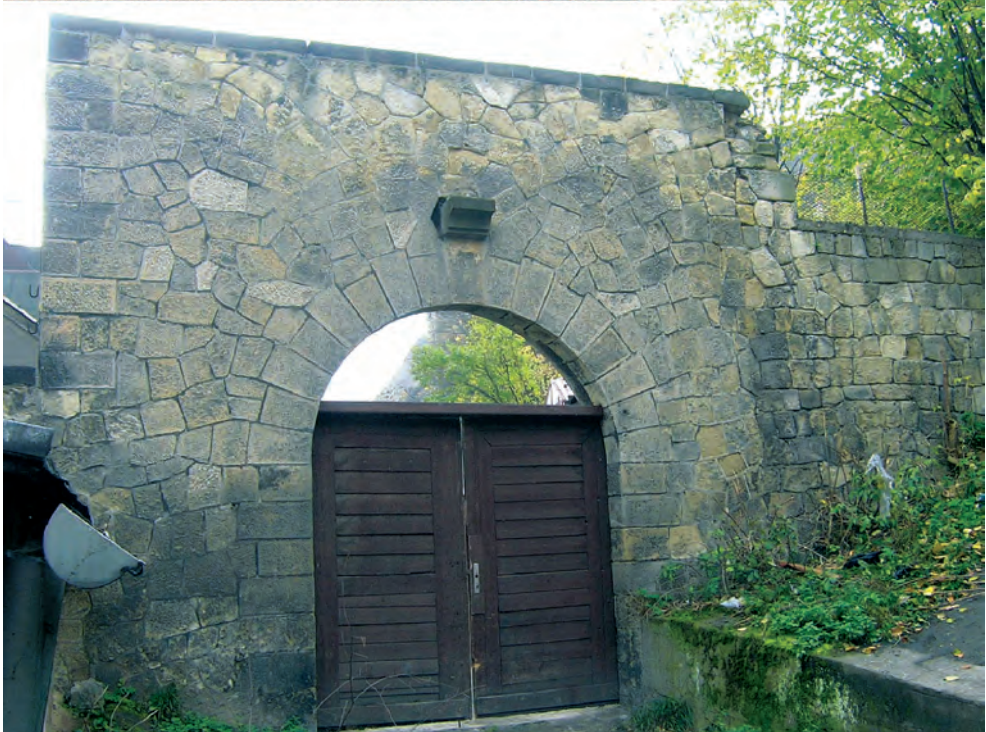
Fot. 3. Troja, mur kamienny ciosowy; Kłodzko – twierdza mur kamienny (XIX w.) z oblicówką cyklopową,
