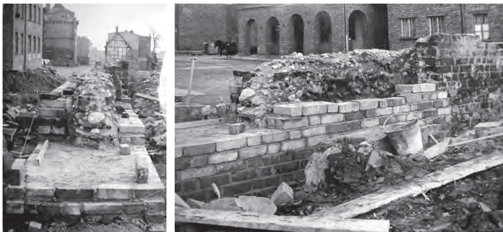
Fot. 1. Prace przy rekonstrukcji lica muru obronnego południowego ciągu Głównego Miasta po II wojnie światowej, foto z archiwum Wojewódzkiego Konserwatora Zabytków w Gdańsku
