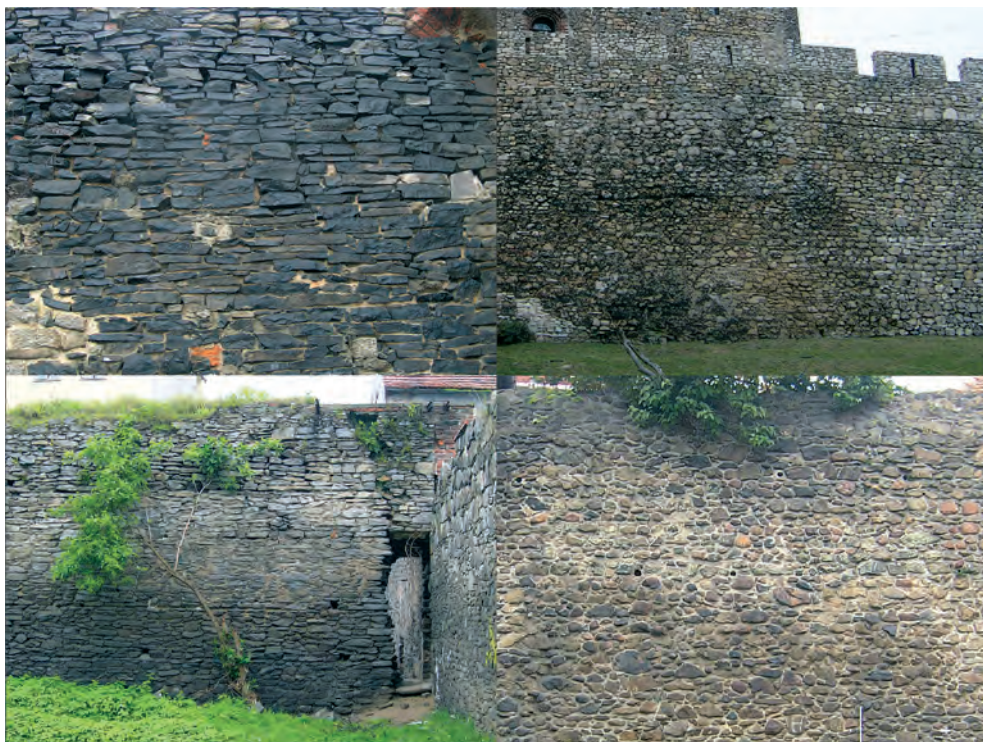
Fot. 2. Mury kamienne: Strzegom – mur bazaltowy, kamień łamany sortowany (XIII w.); Będzin – mur mur wapienny, kamień łamany sortowany, układany z warstwami wyrównawczymi (XIV w.); Strzelin – mur granitowy, kamień łamany sortowany (XIII w.); Świebodzice – mur dziki, kamień narzutowy i łamany (XIII, XIV w.)
