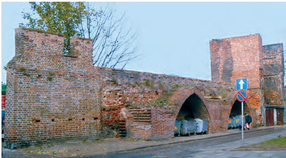
Fot. 4. Mur obronny po południowej stronie baszty Latarnianej z licem i blankami odtworzonymi w latach 50. i arkady zrekonstruowane w latach 70. XX w. W głębi baszta Latarniana, stan obecny, fot autor
