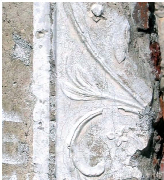
Fot .3. Widok nielicznych powierzchni z zachowaną sztukaterią w części pd.-zach. zamku w Janowcu
