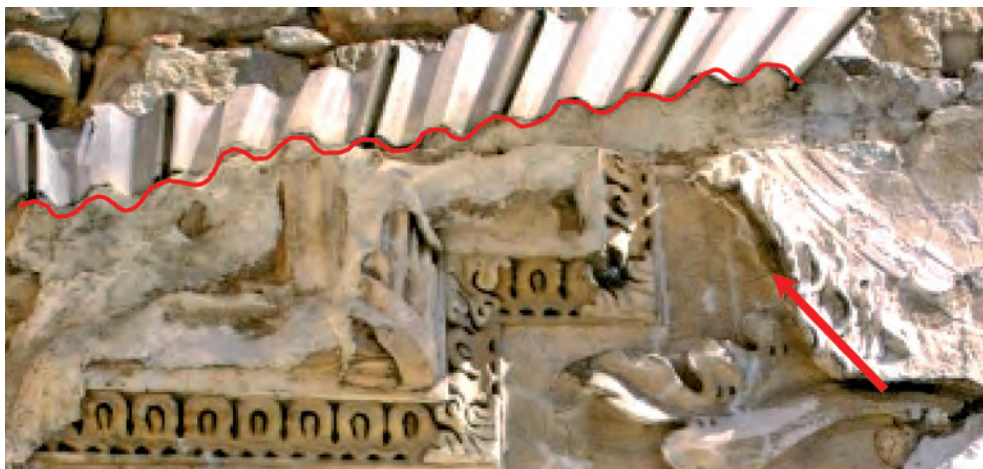
Fot. 8. Przykład zabezpieczenie trwałego relikwów dekoracji sztukatorskiej skrzydła zach. „Daszek” z tworzywa komórkowego TEKPOL z zamocowanego do rusztu od góry wraz z uszczelnieniem – stan po pracach konserwatorskich
